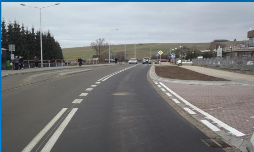
Ul. Szpitalna po wykonaniu przebudowy
