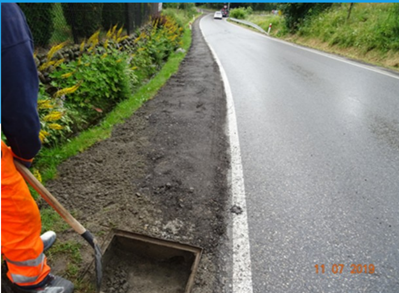
Fot. Uzupełnianie poboczy na sieci dróg
