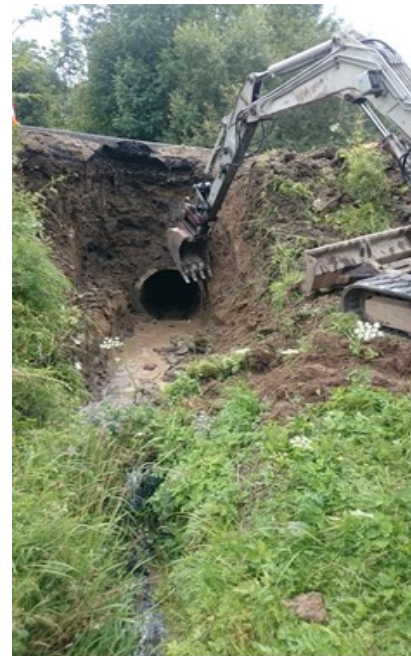
Fot. Odbudowy wlotów i wylotów przepustów drogowych
