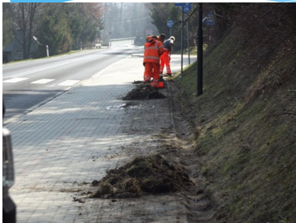
Fot. Czyszczenie nawierzchni jezdni, chodników i mostów w okresie letnim
