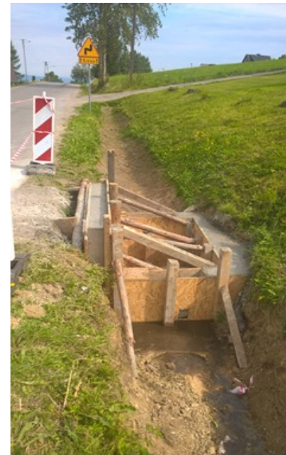
Fot. Wykonanie umocnienia wlotu przepustu
