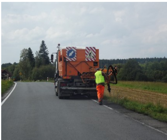
Fot. Remont i uzupełnienie ubytków poboczy
