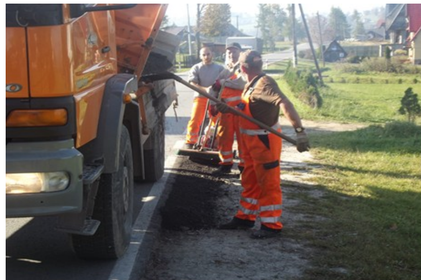
Fot. Uzupełnianie poboczy na sieci dróg
