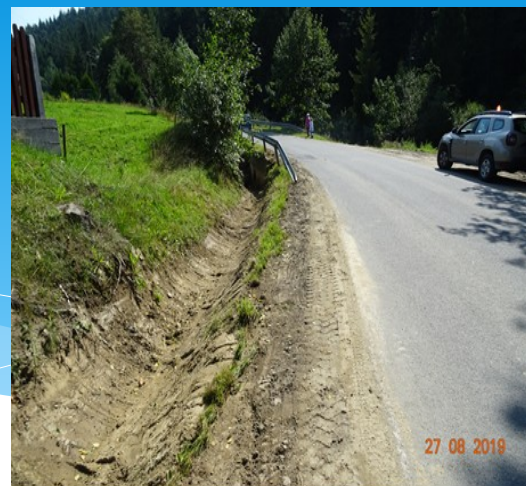
Fot. odtworzenie i oczyszczenie rowów odwadniających
