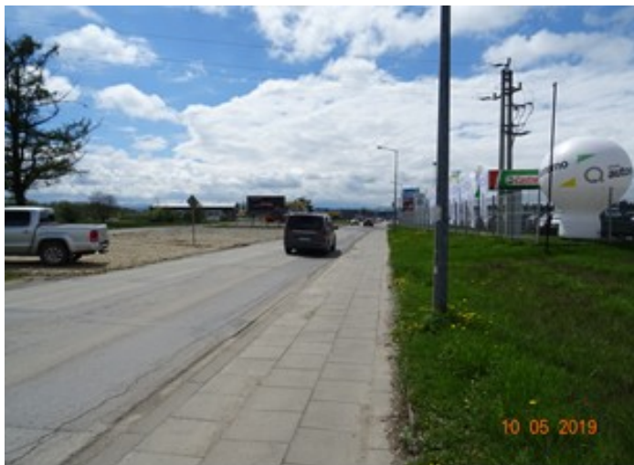
Fot. Droga powiatowa nr 1672K – przed realizacją zadania
