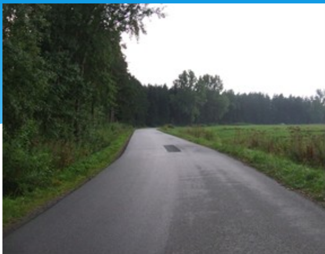
Fot. Droga powiatowa nr 1645K – przed realizacją zadania
