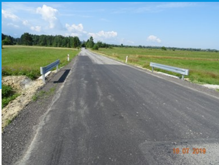
Fot. Remont przepustu wraz z uzupełnieniem nawierzchni z mas bitumicznych
