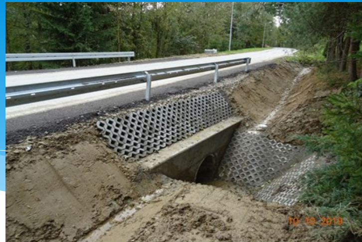
Fot. Wykonanie umocnienia wlotu przepustu
