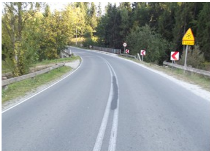
Fot. Droga powiatowa nr 1638K – przed realizacją zadania
