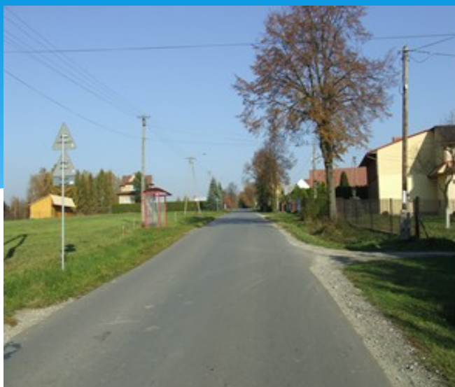
Fot. Droga powiatowa nr 1668K – przed realizacją zadania
