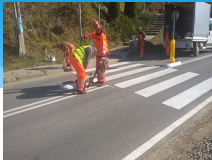
Fot. Wykonanie oznakowania poziomego na drogach powiatowych
