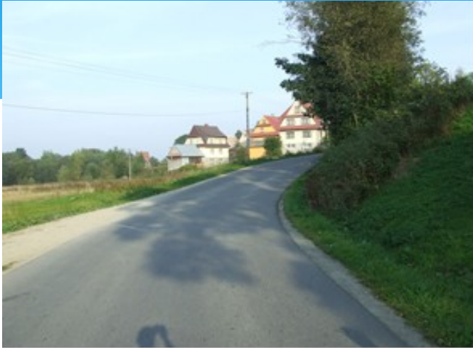
Fot. Droga powiatowa nr 1646K – przed realizacją zadania
