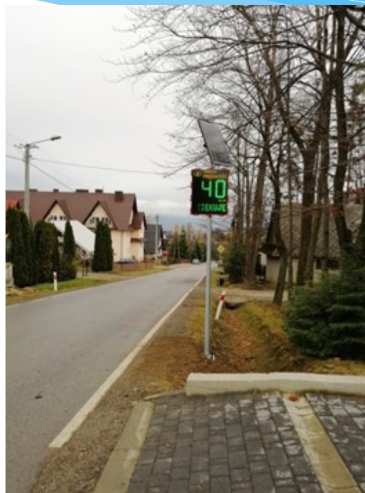
Fot. Umieszczenie radarowych wyświetlaczy prędkości w miejscowości Szaflary i Bańska Wyżna
