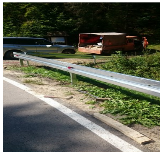
Fot. Wymiana, ustawienie stalowych barier ochronnych
