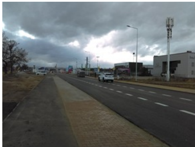
Fot. Droga powiatowa nr 1672K – po zrealizowaniu zadania
