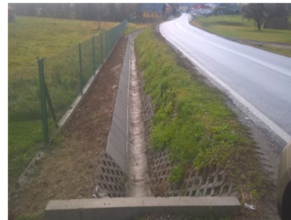
Fot. Czyszczenie korytek ściekowych
