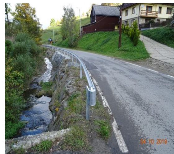
Fot. Odbudowa korpusu drogi
