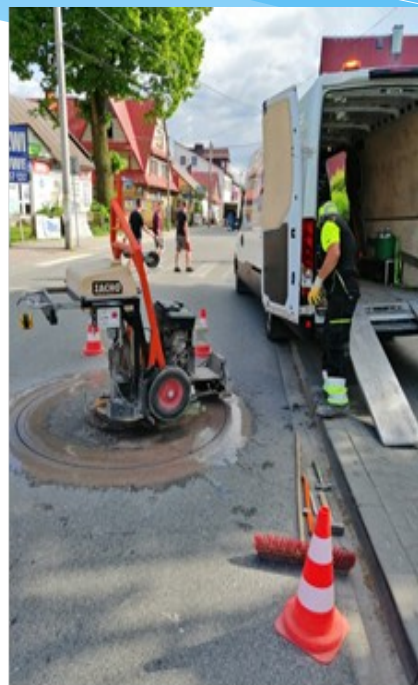
Fot. Regulacja wysokościowa i wymiana włączów kanałowych
