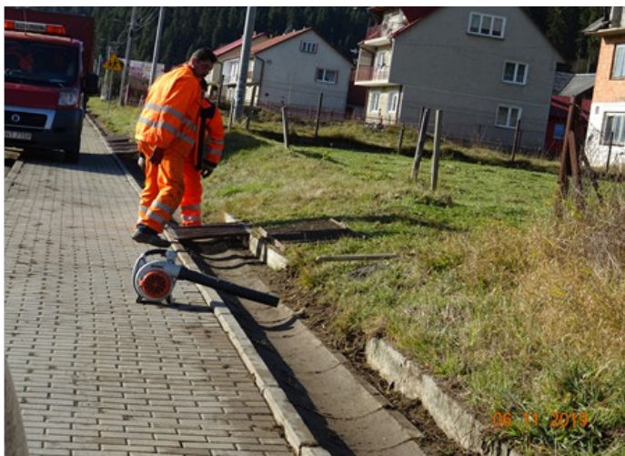
Fot. Renowacja i oczyszczenie elementów odwodnienia
