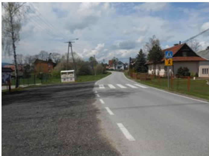
Fot. Droga powiatowa nr 1665K – przed realizacją zadania
