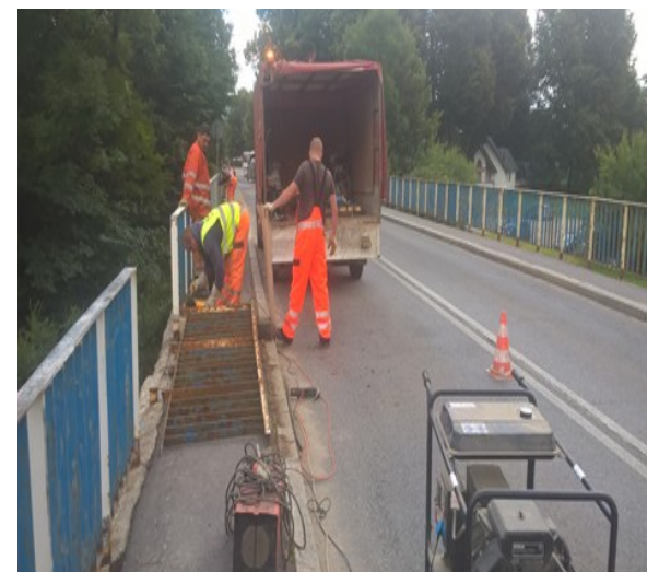
Fot. Naprawa barier na obiektach mostowych
