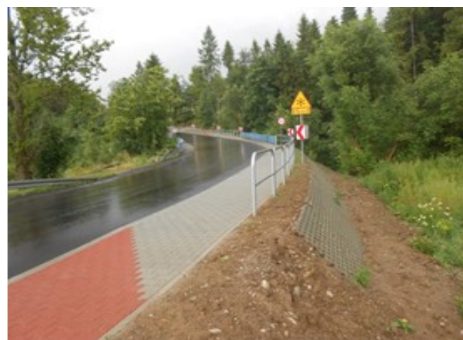
Fot. Droga powiatowa nr 1638K – po zrealizowaniu zadania
