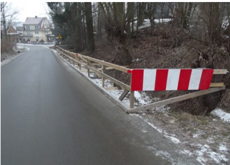
Fot. Zabezpieczenie miejsc niebezpiecznych – oberwany korpus drogi w m. Pyzówka
