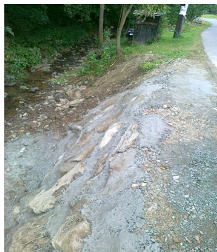
Fot. Odbudowa korpusu drogi
