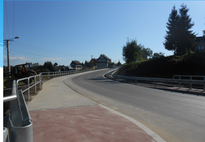
Fot. Droga powiatowa nr 1646K – po zrealizowaniu zadania
