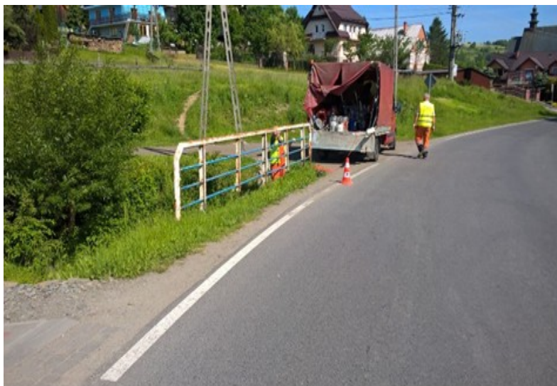
Fot. Malowanie barier ochronnych na obiektach mostowych
