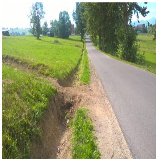
Fot. odtworzenie i oczyszczenie rowów odwadniających
