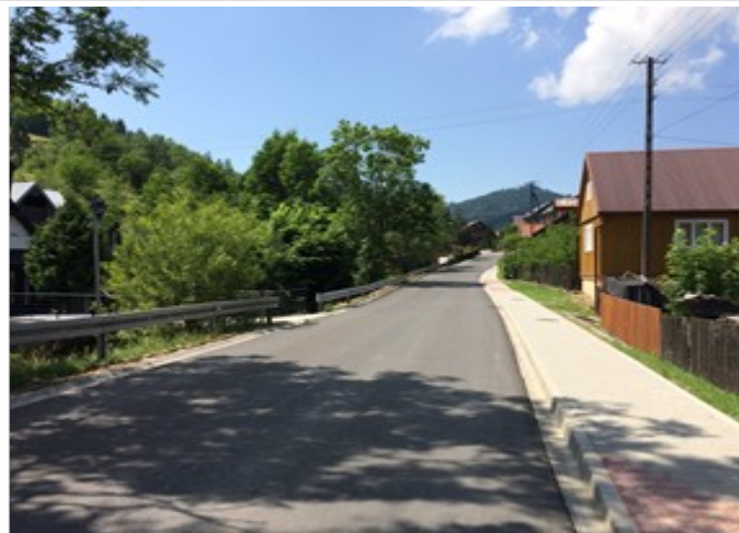
Fot. Droga powiatowa nr 1637K Ochotnica Górna – po zrealizowaniu zadania
