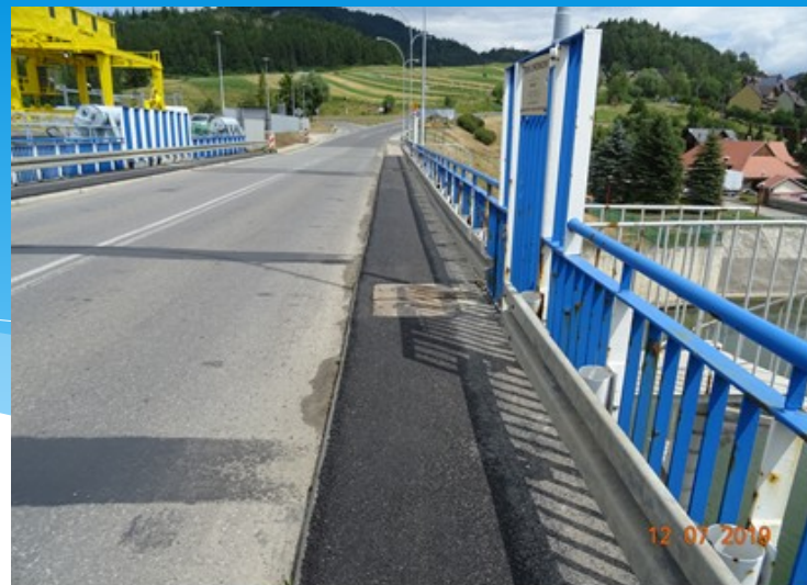
Fot. Remont kap chodnikowych na obiekcie mostowym
