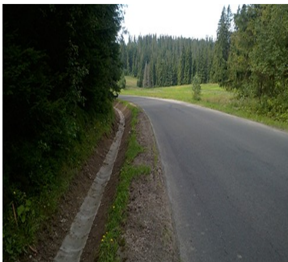
Fot. odtworzenie i oczyszczenie rowów odwadniających
