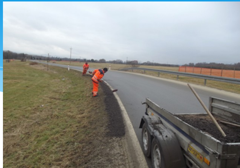
Fot. Uzupełnianie poboczy na sieci dróg
