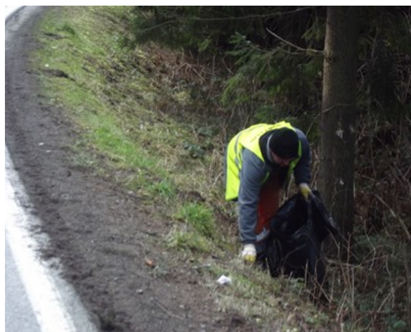
Fot. Oczyszczenie pasa drogowego – podczas wykonywania robót
