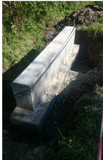
Fot. Odbudowy wlotów i wylotów przepustów drogowych
