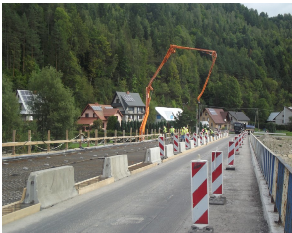
Fot. „Remont mostu na potoku Ochotnica w ciągu drogi powiatowej nr 1637K Harkłowa – Tylmanowa w km 21+459 w miejscowości Ochotnica Dolna” – w trakcie realizacji
