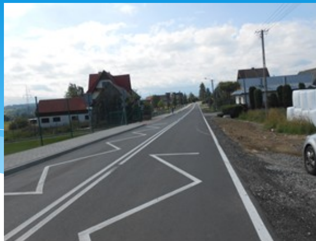
Fot. Droga powiatowa nr 1653K – po zrealizowaniu zadania
