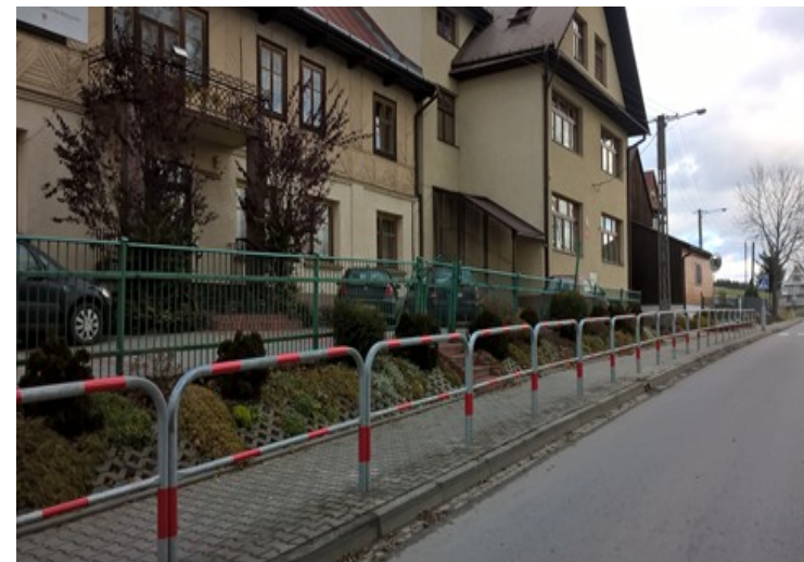
Fot. Wymiana barierek ochronnych w rejonie szkół
