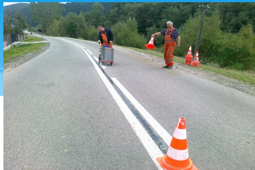
Fot. Zalewanie pęknięć nawierzchni masą na gorąco
