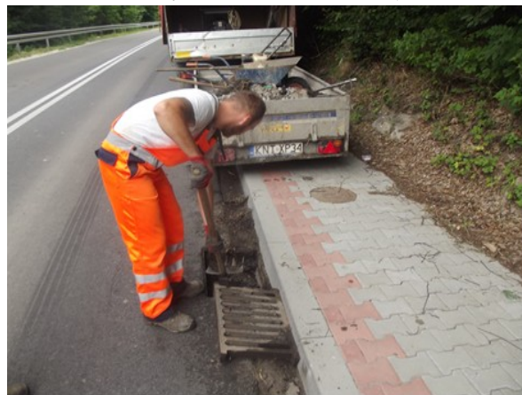
Fot. Czyszczenie korytek ściekowych
