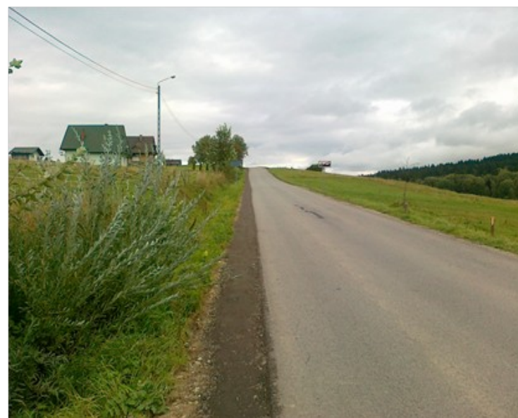
Fot. Remont i uzupełnienie ubytków poboczy
