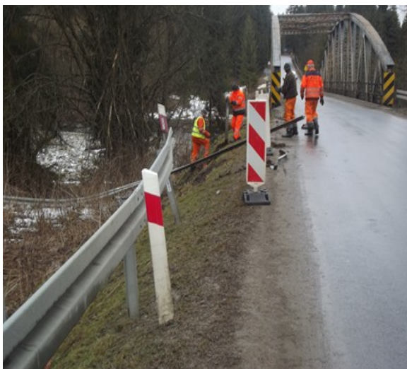
Fot. Naprawa barier energochłonnych
