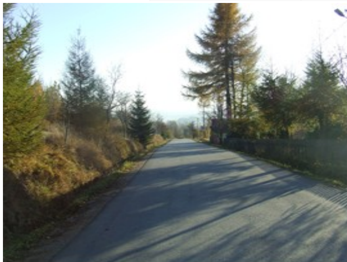
Fot. Droga powiatowa nr 1677K – przed realizacją zadania
