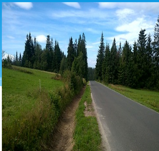
Fot. odtworzenie i oczyszczenie rowów odwadniających
