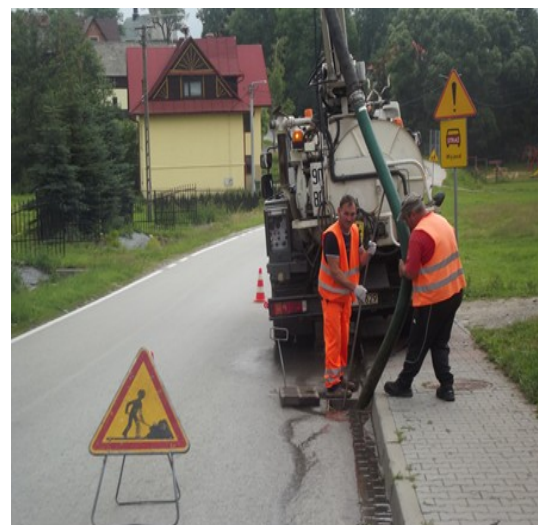
Fot. Czyszczenie kanalizacji deszczowej wraz z kratkami i przykanalikami na całej sieci dróg powiatowych
