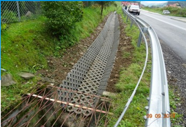
Fot. Wykonanie umocnienia rowu przydrożnego
