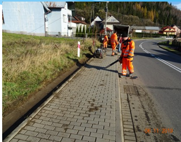
Fot. Czyszczenie nawierzchni jezdni, chodników i mostów w okresie letnim
