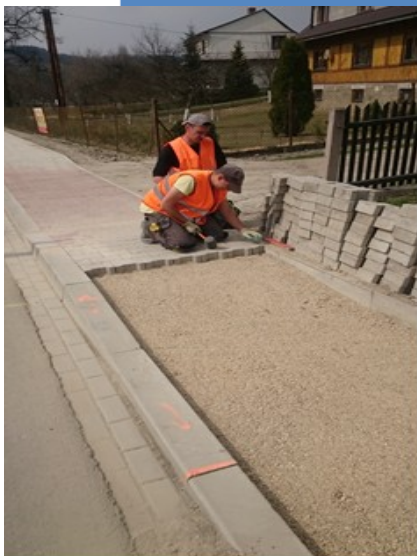
Fot. Wykonanie, wymiana nawierzchni chodnika z elementów betonowych
