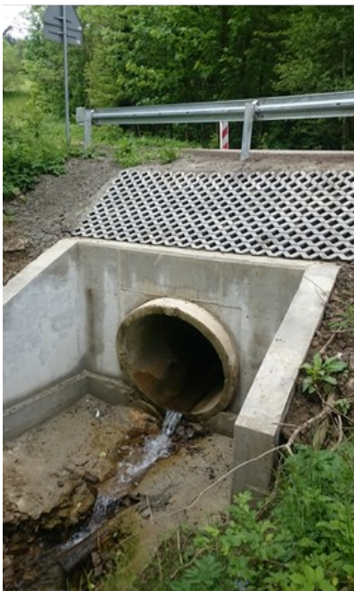
Fot. Wykonanie umocnienia rowu przydrożnego
