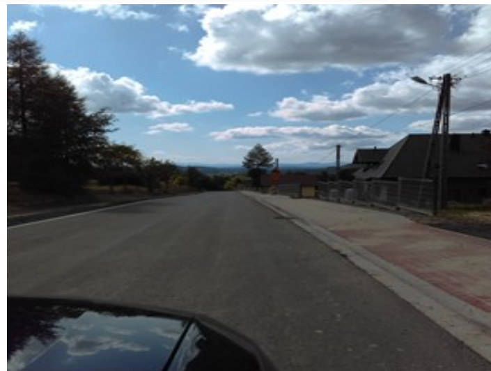
Fot. Droga powiatowa nr 1677K – po zrealizowaniu zadania
