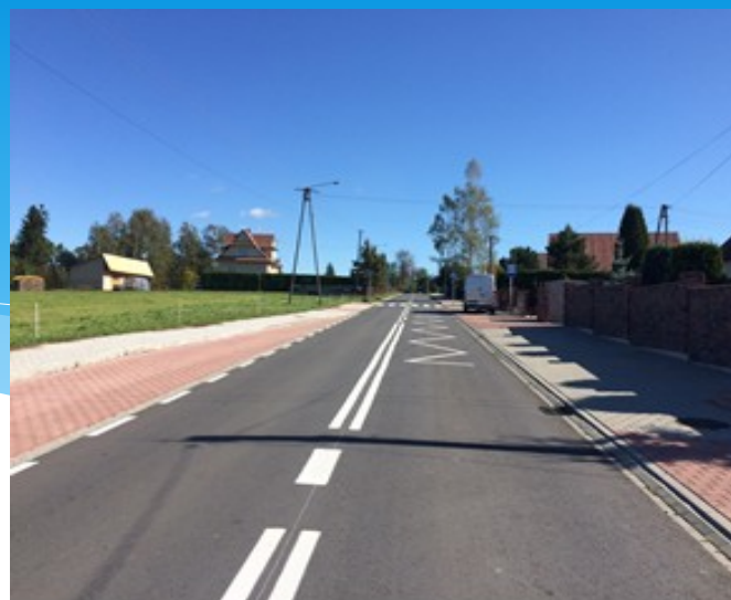
Fot. Droga powiatowa nr 1668K – po zrealizowaniu zadania
