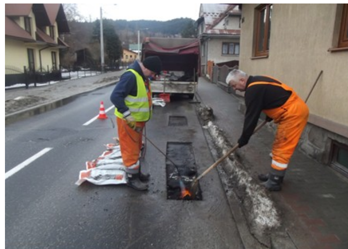
Fot. Remont nawierzchni masą na zimno
