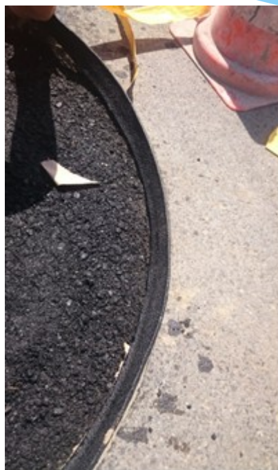
Fot. Regulacja wysokościowa i wymiana włączów kanałowych
