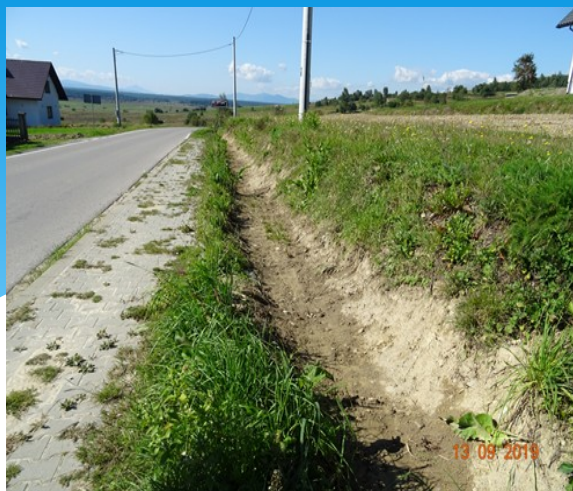
Fot. odtworzenie i oczyszczenie rowów odwadniających
