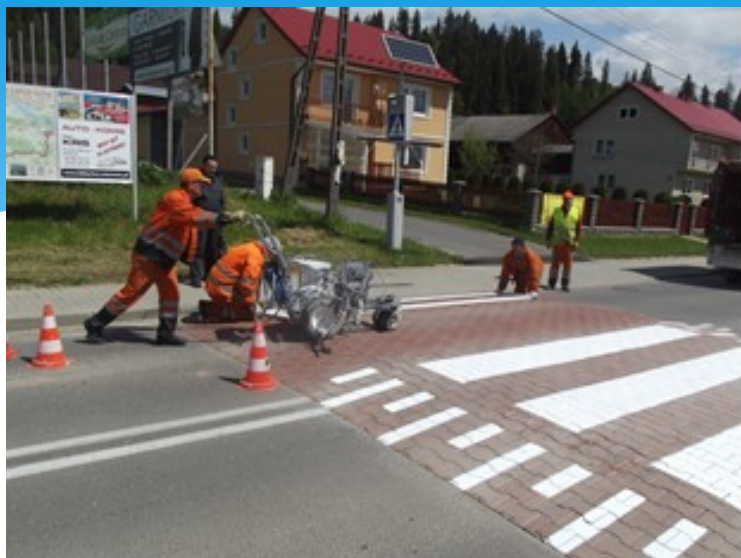
Fot. Wykonanie oznakowania poziomego na drogach powiatowych
