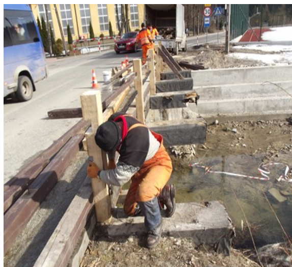
Fot. Naprawa barier na obiekcie mostowym
