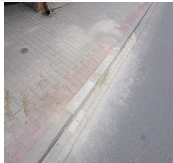
Fot. wymiana zniszczonych elementów chodnika – po wykonaniu prac
