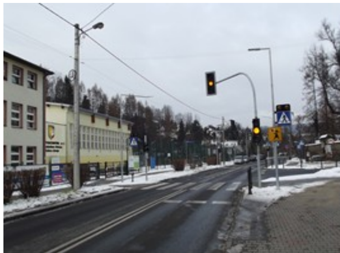
Fot. Po zrealizowaniu zadania – doświetlenie przejść w Rabce -Zdrój w km 1+495
