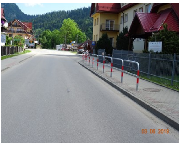
Fot. Wykonanie i wymiana barierek ochronnych w rejonie szkół
