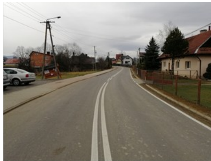
Fot. Droga powiatowa nr 1665K – po zrealizowaniu zadania
