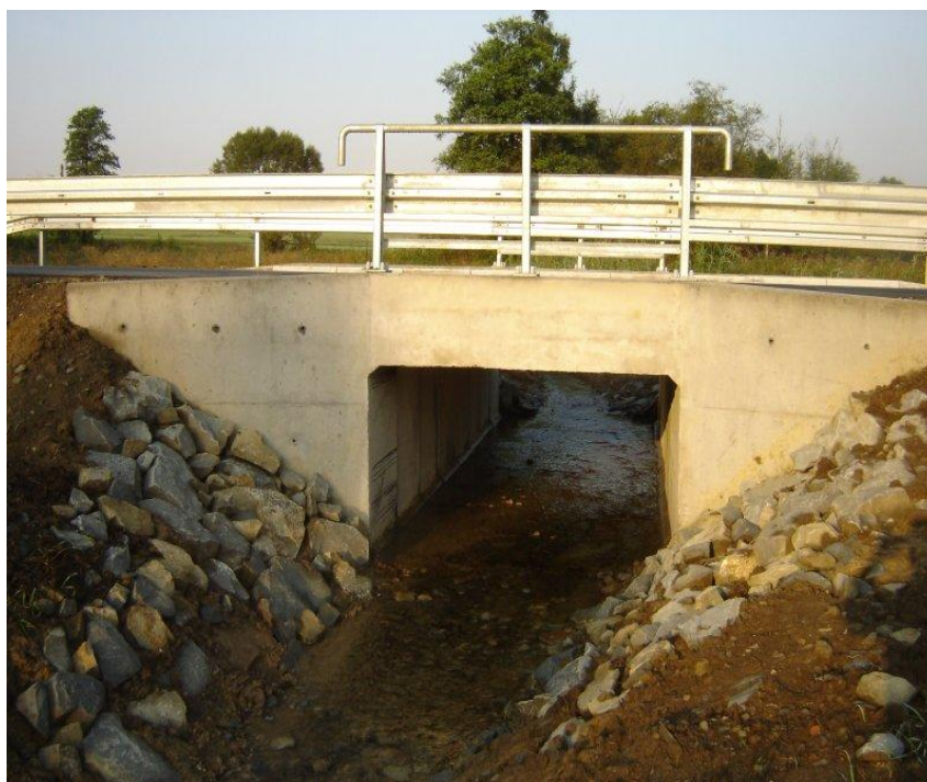
fot. Remont mostu na potoku bez nazwy w km 7+850 w c/d powiatowej nr K1669 Jordanów-Spytkowice
