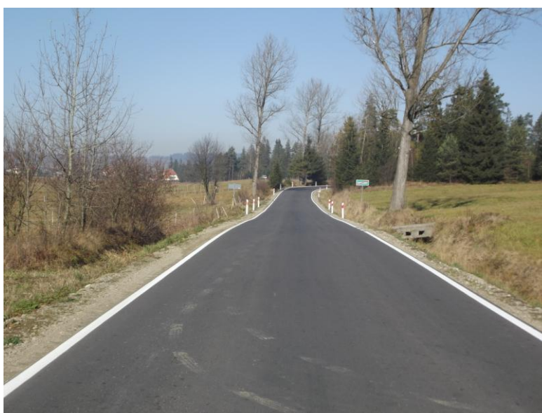
fot. droga K1660 Ludźmierz – Pyzówka po przebudowie
