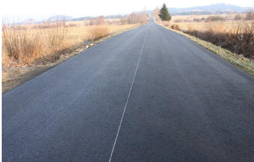
fot. Remont nawierzchni drogi powiatowej numer K1642 Groń-Trybsz- Niedzica od km 0+000 do km 5+050
