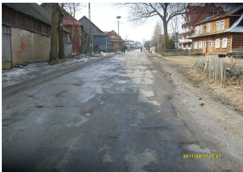
fot. K1663 Długopole – Pieniążkowie – Piekielnik przed przebudową
