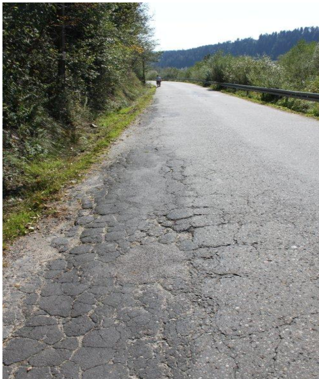
fot. droga K1638 Krośnica – Sromowce N. przed przebudową
