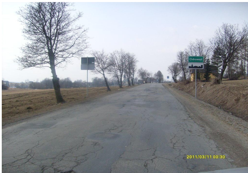
fot. K1663 Długopole – Pieniążkowice – Piekelnik przed przebudową
