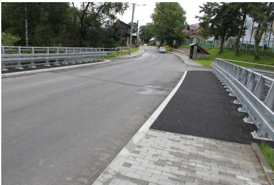
fot. obiekt mostowy K1642 Groń – Trybsz – Niedzica w km 3+770 na Czarnogórskiej Rzece po przebudowie
