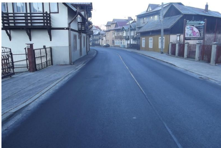
fot. odcinek drogi K1636 Krościenko – Szczawnica po przebudowie
