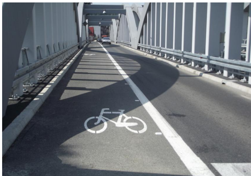
fot. obiekty mostowe po przebudowie w m. Krościenko n/D
