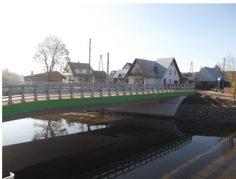
fot. obiekt mostowy w/c K1659 w Ludźmierzu po przebudowie
