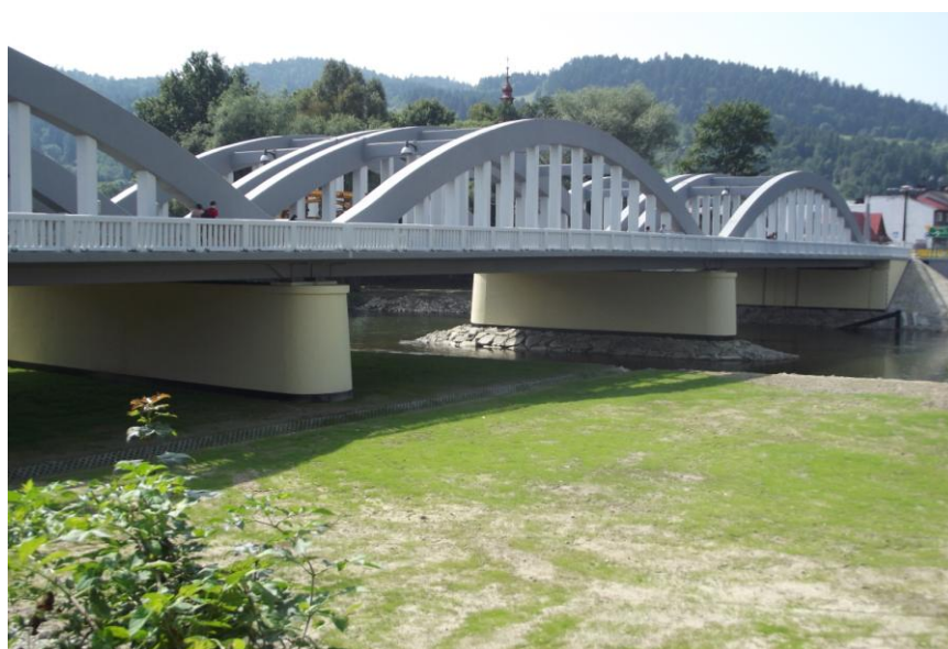
fot. obiekty mostowe po przebudowie w m. Krościenko n/D
