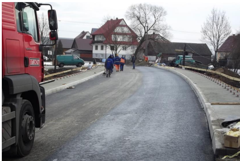
fot. obiekt mostowy podczas przebudowy nr K1660 Ludźmierz – Pyzówka w km 2+780
