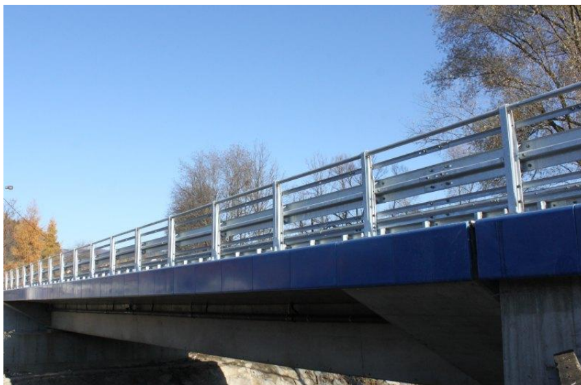
fot. Obiekt mostowy po odbudowie
