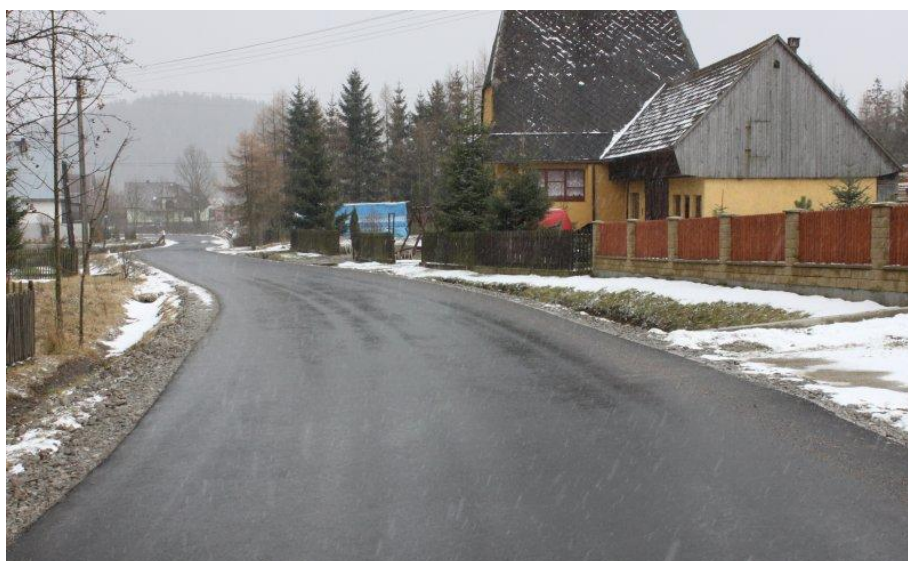
fot. droga K1676 Lipnica Wielka – Przywarówka po przebudowie
