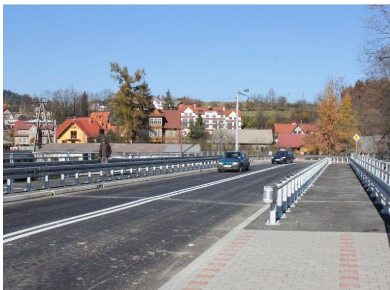
fot. Obiekt mostowy po odbudowie
