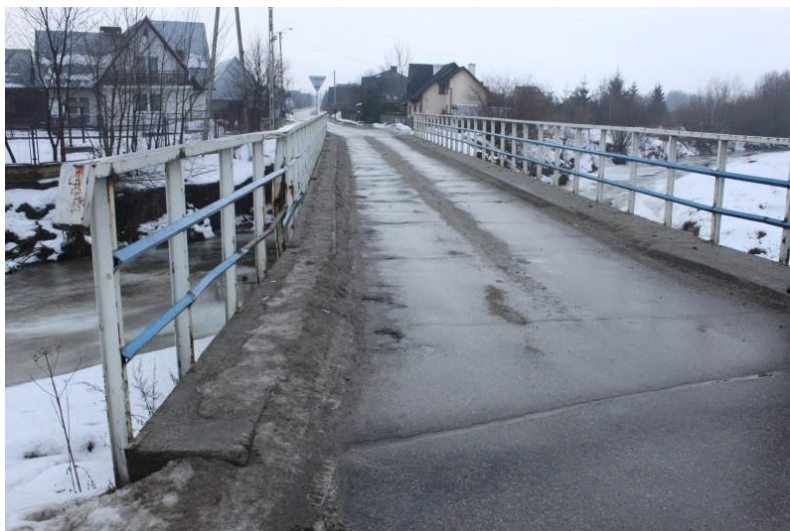
fot. obiekt mostowy w/c K1659 w Ludźmierzu przed przebudową
