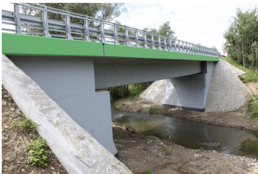
fot. obiekt mostowy K1668 Rabka – Skawa – Naprawa w km 7+670 na rzece Skawa po przebudowie
