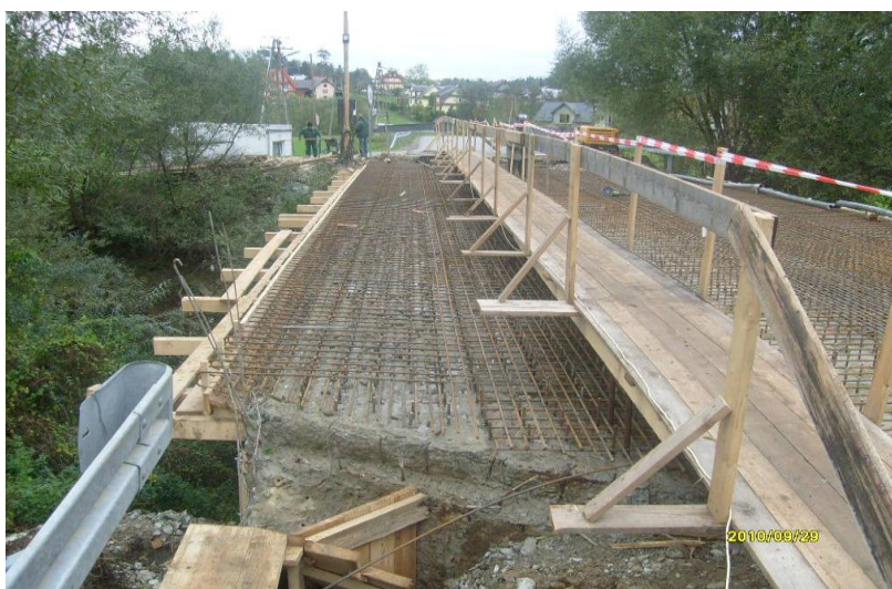
fot. obiekt mostowy w trakcie przebudowy K1668 Rabka – Skawa – Naprawa w km 5+582 na rzece Skawa
