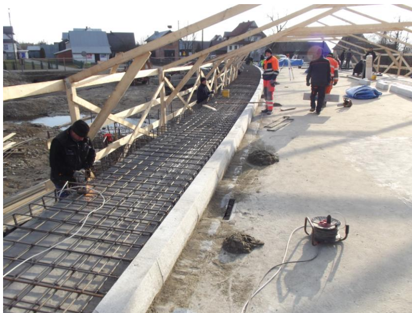
fot. obiekt mostowy podczas przebudowy K1660 Ludźmierz – Pyzówka w km 2+780
