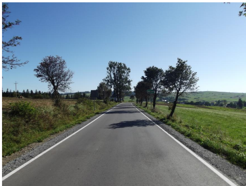
fot. K1663 Długopole – Pieniążkowice – Piekelnik po przebudowie
