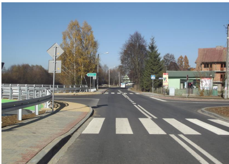
fot. droga K1660 Ludźmierz – Pyzówka po przebudowie
