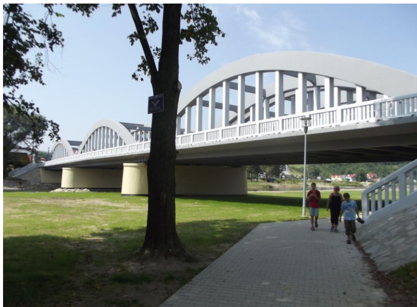
fot. obiekty mostowe po przebudowie w m. Krościenko n/D
