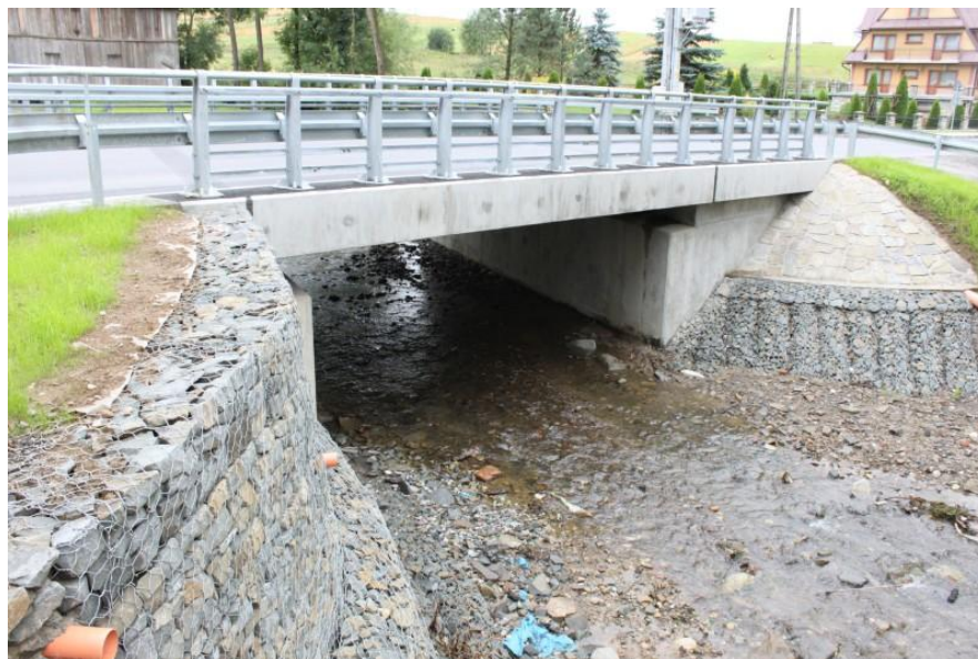
fot. obiekt mostowy K1642 Groń – Trybsz – Niedzica w km 3+770 na Czarnogórskiej Rzece po przebudowie
