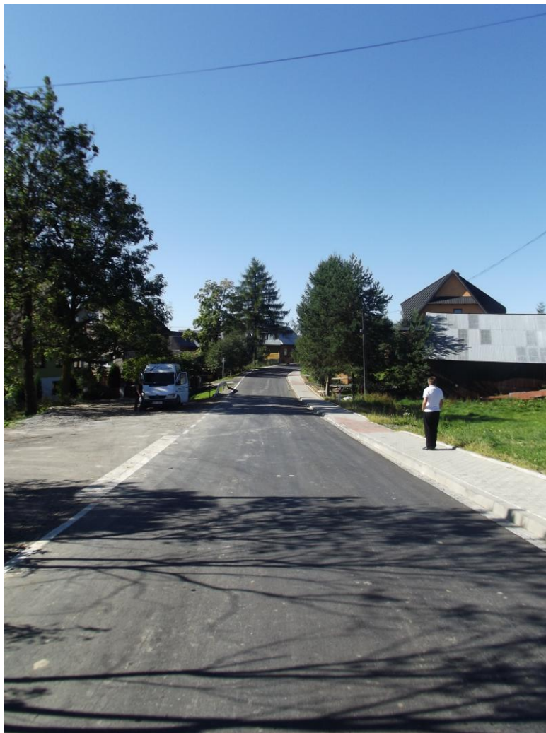
fot. K1663 Długopole – Pieniążkowie – Piekielnik po przebudowie
