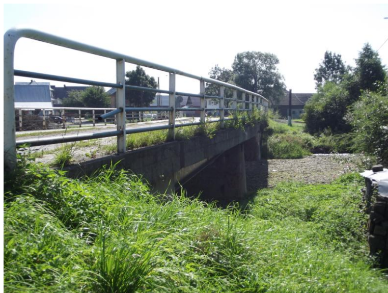
fot. obiekt mostowy przed przebudową K1660 Ludźmierz – Pyzówka w km 2+780
