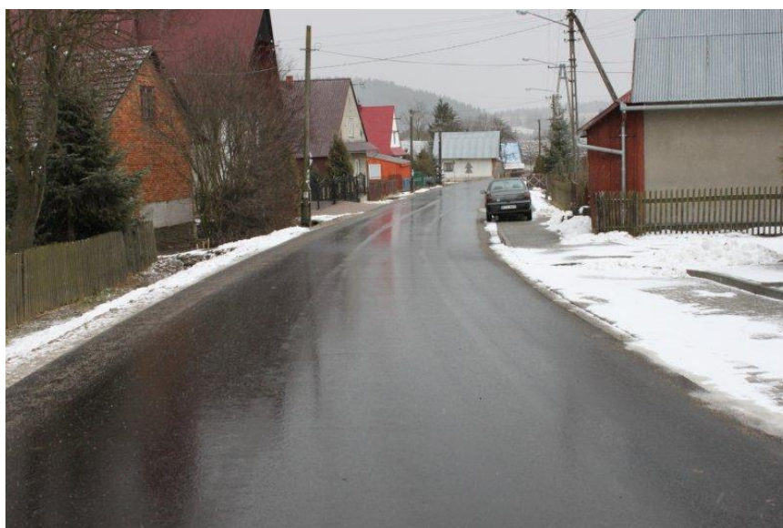
fot. droga K1676 Lipnica Wielka – Przywarówka po przebudowie
