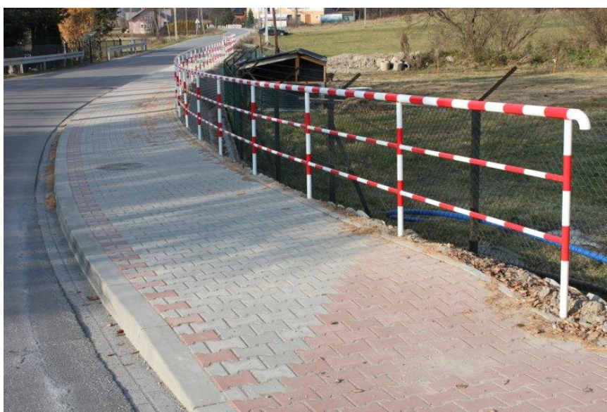
fot. droga K1668 Rabka – Skawa - Naprawa po przebudowie
