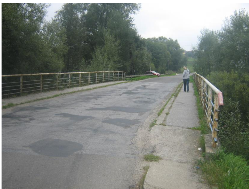
fot. obiekt mostowy przed przebudową K1668 Rabka – Skawa – Naprawa w km 5+582 na rzece Skawa
