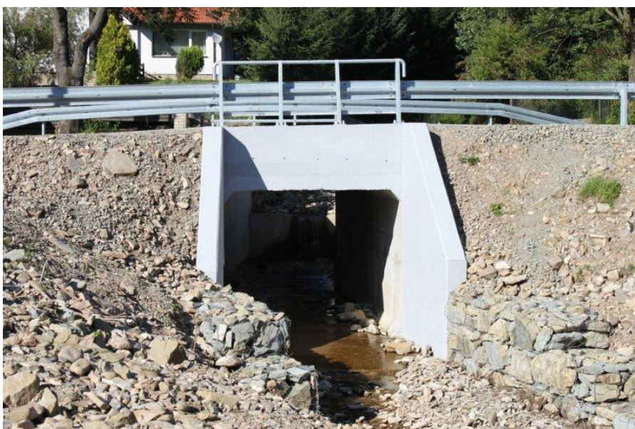
fot. Remont przepustu w km 1+100 w c/d powiatowej nr K1636 Krościenko-Szczawnica
