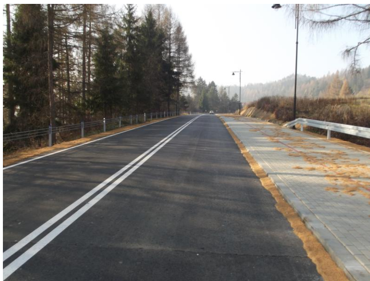
fot. K1639 Dębno – Niedzica – Gr. Państwa po przebudowie
