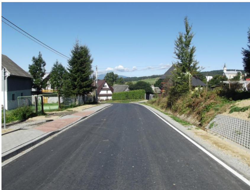
fot. K1663 Długopole – Pieniążkowie – Piekelnik po przebudowie
