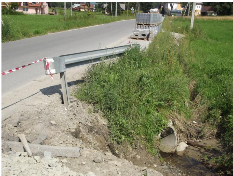
fot. droga K1668 Rabka – Skawa - Naprawa przed przebudową – przepust.
