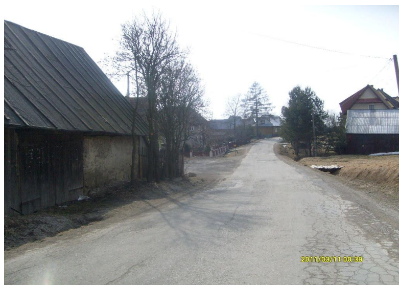
fot. K1663 Długopole – Pieniążkowice – Piekelnik przed przebudową
