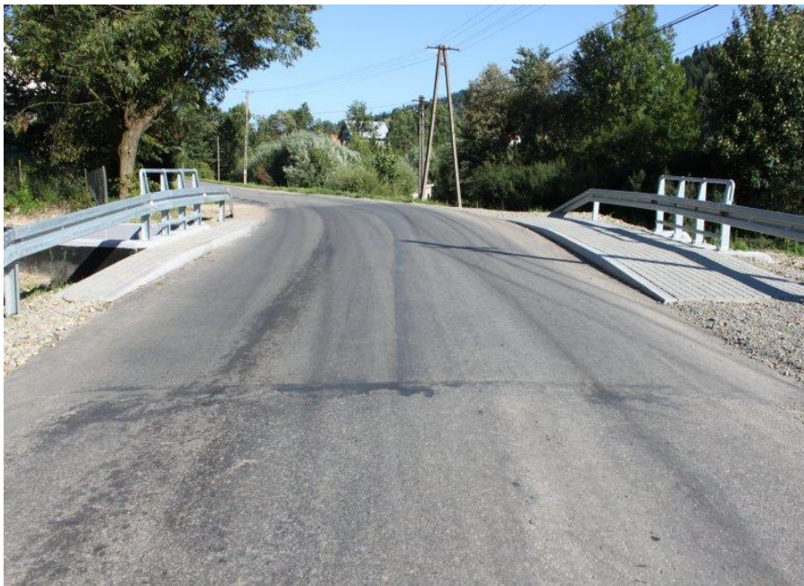
fot. Remont przepustu w km 1+100 w c/d powiatowej nr K1636 Krościenko-Szczawnica
