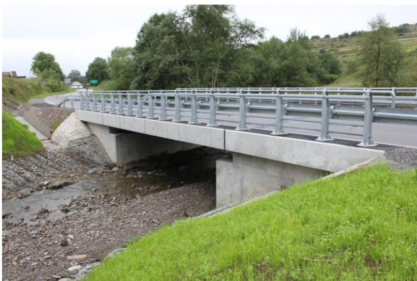
fot. obiekt mostowy K1642 Groń – Trybsz – Niedzica w km 5+050 na Trybskiej Rzece po przebudowie
