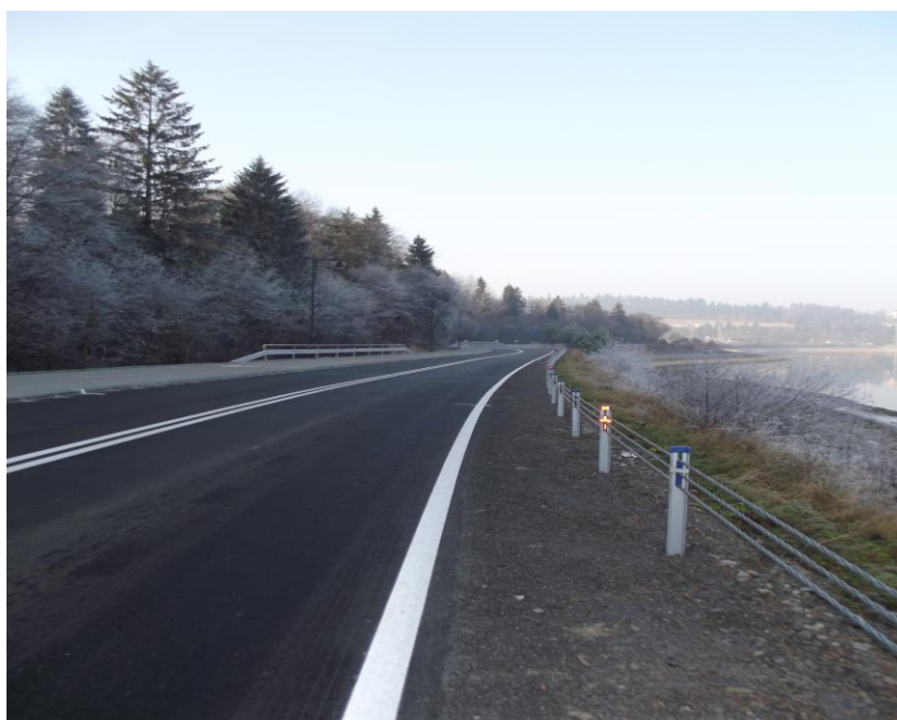
fot. K1639 Dębno – Niedzica – Gr. Państwa po przebudowie
