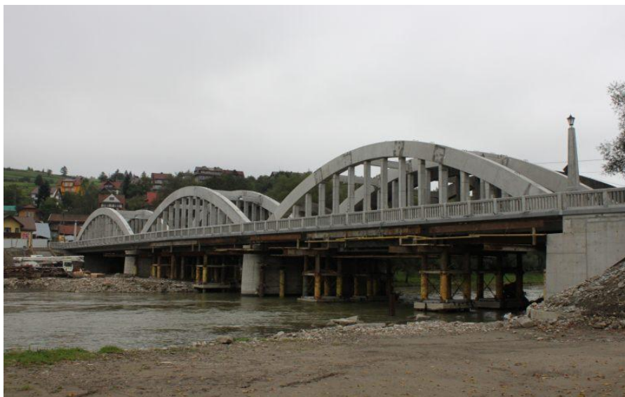
fot. obiekty mostowe podczas przebudowy w m. Krościenko n/D
