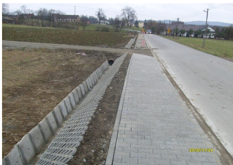
fot. droga K1668 Rabka – Skawa - Naprawa po przebudowie
