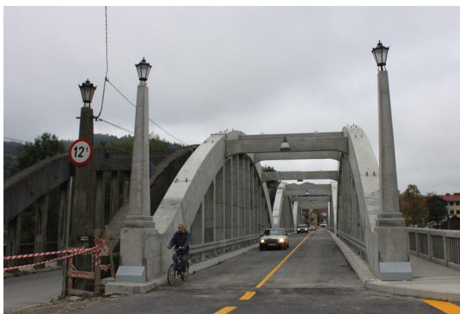
fot. obiekty mostowe podczas przebudowy w m. Krościenko n/D
