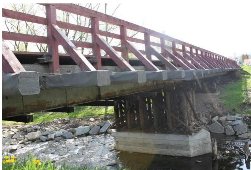
fot. Obiekt mostowy przed odbudową .
