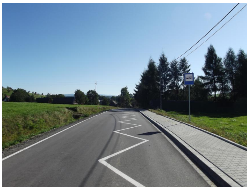
fot. K1663 Długopole – Pieniążkowie – Piekielnik po przebudowie
