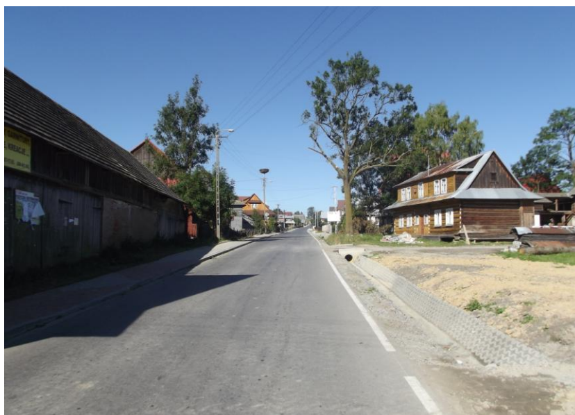
fot. K1663 Długopole – Pieniążkowie – Piekielnik po przebudowie
