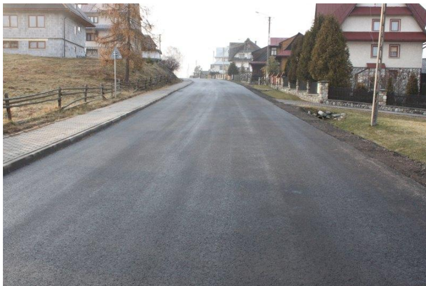
fot. Remont nawierzchni drogi powiatowej numer K1642 Groń-Trybsz- Niedzica od km 0+000 do km 5+050
