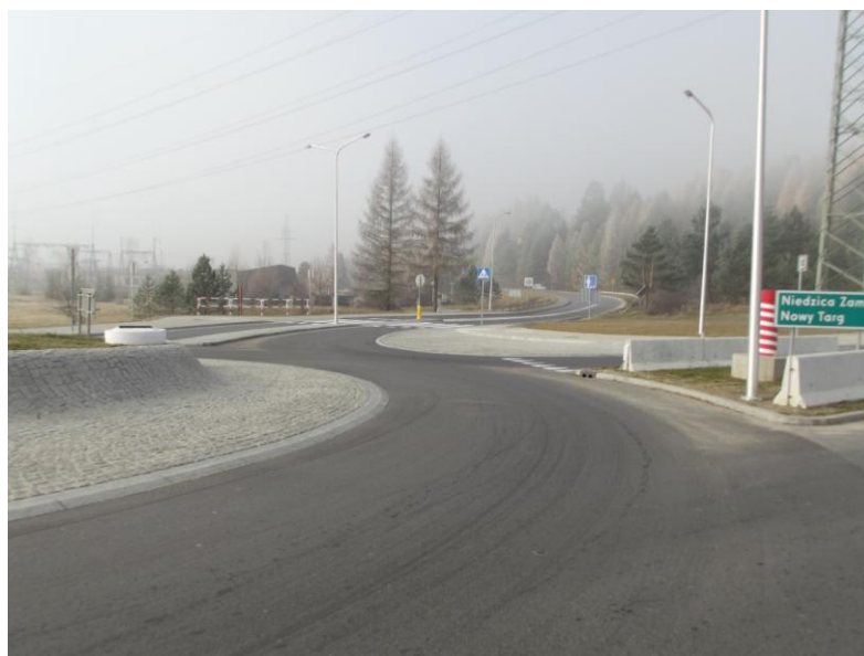
fot. K1639 Dębno – Niedzica – Gr. Państwa po przebudowie
