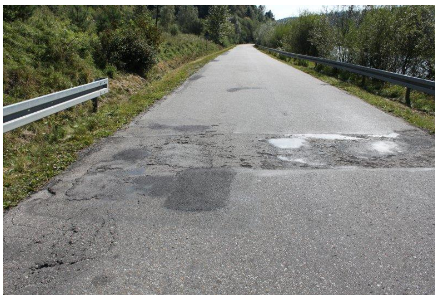
fot. droga K1638 Krośnica – Sromowce N. przed przebudową
