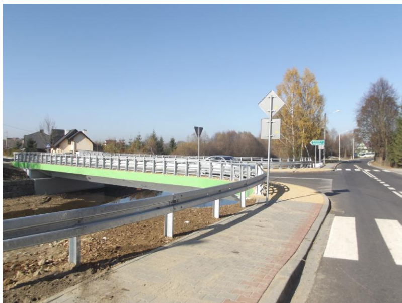
fot. obiekt mostowy w/c K1659 w Ludźmierzu po przebudowie
