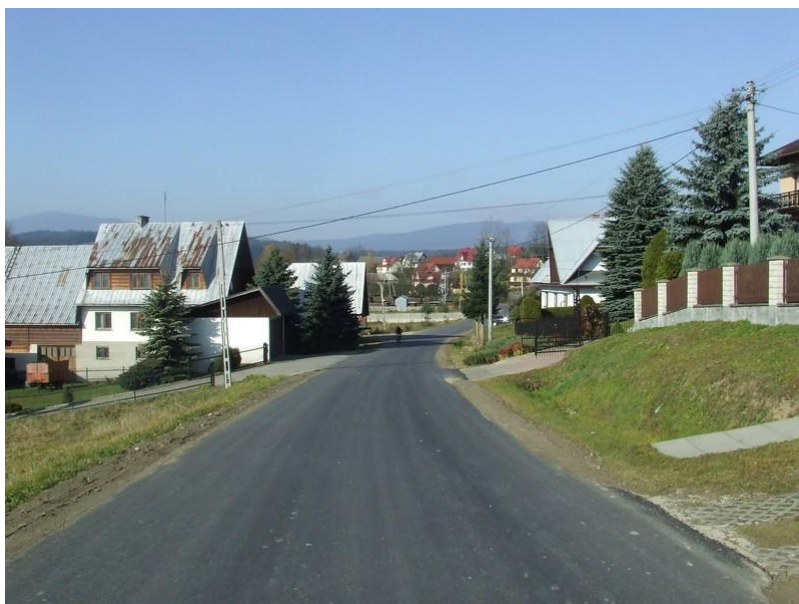
fot. Odbudowa drogi powiatowej nr K1678 Raba Wyżna -Podwilk od km 6+600 do km 8+500 oraz od km 10+100 do km 13+355” ”
