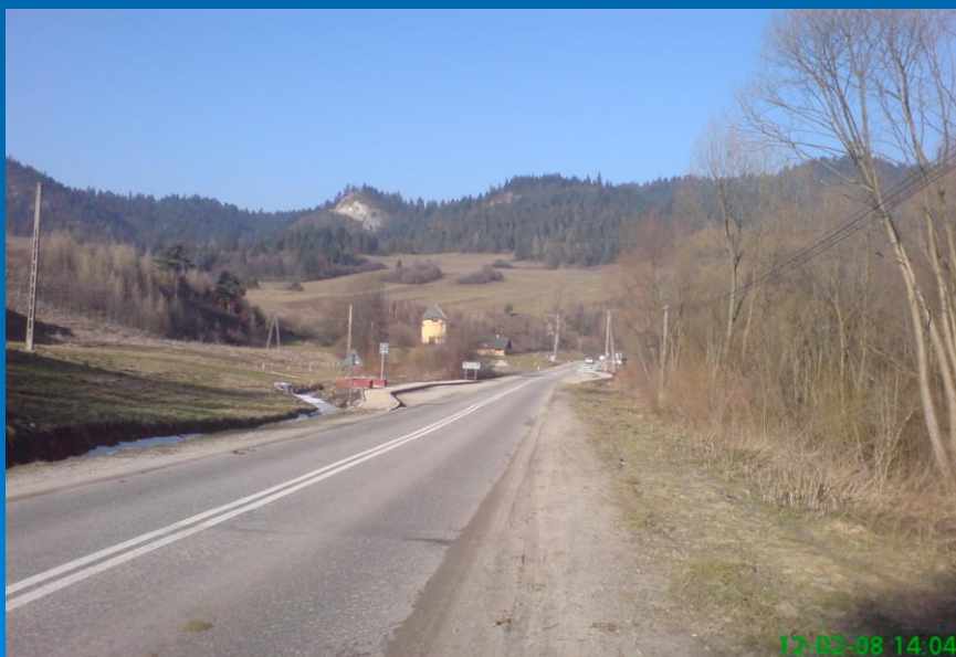
Fot. odcinek drogi K1638 Krośnica – Sromowce Niżne przed przebudową
