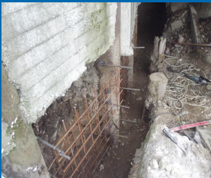
Fot. Odbudowa fragmentu ściany przyczółka na obiekcie mostowym w ciągu drogi powiatowej nr 1663K Długopole – Pieniążkowice – Piekielnik w km 0+224
