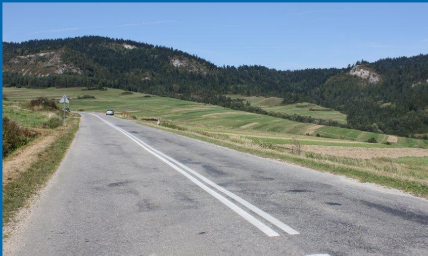
Fot. odcinek drogi K1638 Krośnica – Sromowce Niżne przed przebudową
