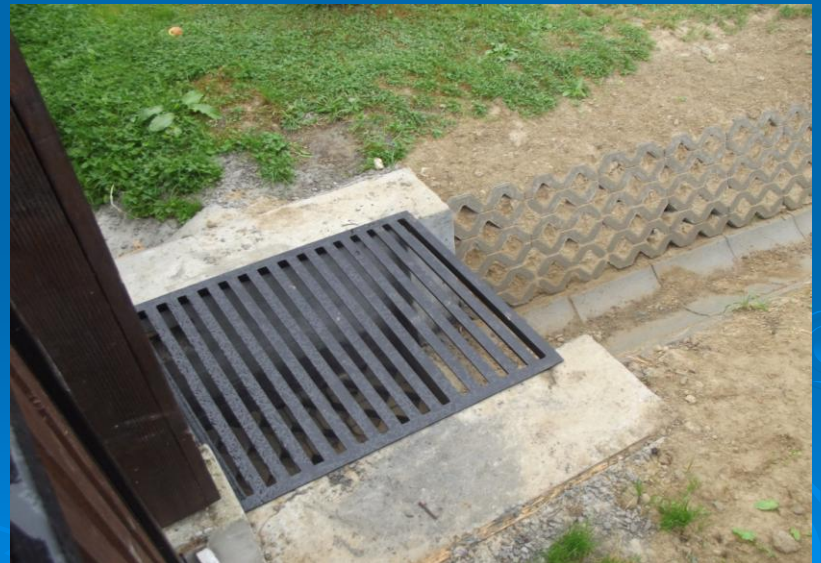
Fot. Wykonanie kraty stalowej zabezpieczającej studnię wпадową
