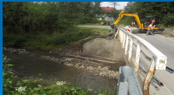
Fot. naprawa uszkodzonej poręczy mostowej w dwóch miejscach oraz zabezpieczenie ściany oporowej na skrzydle na obiekcie mostowym w ciągu drogi powiatowej nr 1661K Trute – Klikuszowa – Obidowa w km 5+573
