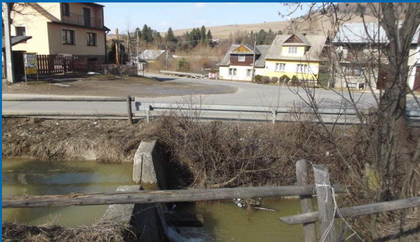
Fot. węzeł drogowy w miejscowości Niedzica przed przebudową - skrzyżowanie drogi powiatowej 1642K Groń – Trybsz – Niedzica z drogą powiatową nr 1640K Niedzica – Kacwin – przebudowa skrzyżowanie typu „rondo”
