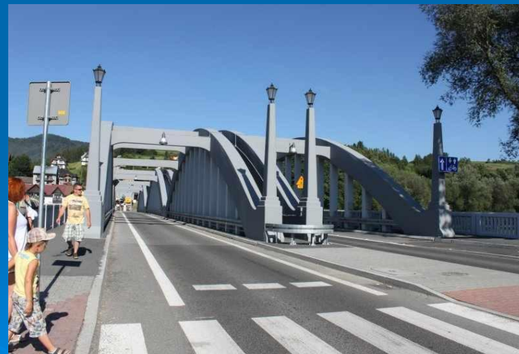
Fot. obiekt mostowy w ciągu drogi powiatowej nr 1636K Krościenko - Szczawnica
