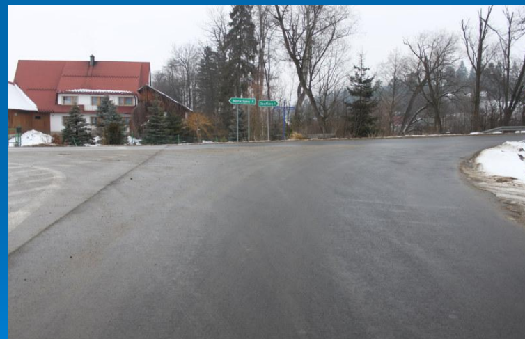
Fot. „Odbudowa nawierzchni drogi powiatowej nr K1646 Skrzypne – Szaflary – Ostrowsko od km 4+180 do km 6+729” - po przebudowie
