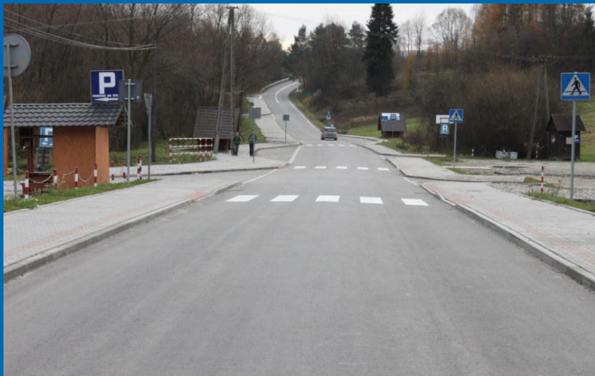
Fot. odcinek drogi K1638 Krośnica – Sromowce Niżne po przebudowie
