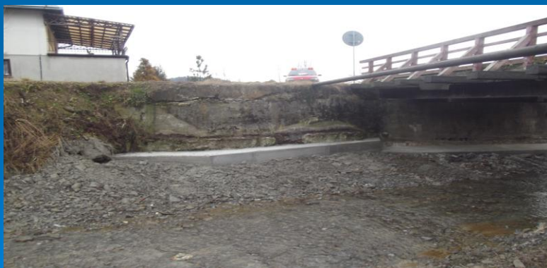
Fot. Podbicie fundamentu przyczółka na obiekcie mostowym w ciągu drogi powiatowej nr 1676K Lipnica Wielka – Przywarówka w km 8+635
