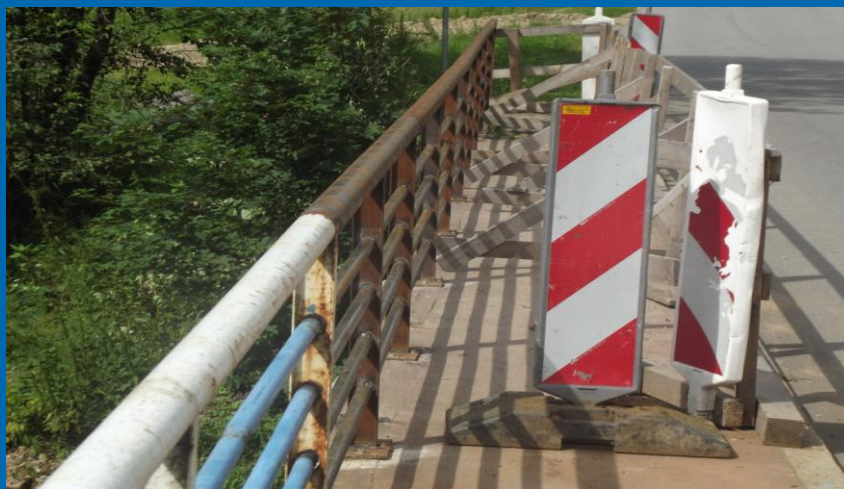
Fot. Naprawa uszkodzonej poręczy mostowej z gniazdami gzymsowymi na obiekcie mostowym w ciągu drogi powiatowej nr 1654K Ząb – Ratułów – Ciche – Chochołów w km 7+738
