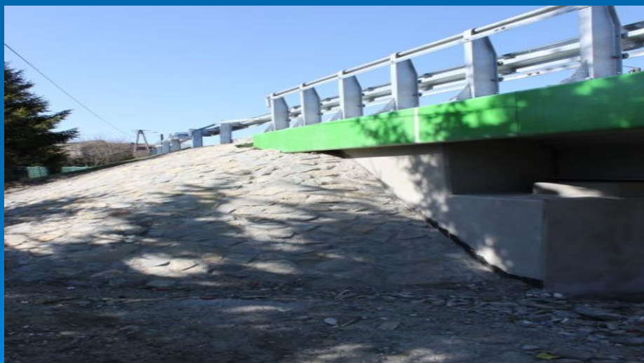
Fot. „Przebudowa mostu na potoku Lepietnica w ciągu drogi powiatowej 1660K Ludźmierz – Pyzówka” – po przebudowie
