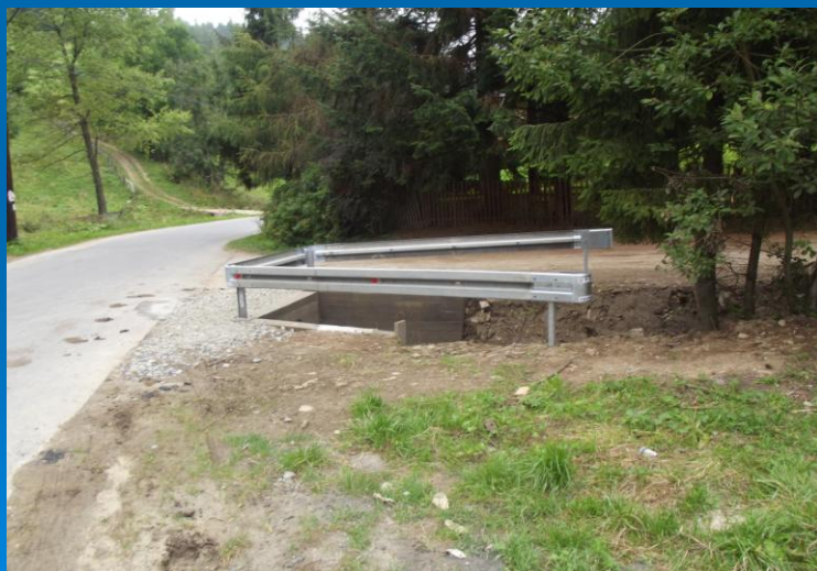
Fot. Naprawa barier energochłonnych
