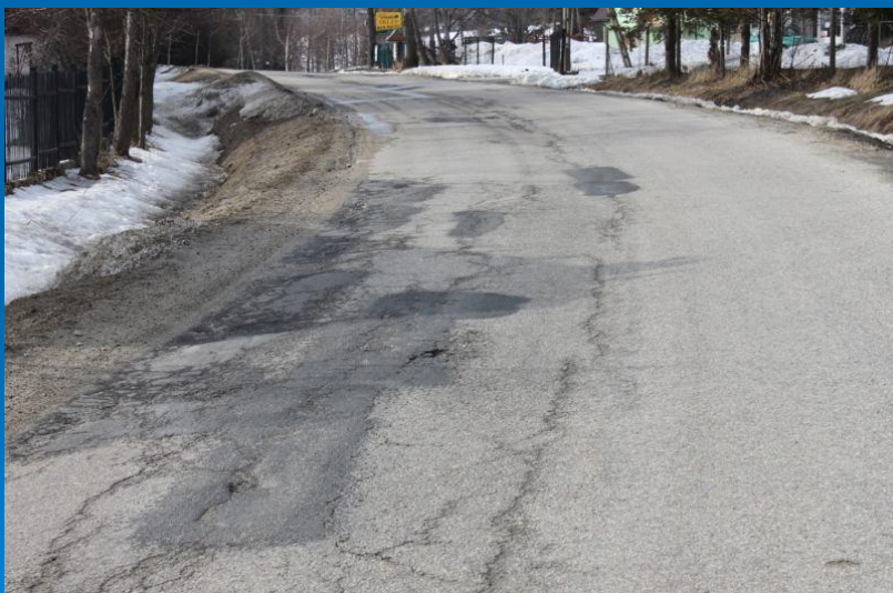
Fot. Odbudowa nawierzchni drogi powiatowej nr K1660 Ludźmierz – Pyzówka od km 2+930 do km 5+240 – przed odbudową
