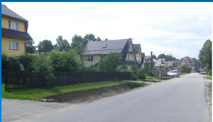
Fot. odtworzenie i oczyszczenie rowów odwadniających
