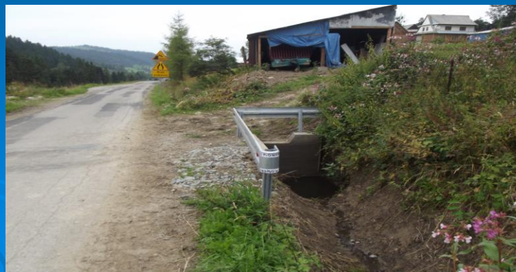
Fot. Odbudowy wlotów i wylotów przepustów drogowych rurowych
