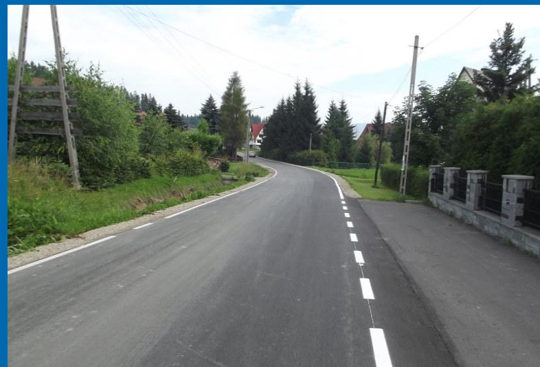
Fot. „Odbudowa nawierzchni drogi powiatowej nr K1653 Szaflary – Ząb od km 0+000 do km 7+227” – po przebudowie
