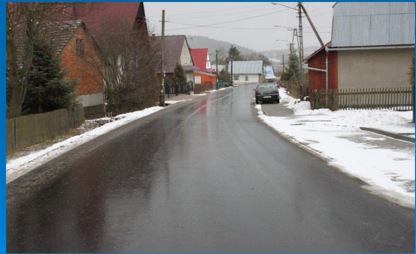
Fot. droga K176 Lipnica Wielka – Przywarówka po przebudowie
