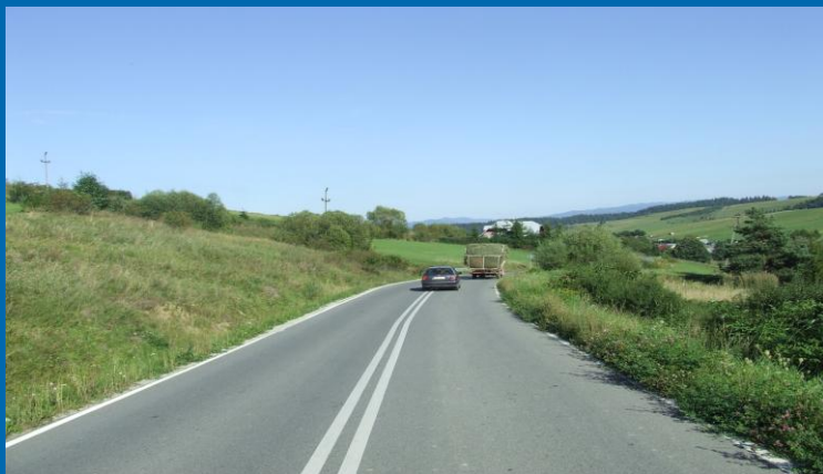
Fot. odcinek drogi przed pracami
