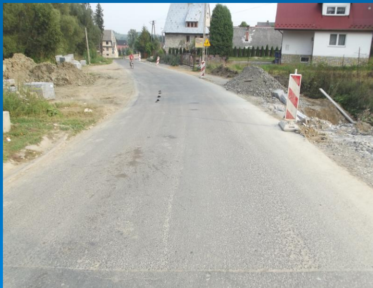
Fot. K1675 Jabłonka- Lipnica Mała odcinek drogi w trakcie przebudowy
