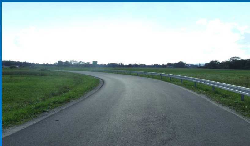
Fot. Wymiana, ustawienie stalowych barier ochronnych
