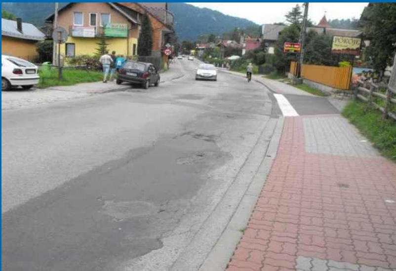
Fot. „Przebudowa drogi powiatowej 1636K Krościenko – Szczawnica ul. Główna” – przed przebudową
