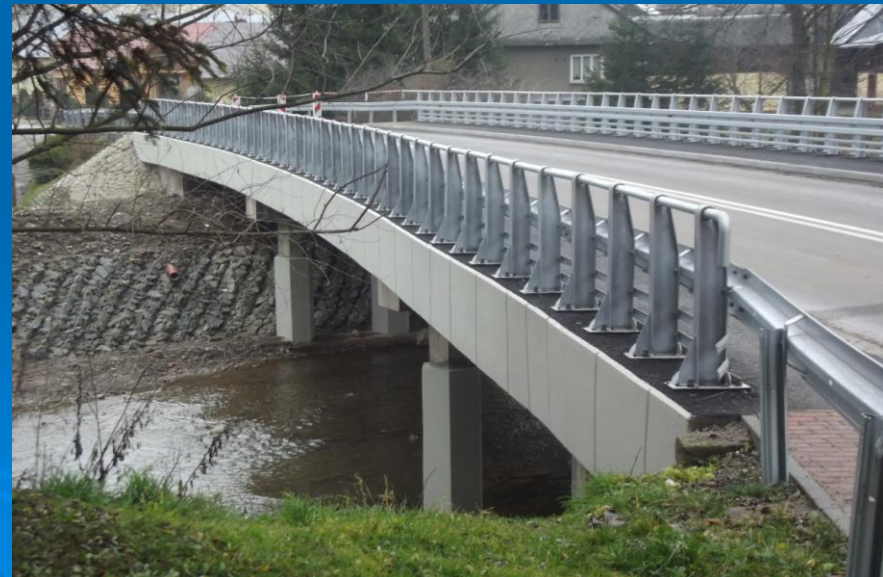
Fot. Obiekt mostowy na pot. Niedziczanka – po przebudowie
