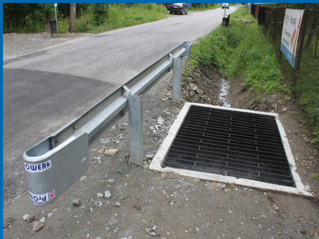
Fot. Przebudowa przepustu w km 2+081,9 drogi 1667 K Rabka Zdrój – Ponice
