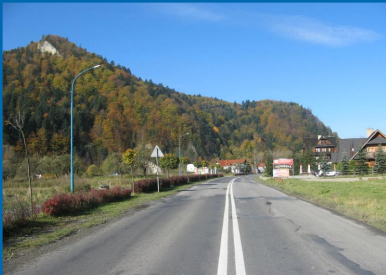
Fot. „Odbudowa nawierzchni drogi powiatowej nr K1636 Krościenko – Szczawnica od km 0+255 do km 3+252”- przed przebudową
