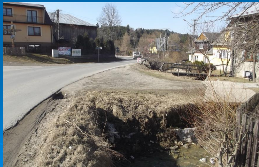
Fot. przed przebudową - regulacja biegu potoku Jędras przebiegającego pod tarczą skrzyżowania poprzez budowę przepustu żelbetowego
