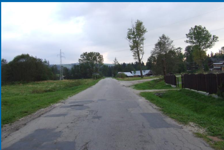
Fot. „Odbudowa nawierzchni drogi powiatowej nr K1646 Skrzypne – Szaflary – Ostrowsko od km 4+180 do km 6+729” - przed przebudową
