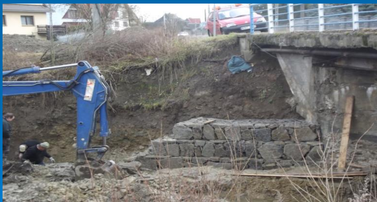
Fot. Odbudowa dwóch stożków z koszy siatkowo – kamiennych na obiekcie mostowym w ciągu drogi powiatowej nr 1676K Lipnica Wielka – Przywarówka w km 5+287
