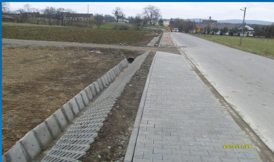
Fot. droga K1668 Rabka – Skawa - Naprawa po przebudowie
