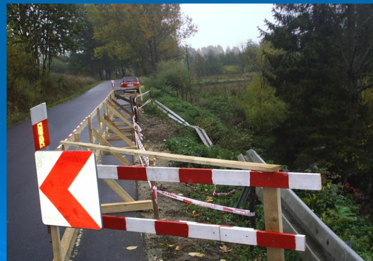
Fot. Wygradzenie i zabezpieczenie miejsc niebezpiecznych
