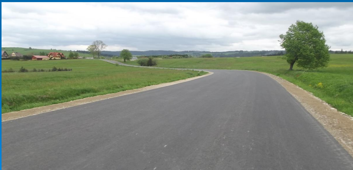
Fot. Remont i uzupełnienie ubytków poboczny
