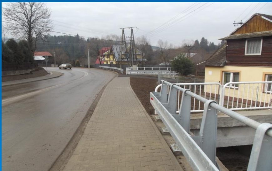
Fot. węzeł drogowy w miejscowości Niedzica po przebudowie
