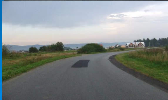
Fot. Remont nawierzchni emulsją asfaltową i grysami
