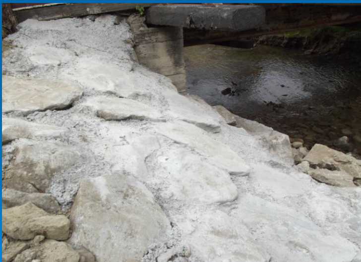
Fot. Wykonanie ciężkiego narzutu kamiennego w rejonie stożka oraz podbicie przyczółka na obiekcie mostowym w ciągu drogi powiatowej nr 1661K Trute – Klikuszowa – Obidowa w km 6+763
