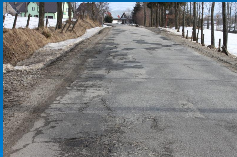
Fot. Odbudowa nawierzchni drogi powiatowej nr K1660 Ludźmierz – Pyzówka od km 2+930 do km 5+240 – przed odbudową
