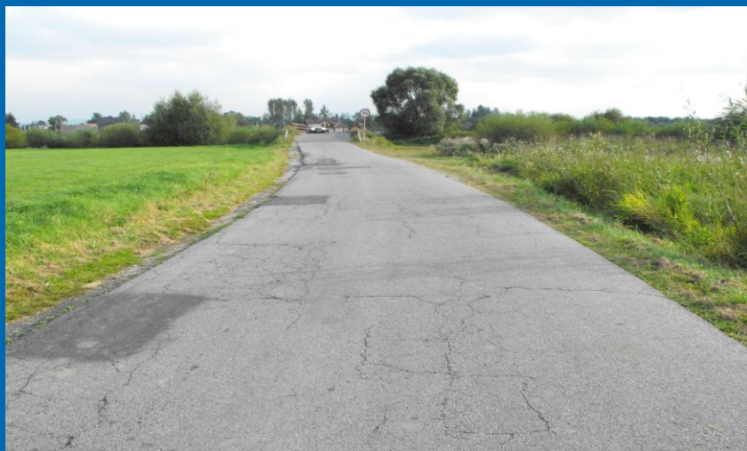
Fot. „ Odbudowa nawierzchni drogi powiatowej nr 1663K Długopole – Pieniążkowice – Piekielnik od km 0+000 do km 1+193” – przed przebudową
