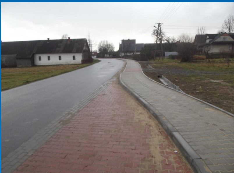
Fot. K1675 Jabłonka- Lipnica Mała odcinek drogi po przebudowie
