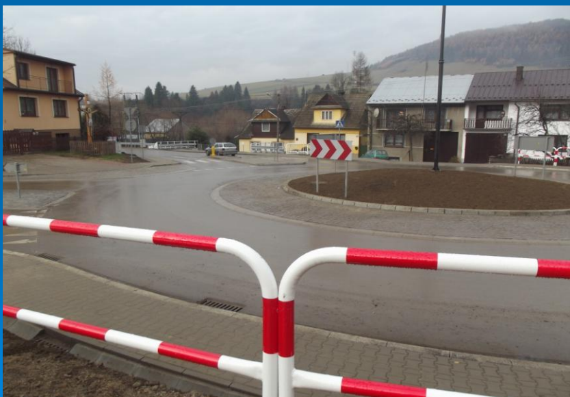
Fot. węzeł drogowy w miejscowości Niedzica po przebudowie
