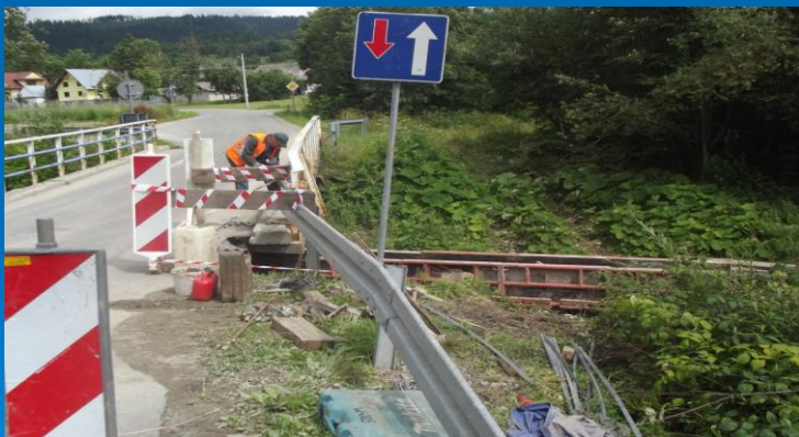
Fot. naprawa uszkodzonej poręczy mostowej w dwóch miejscach oraz zabezpieczenie ściany oporowej na skrzydle na obiekcie mostowym w ciągu drogi powiatowej nr 1661K Trute – Klikuszowa – Obidowa w km 5+573
