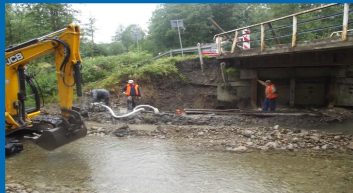
Fot. naprawa uszkodzonej poręczy mostowej w dwóch miejscach oraz zabezpieczenie ściany oporowej na skrzydle na obiekcie mostowym w ciągu drogi powiatowej nr 1661K Trute – Klikuszowa – Obidowa w km 5+573
