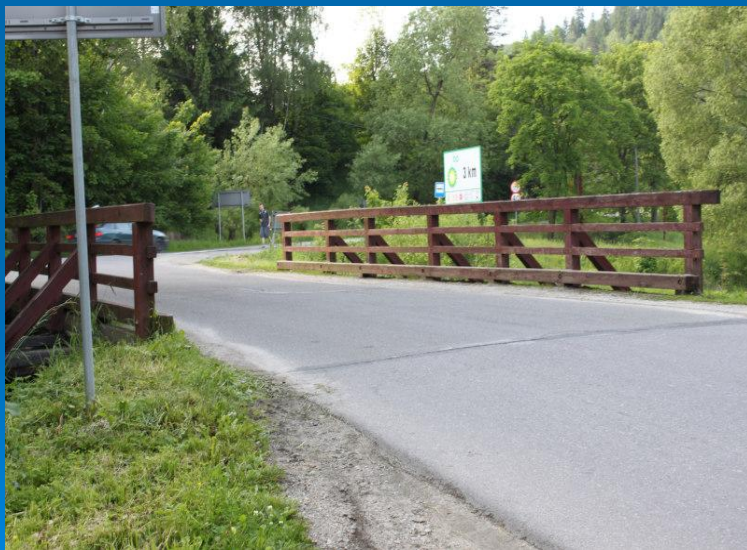
Fot. „Przebudowa mostu w km 0+025,60 w ciągu drogi powiatowej 1662K Raba Wyżna - Klikuszowa” – przed przebudową
