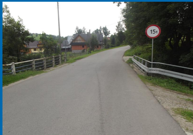
Fot. Odbudowa barier na obiekcie mostowym w ciągu drogi powiatowej nr 1651K Czarny Dunajec – Poronin w km 12+396
