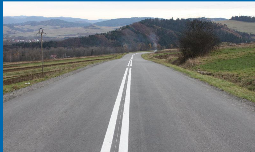
Fot. odcinek drogi K1638 Krośnica – Sromowce Niżne po przebudowie
