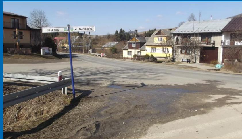
Fot. węzeł drogowy w miejscowości Niedzica przed przebudową - skrzyżowanie drogi powiatowej 1642K Groń – Trybsz – Niedzica z drogą powiatową nr 1640K Niedzica – Kacwin – przebudowa skrzyżowanie typu „rondo”
