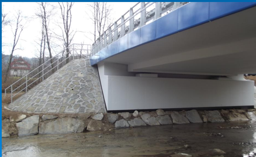
Fot. „Przebudowa mostu w km 0+025,60 w ciągu drogi powiatowej 1662K Raba Wyżna - Klikuszowa” – po przebudowie
