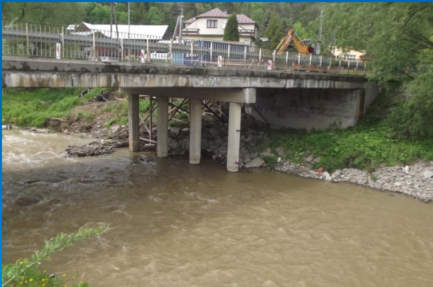
Fot. Obiekt mostowy na pot. Niedziczanka – przed przebudową
