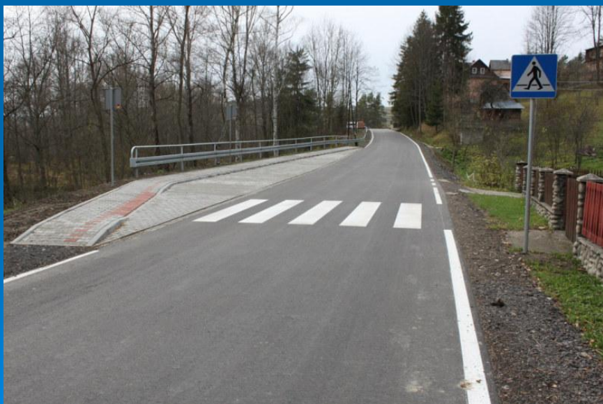
Fot. odcinek drogi K1638 Krośnica – Sromowce Niżne po przebudowie
