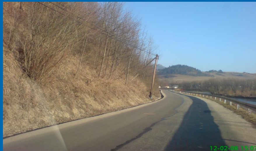
Fot. odcinek drogi K1638 Krośnica – Sromowce Niżne przed przebudową
