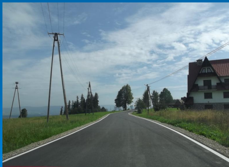
Fot. „Odbudowa nawierzchni drogi powiatowej nr K1653 Szaflary – Ząb od km 0+000 do km 7+227” – po przebudowie
