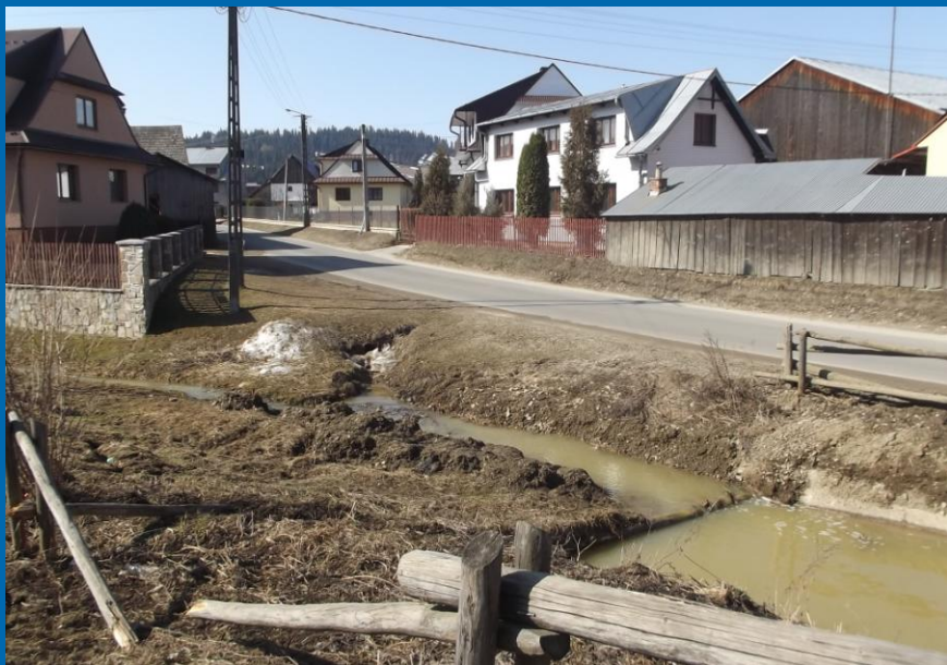
Fot. węzeł drogowy w miejscowości Niedzica przed przebudową - skrzyżowanie drogi powiatowej 1642K Groń – Trybsz – Niedzica z drogą powiatową nr 1640K Niedzica – Kacwin – przebudowa skrzyżowanie typu „rondo”
