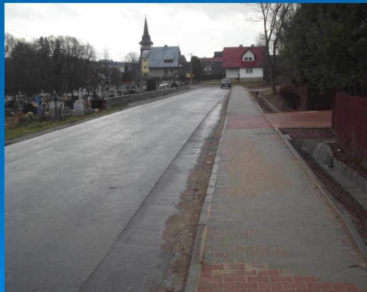
Fot. K1675 Jabłonka- Lipnica Mała odcinek drogi po przebudowie
