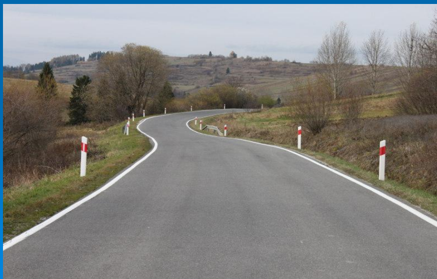
Fot. na całej długości przedmiotowego połączenia zostało wykonane nowe oznakowanie pionowe i poziome
