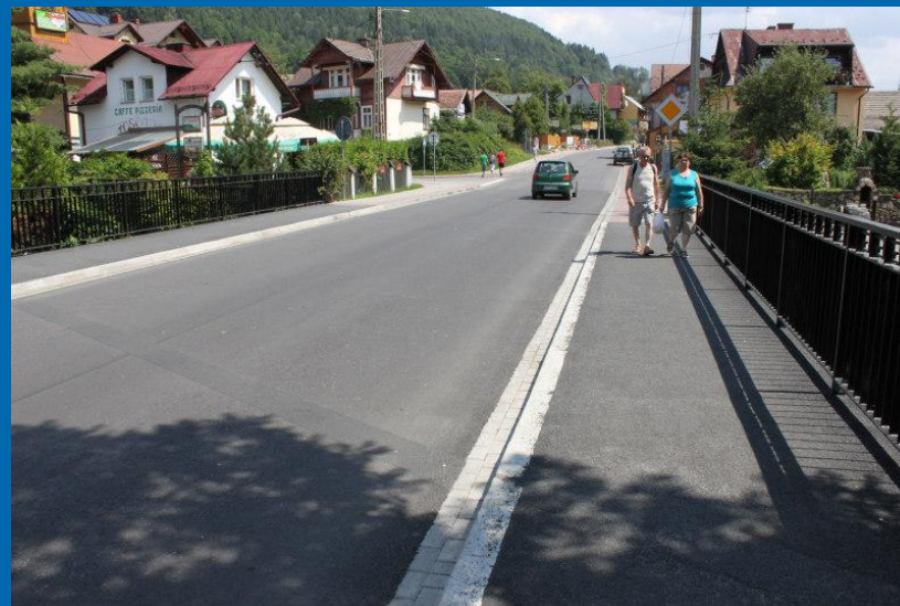
Fot. „Przebudowa drogi powiatowej 1636K Krościenko – Szczawnica ul. Główna” – po przebudowie
