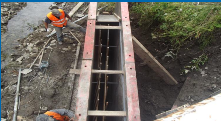
Fot. naprawa uszkodzonej poręczy mostowej w dwóch miejscach oraz zabezpieczenie ściany oporowej na skrzydle na obiekcie mostowym w ciągu drogi powiatowej nr 1661K Trute – Klikuszowa – Obidowa w km 5+573
