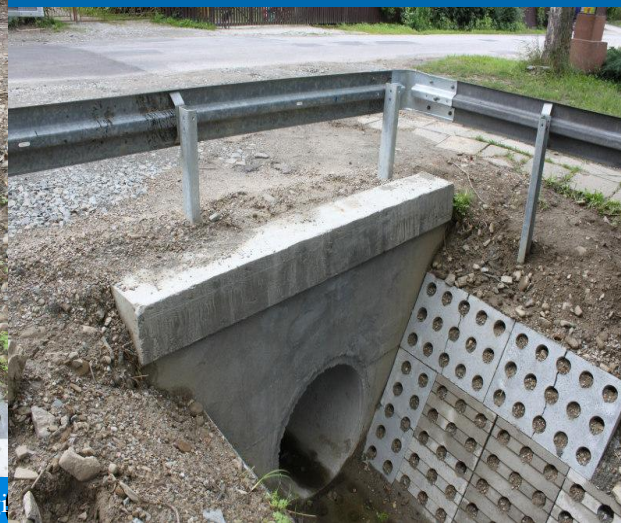
Fot. Przebudowa przepustu w km 2+081,9 drogi 1667 K Rabka Zdrój – Ponice
