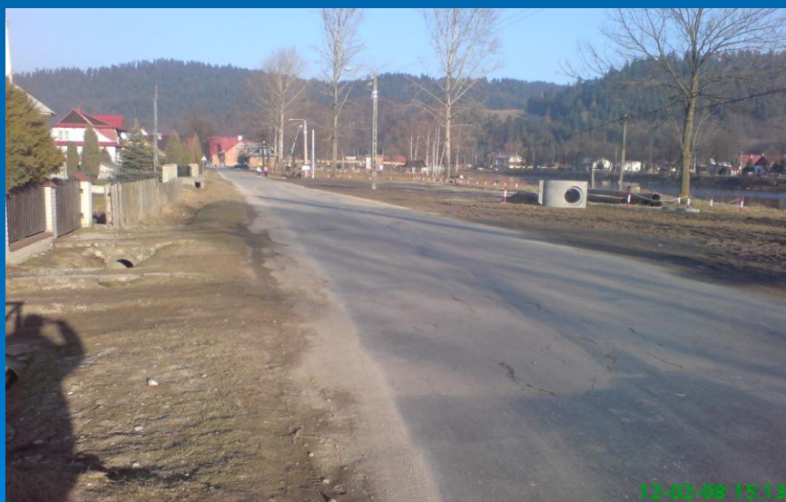
Fot. odcinek drogi K1638 Krośnica – Sromowce Niżne przed przebudową
