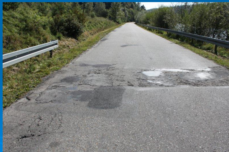
Fot. odcinek drogi K1638 Krośnica – Sromowce Niżne przed przebudową
