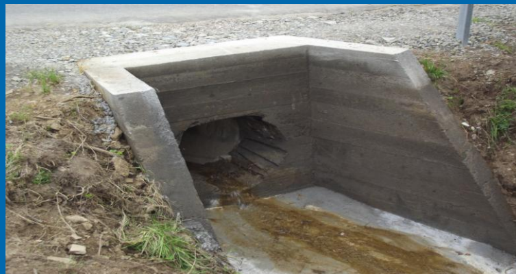
Fot. Odbudowy wlotów i wylotów przepustów drogowych rurowych
