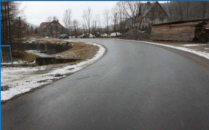
Fot. droga K176 Lipnica Wielka – Przywarówka po przebudowie
