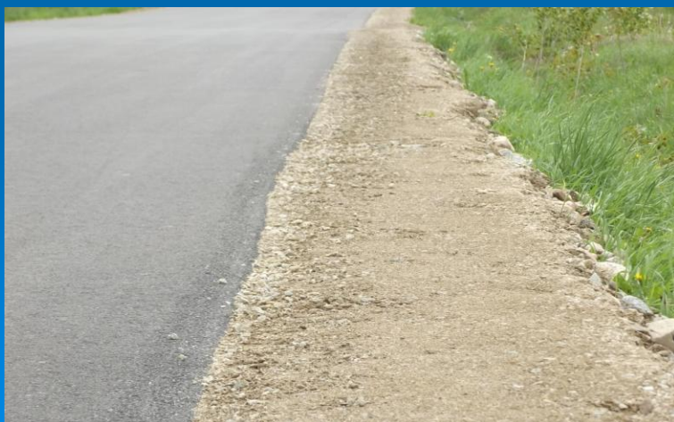
Fot. uzupełnianie poboczy
