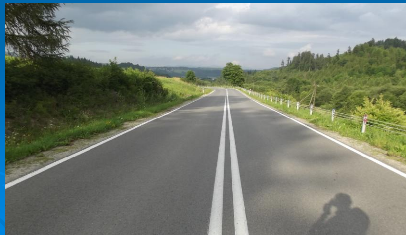
Fot. Naprawa uszkodzonych barier ochronnych 3-linowych
