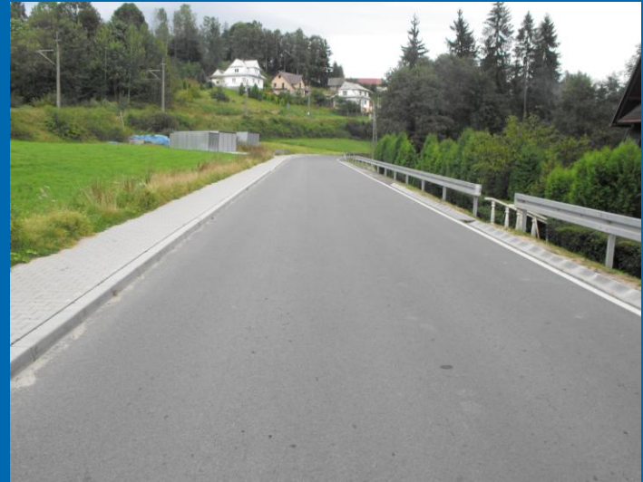
Fot. Czyszczenie i odmulanie korytek ściekowych
