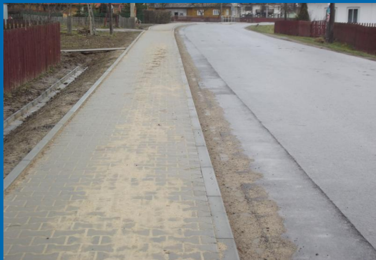
Fot. K1675 Jabłonka- Lipnica Mała odcinek drogi po przebudowie
