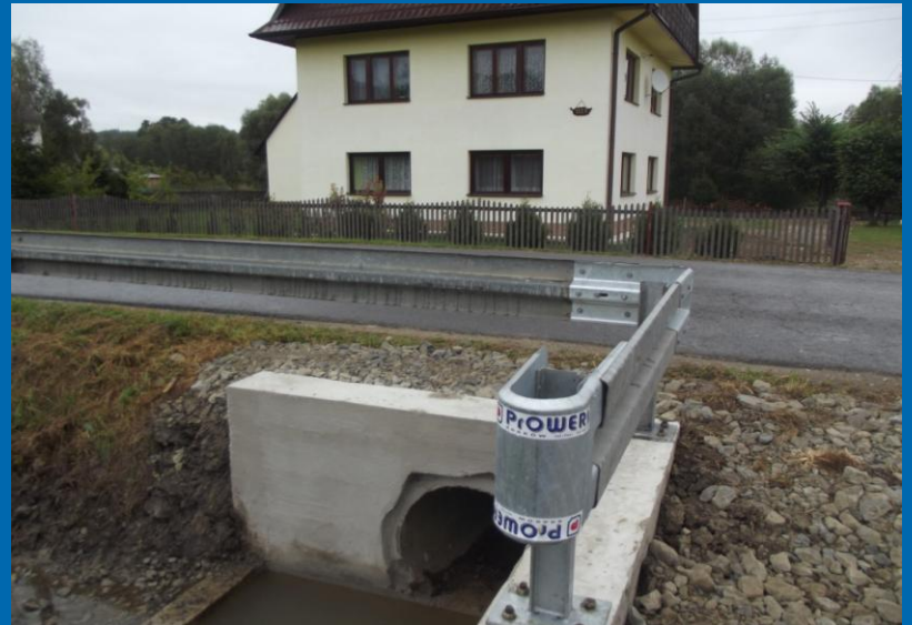
Fot. Odbudowy wlotów i wylotów przepustów drogowych rurowych
