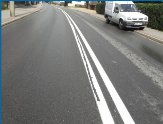
Fot. Likwidacja spękań nawierzchni za pomocą masy zalewowej
