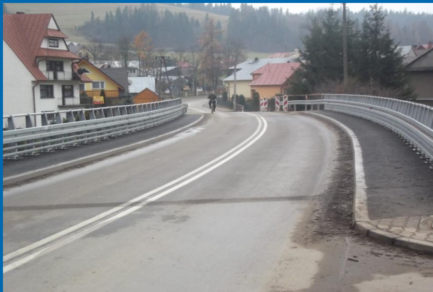
Fot. Obiekt mostowy na pot. Niedziczanka – po przebudowie
