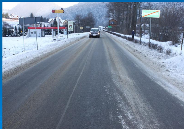
Fot. „Odbudowa nawierzchni drogi powiatowej nr K1636 Krościenko – Szczawnica od km 0+255 do km 3+252”- po przebudowie
