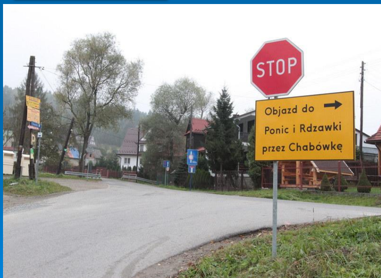
Fot. „Odbudowa nawierzchni drogi powiatowej nr K1667 Rabka – Zdrój (ul. Podhalańska) – Ponice od km 2+146 do km 3+146” – przed przebudową
