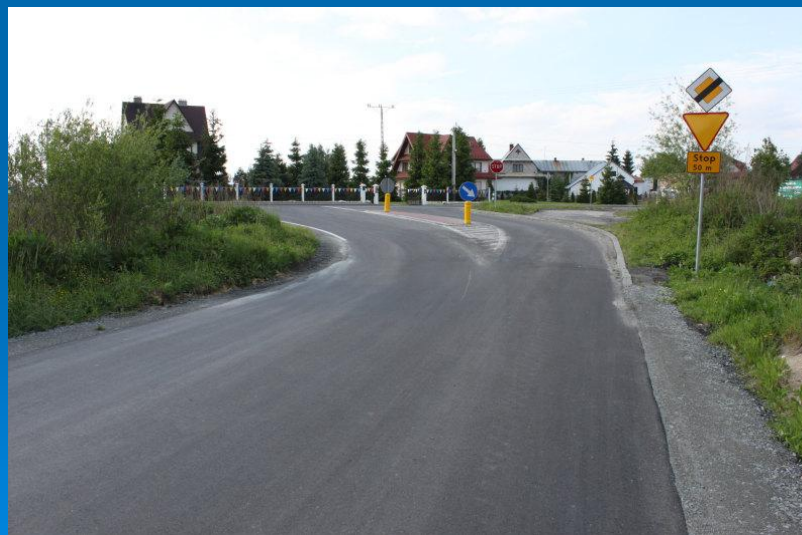
Fot. Odbudowa nawierzchni drogi powiatowej nr K1659 Maruszyna – Ludźmierz – Czarny Dunajec od km 0+120 do km 4+505 – po odbudowie
