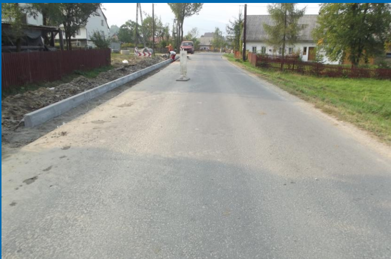
Fot. K1675 Jabłonka- Lipnica Mała przebudowywany odcinek drogi
