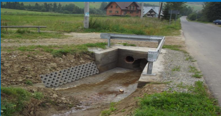
Fot. Odbudowy wlotów i wylotów przepustów drogowych rurowych
