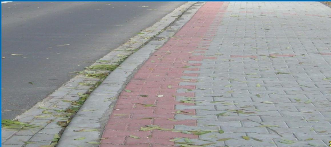
Fot. wymiana nawierzchni chodnika z elementów betonowych
