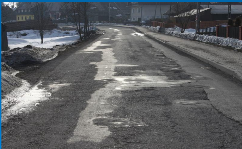
Fot. „Odbudowa nawierzchni drogi powiatowej nr K1664 Harkabuz - Piekielnik od km 5+917 do km 9+040” – przed przebudową
