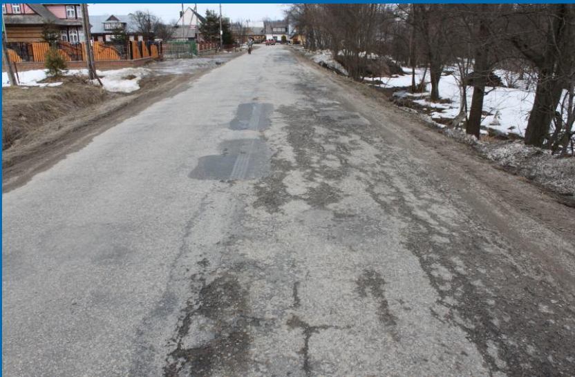
Fot. „Odbudowa nawierzchni drogi powiatowej nr K1655 Rogoźnik - Ciche od km 0+000 do km 3+940” - przed przebudową
