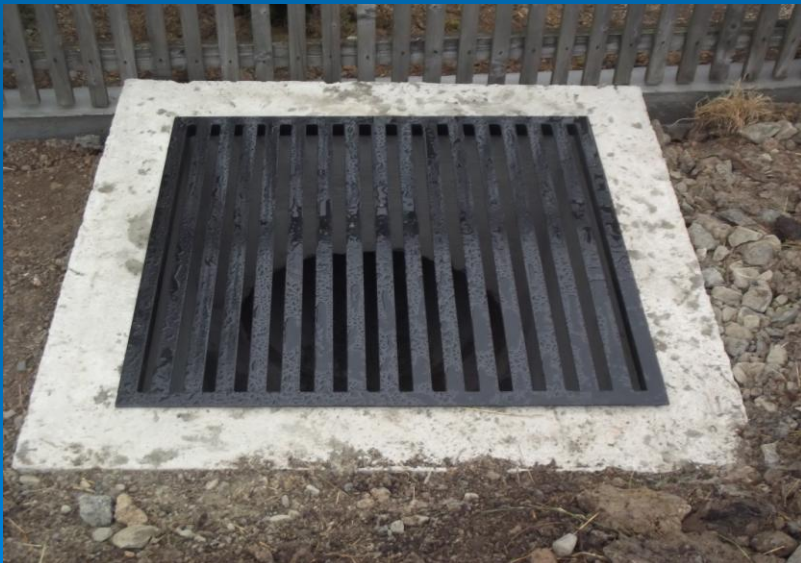
Fot. Wykonanie kraty stalowej zabezpieczającej studnię wпадową
