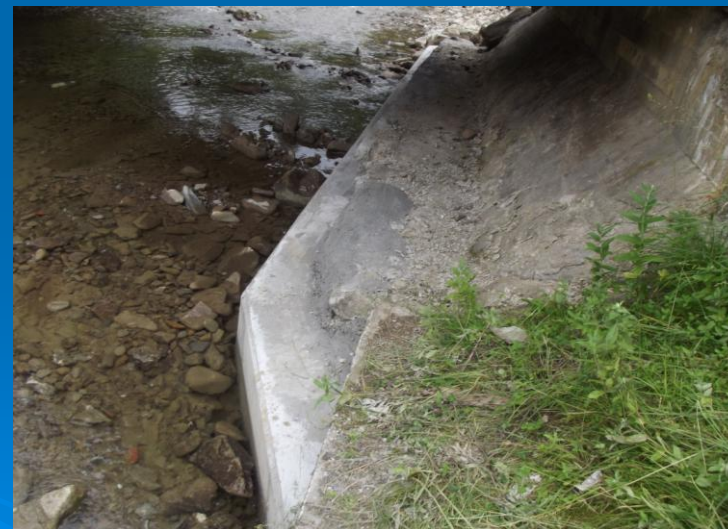
Fot. Wykonanie ciężkiego narzutu kamiennego w rejonie stożka oraz podbicie przyczółka na obiekcie mostowym w ciągu drogi powiatowej nr 1661K Trute – Klikuszowa – Obidowa w km 6+763
