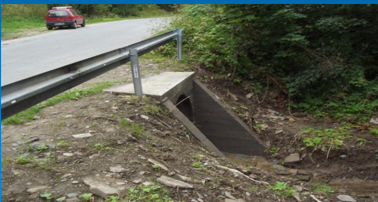
Fot. Odbudowy wlotów i wylotów przepustów drogowych rurowych
