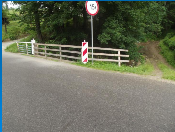
Fot. Wygradzenie i zabezpieczenie miejsc niebezpiecznych
