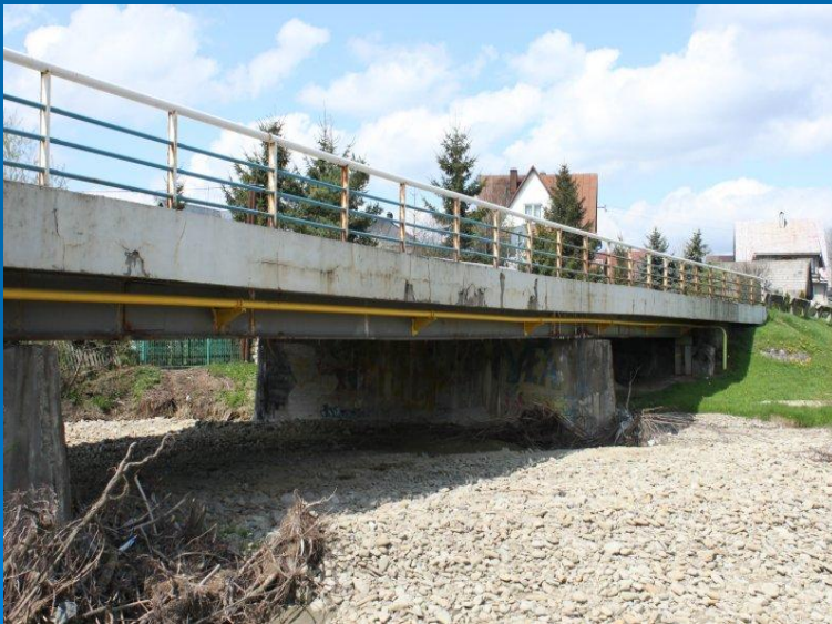
Fot. „Przebudowa mostu na potoku Lepietnica w ciągu drogi powiatowej 1660K Ludźmierz – Pyzówka” – przed przebudową
