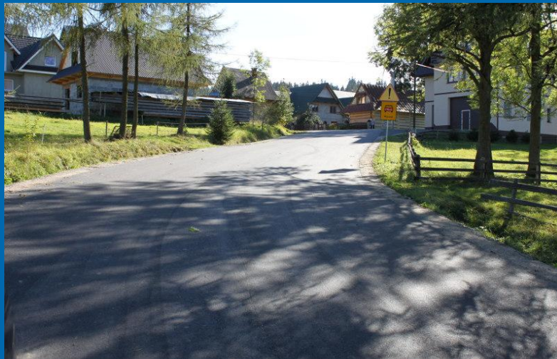
Fot. „Odbudowa nawierzchni drogi powiatowej nr K1652 Ciche – Dzianisz od km 5+000 do km 6+292” – po przebudowie
