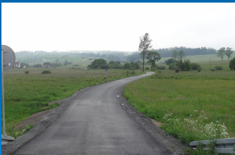
Fot. „ Odbudowa nawierzchni drogi powiatowej nr 1663K Długopole – Pieniążkowice – Piekielnik od km 0+000 do km 1+193” – po przebudowie
