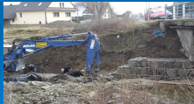
Fot. Odbudowa dwóch stożków z koszy siatkowo – kamiennych na obiekcie mostowym w ciągu drogi powiatowej nr 1676K Lipnica Wielka – Przywarówka w km 5+287
