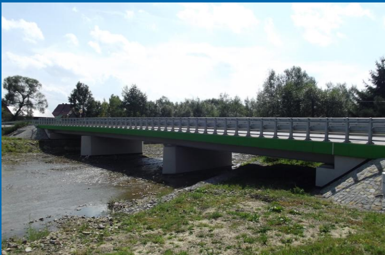
Fot. „Przebudowa mostu na potoku Lepietnica w ciągu drogi powiatowej 1660K Ludźmierz – Pyzówka” – po przebudowie
