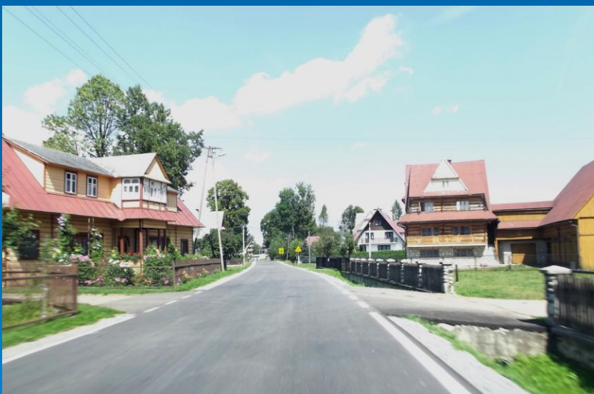
Fot. „Odbudowa nawierzchni drogi powiatowej nr K1655 Rogoźnik - Ciche od km 0+000 do km 3+940” - po przebudowie
