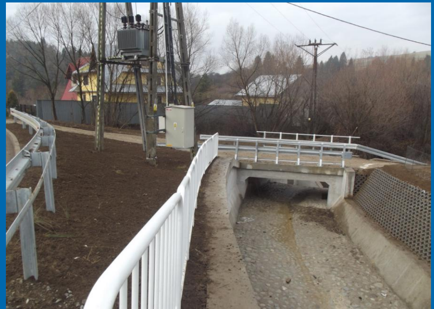
Fot. po przebudowie - regulacja biegu potoku Jędras przebiegającego pod tarczą skrzyżowania poprzez budowę przepustu żelbetowego
