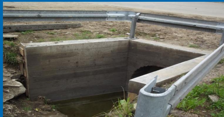
Fot. Wykonanie przepustu z rur polietylenowych
