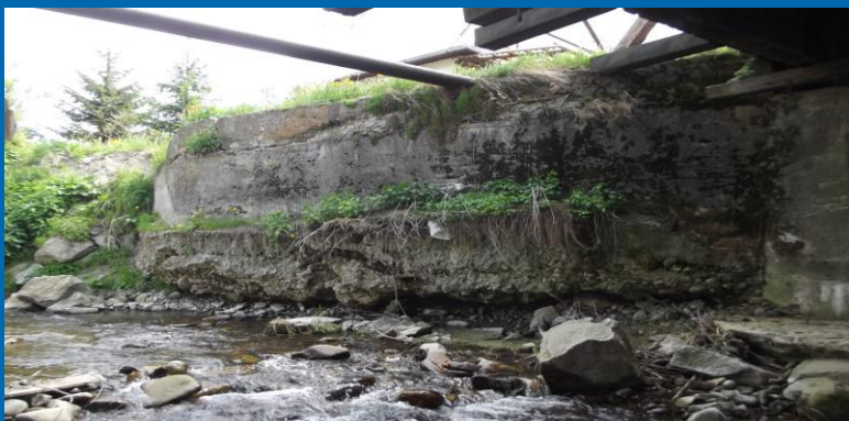
Fot. zniszczone i podmyte fundamentu przyczółka na obiekcie mostowym w ciągu drogi powiatowej nr 1676K Lipnica Wielka – Przywarówka w km 8+635
