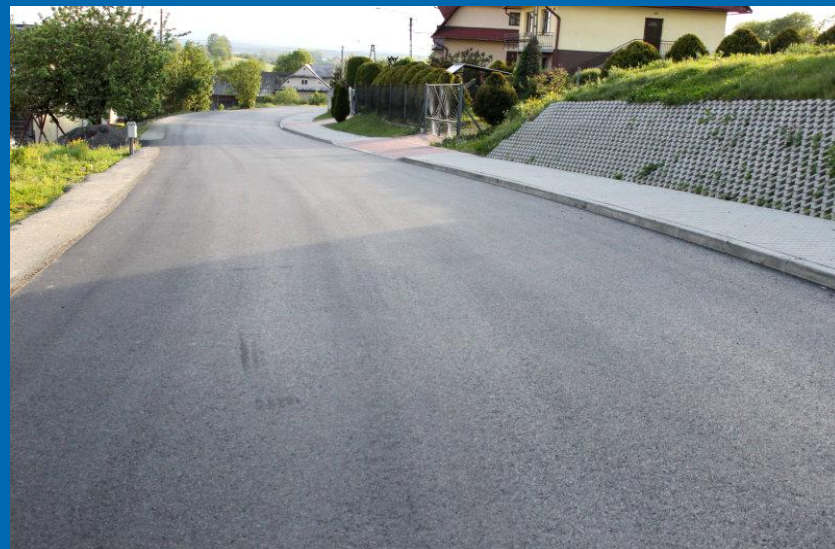
Fot. „Odbudowa nawierzchni drogi powiatowej nr K1664 Harkabuz - Piekienik od km 5+917 do km 9+040” – po przebudowie
