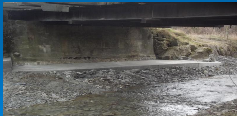
Fot. Podbicie fundamentu przyczółka na obiekcie mostowym w ciągu drogi powiatowej nr 1676K Lipnica Wielka – Przywarówka w km 8+635
