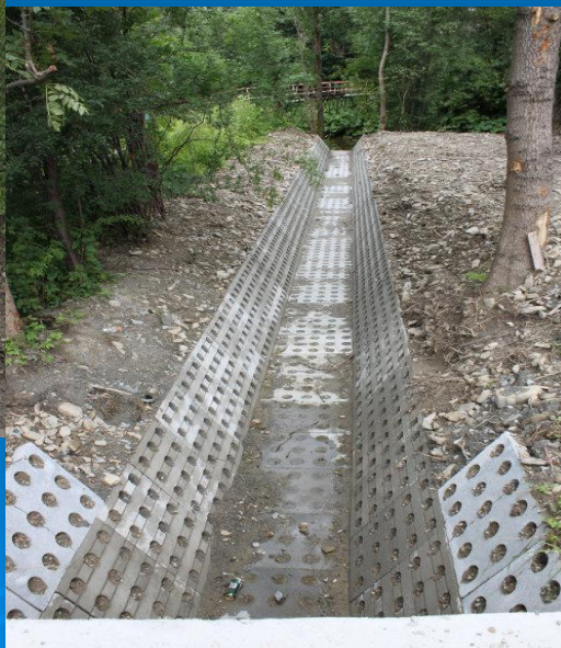
Fot. Przebudowa przepustu w km 2+081,9 drogi 1667 K Rabka Zdrój – Ponice
