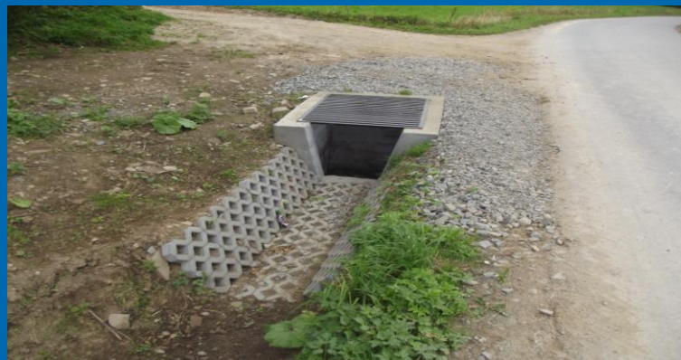
Fot. Wykonanie przepustu z rur polietylenowych
