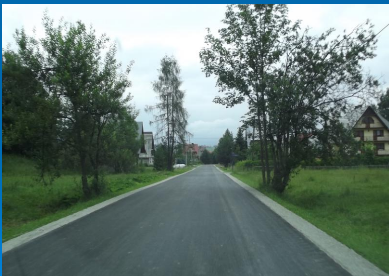
Fot. „Odbudowa nawierzchni drogi powiatowej nr K1646 Skrzypne – Szaflary - Ostrowsko od km 0+380 do km 4+180” – po przebudowie
