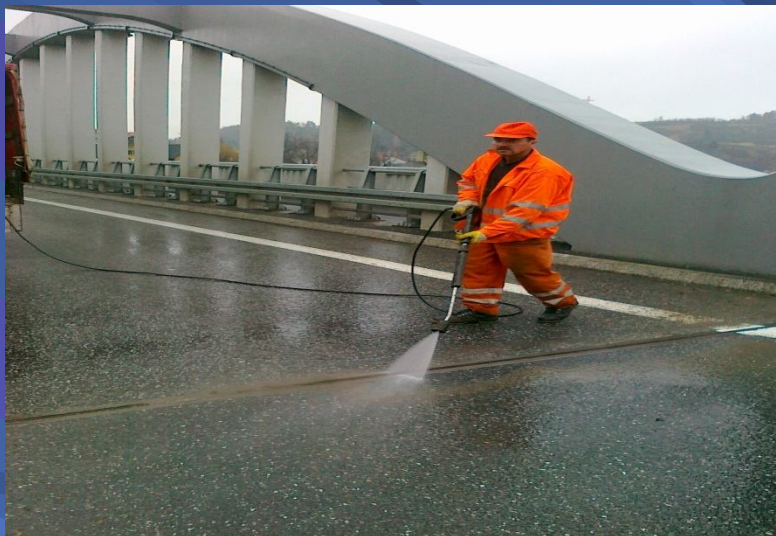
Fot. Czyszczenie dylatacji na obiektach mostowych
