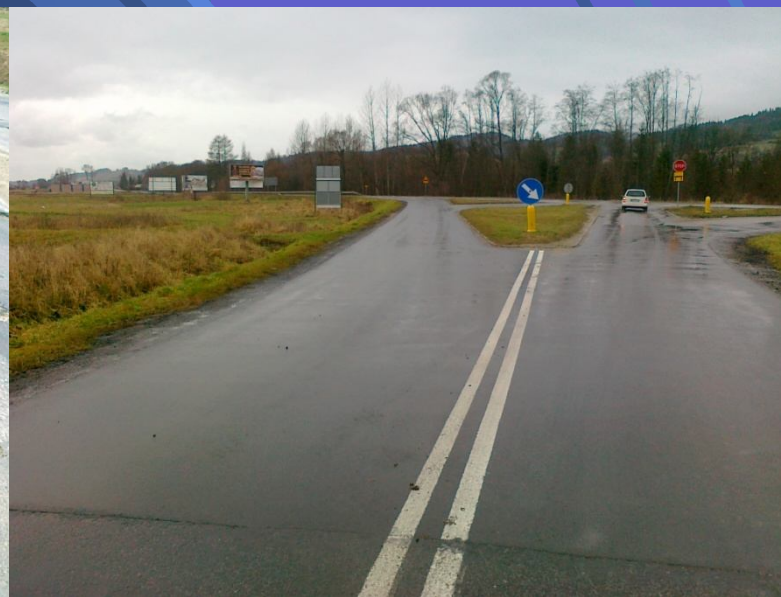
Fot. Remont nawierzchni mieszanką mineralno asfaltową w m. Dębno-po wykonaniu prac
