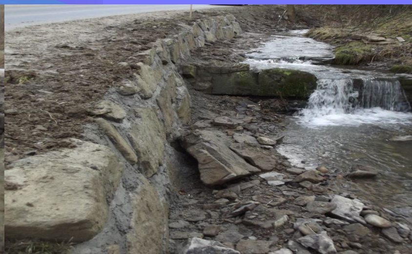
Fot. odcinek korpusu drogi powiatowej nr 1641K Łapsze Wyżne – Jurgów – po odbudowie
