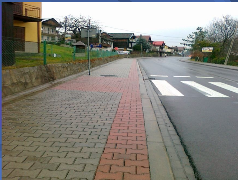
Fot. Odcinek drogi powiatowej 1636K Krościenko – Szczawnica ul. Główna w miejscowości Szczawnica po przebudowie
