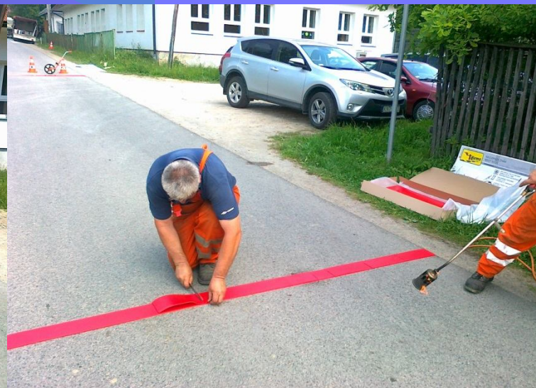
Fot. Montaż progów akustycznych na drogach powiatowych
