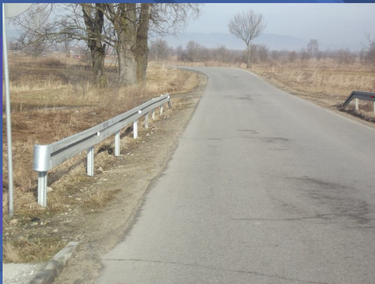
Fot. Wymiana, ustawienie barier ochronnych
