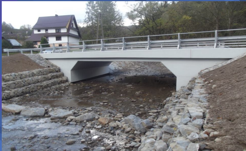
Fot. obiekt mostowy na pot. Luboński w ciągu drogi powiatowej nr 1637K Harkłowa – Tylmanowa – po remoncie
