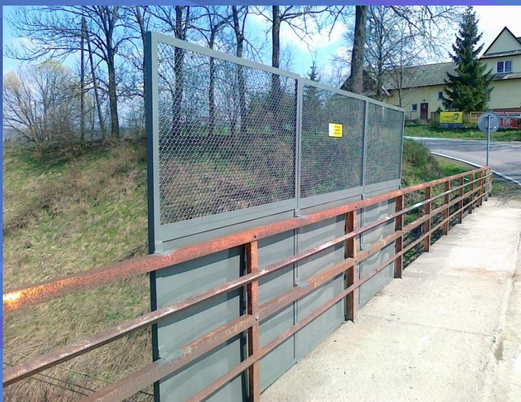
Fot. Wymiana, ustawienie barier ochronnych na wiadukcie nad linia PKP– m. Skawa
