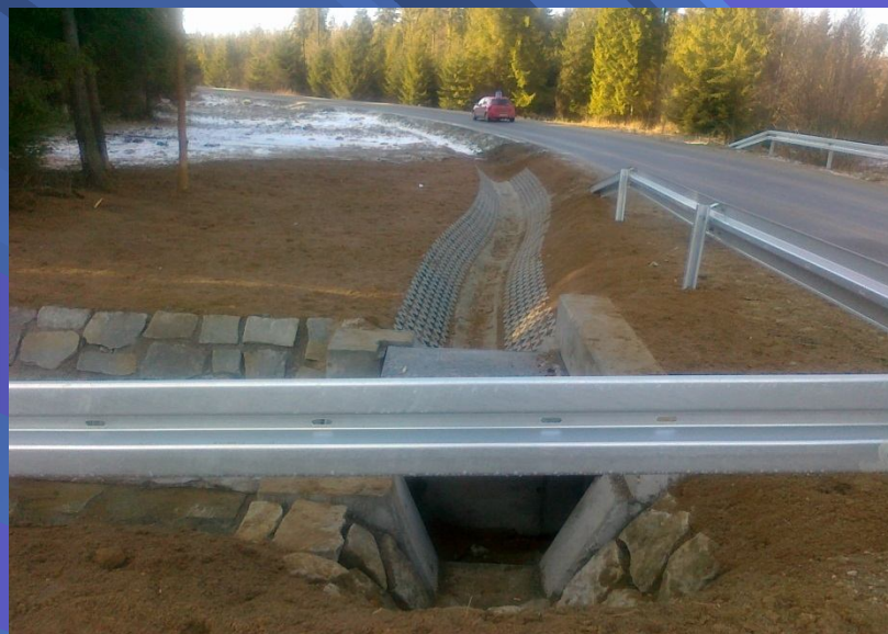
Fot. Zabezpieczenie korpusu drogi powiatowej 1646K Skrzypne – Szaflary – Ostrowsko w km 5+790 do km 5+804 wraz z elementami bezpieczeństwa i modernizacją elementów odwodnienia drogi
