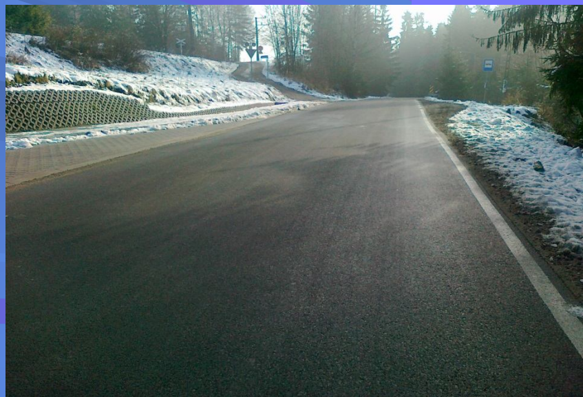
Fot. Odcinek drogi powiatowej 1662K Raba Wyżna – Klikuszowa w miejscowości Sieniawa po przebudowie
