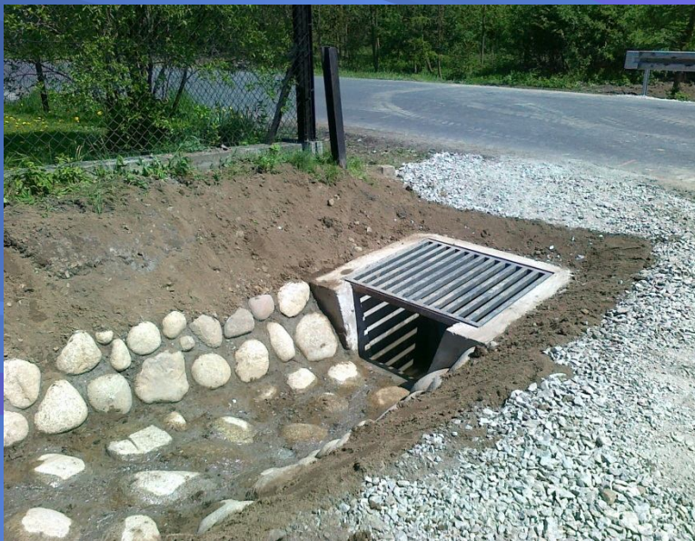
Fot. Odbudowy wlotów i wylotów przepustów drogowych rurowych m. Ponice
