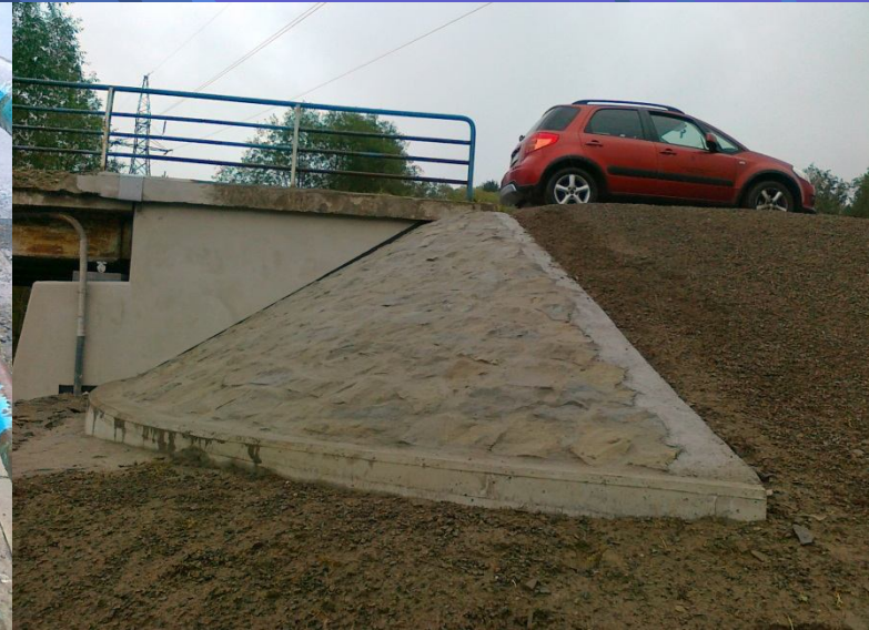
Fot. Remont obiektu mostowego na potoku Łapszanka w ciągu drogi powiatowej 1641K Łapsze Wyżne – Jurgów w km 0+732 – po remoncie
