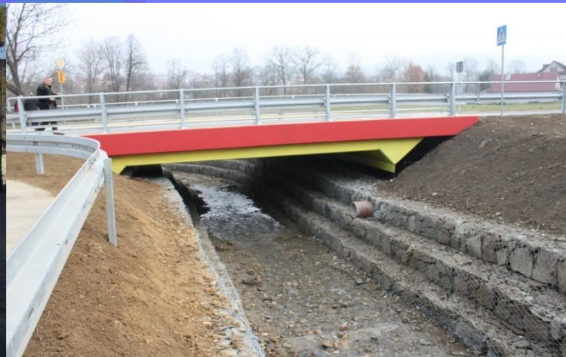
Fot. obiekt mostowy na potoku Pocieszna Woda w ciągu drogi powiatowej nr 1667K Rabka – Ponice – po modernizacji
