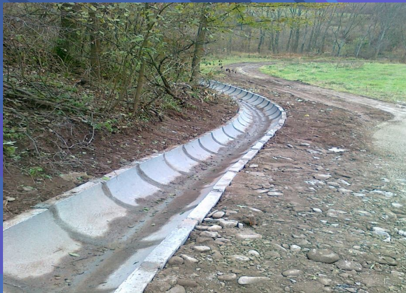
Fot. Wyremontowany odpływ od przepustu pod drogą powiatową 1636K Krościenko – Szczawnica w m. Szlachtowa
