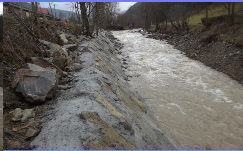
Fot. odcinek korpusu drogi powiatowej nr 1637K Harkłowa – Tylmanowa – po remoncie
