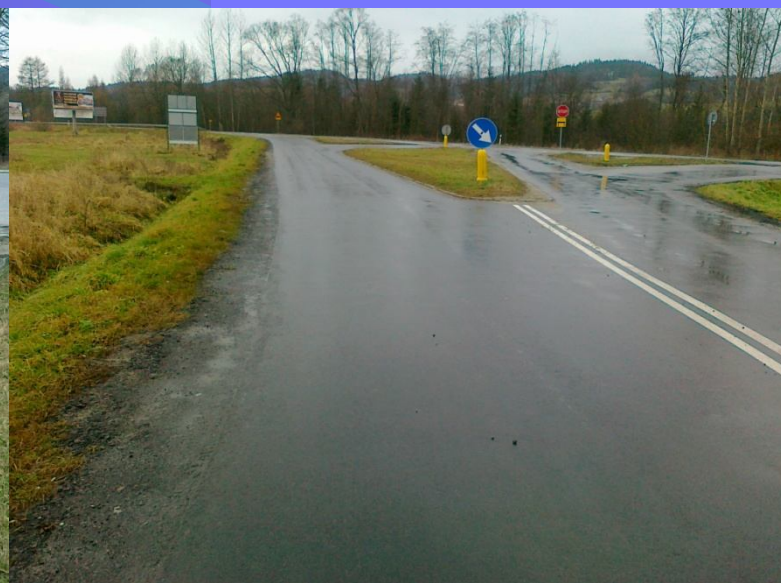
Fot. Remont nawierzchni mieszanką mineralno asfaltową w m. Dębno-po wykonaniu prac
