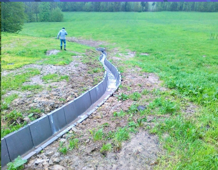
Fot. Wykonanie, wymiana korytek ściekowych betonowych odpływu od przepustu – m. Czerwieńne
