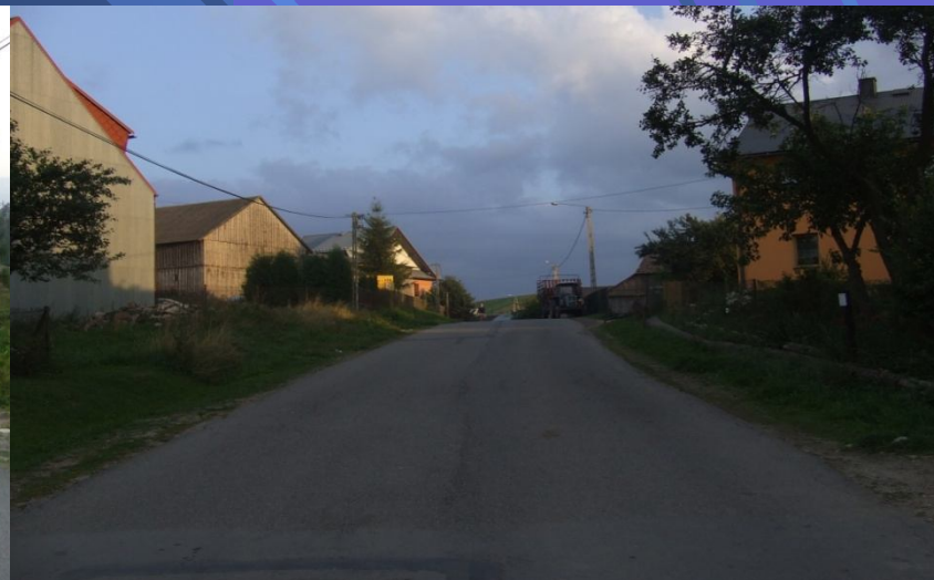
Fot. odcinek drogi powiatowej nr 1644K Łopuszna - Dursztyn – przed przebudową
