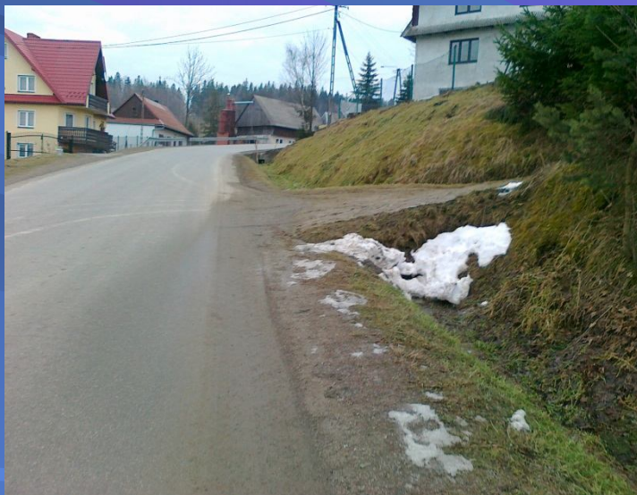
Fot. odcinek drogi przed pracami budowlanymi w m. Harkabuz
