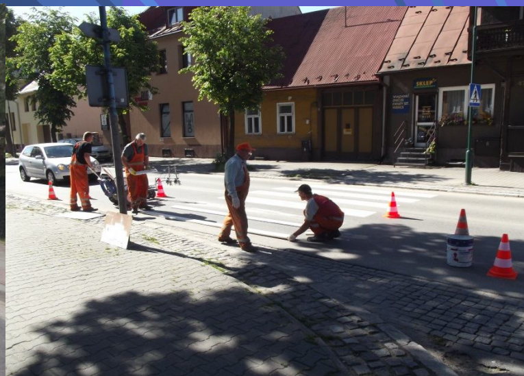
Fot. Wykonanie oznakowania poziomego na drogach powiatowych
