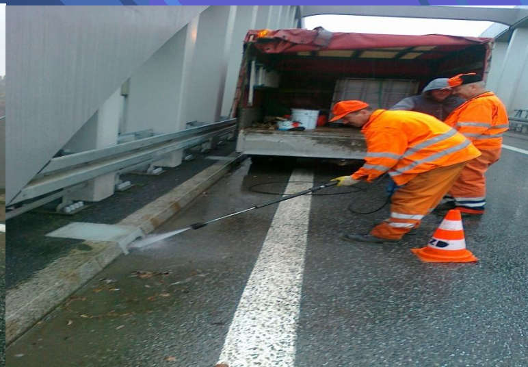
Fot. Czyszczenie elementów odwodnienia na obiektach mostowych
