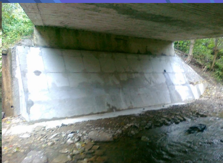
Fot. Remont obiektu mostowego na potoku Łapszanka w ciągu drogi powiatowej 1641K Łapsze Wyżne – Jurgów w km 0+179 – po remoncie
