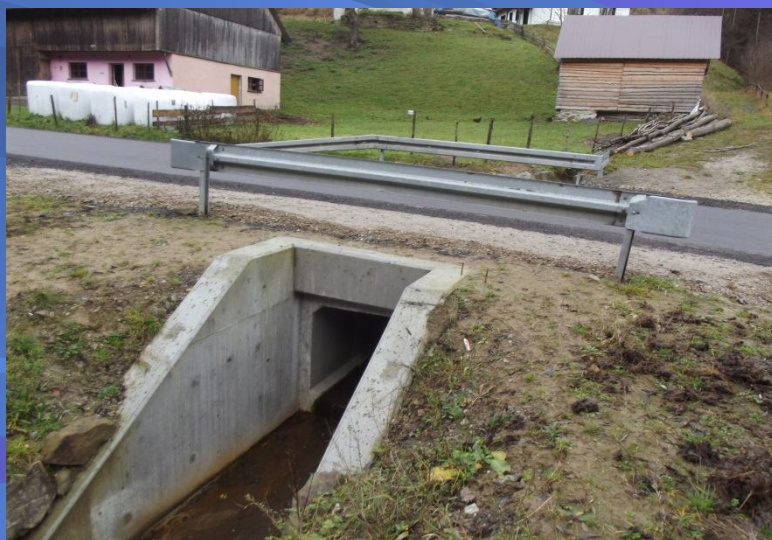
Fot. Remont przepustu w ciągu drogi powiatowej nr 1637K Harkłowa – Tylmanowa w km 7+571 w miejscowości Ochotnica Górna – po remoncie – wyremontowano przepust niedrożny na którym powstawały częste zapadnięcia nawierzchni
