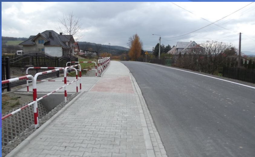
Fot. odcinek drogi powiatowej nr 1678K Raba Wyżna – Podwilk – po przebudowie
