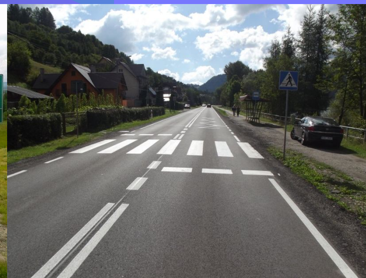
Fot. Wykonanie i odnowienie oznakowanie poziome dróg powiatowych
