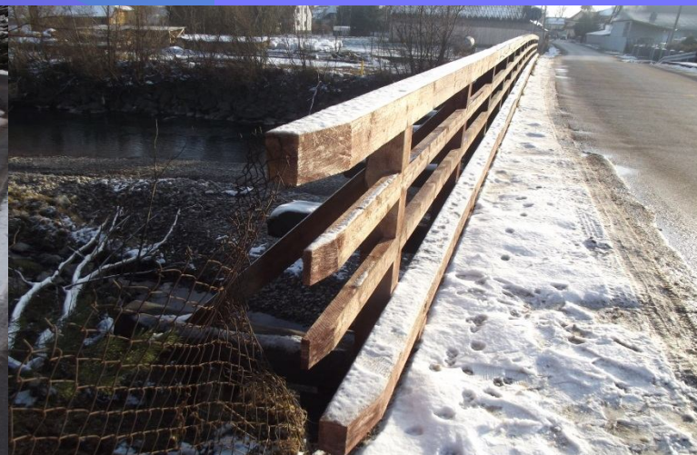
Fot. Naprawa barieroporęczy mostowej na wiadukcie kolejowym w ciągu drogi powiatowej nr 1660K Ludźmierz – Pyzówka w km 8+677 w miejscowości Pyzówka oraz naprawa zniszczonych fragmentów balustrady drewnianej na obiekcie mostowym na potoku Czarny Dunajec w ciągu drogi powiatowej nr 1663K Długopole – Pieniążkowice – Piekielnik w km 0+208 w miejscowości Długopole – po remoncie
