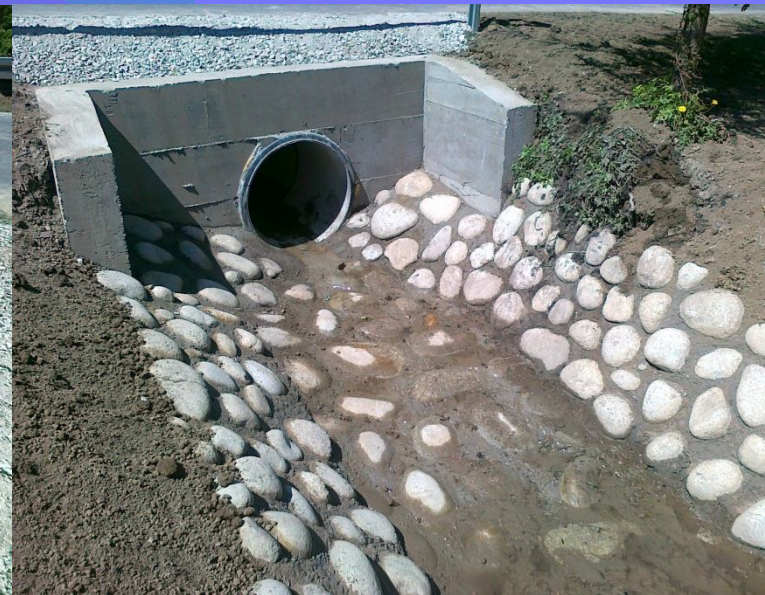
Fot. Odbudowy wlotów i wylotów przepustów drogowych rurowych
