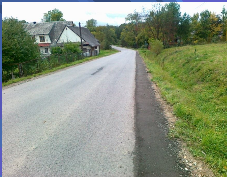
Fot. Remont i uzupełnienie ubytków poboczy
