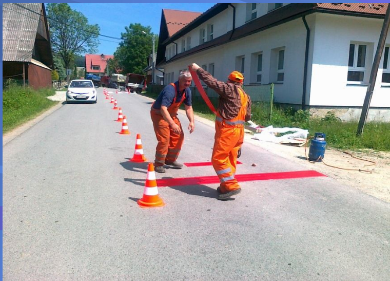
Fot. Montaż progów akustycznych na drogach powiatowych
