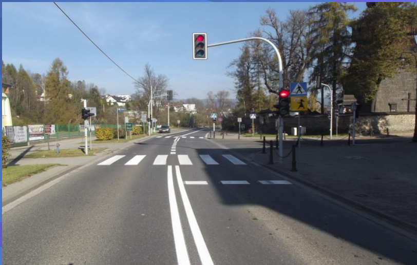
Fot. zmodernizowana sygnalizacja świetlna na skrzyżowaniu ul. Sądeckiej z ul. Władysława Orkana
