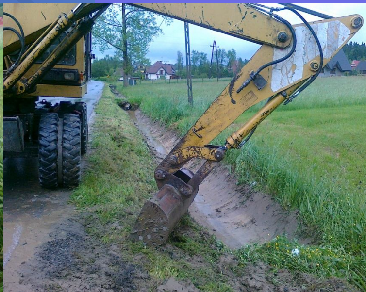
Fot. odtworzenie i oczyszczenie rowów odwadniających
