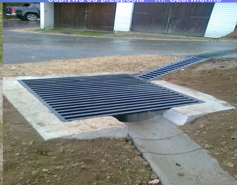
Fot. Wykonanie studni wpadowej wraz z kratą stalową
