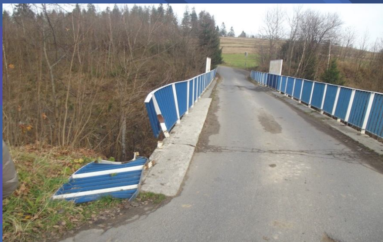
Fot. Naprawa barieroporęczy mostowej na wiadukcie kolejowym w ciągu drogi powiatowej nr 1660K Ludźmierz – Pyzówka w km 8+677 w miejscowości Pyzówka oraz naprawa zniszczonych fragmentów balustrady drewnianej na obiekcie mostowym na potoku Czarny Dunajec w ciągu drogi powiatowej nr 1663K Długopole – Pieniążkowice – Piekielnik w km 0+208 w miejscowości Długopole – przed remontem
