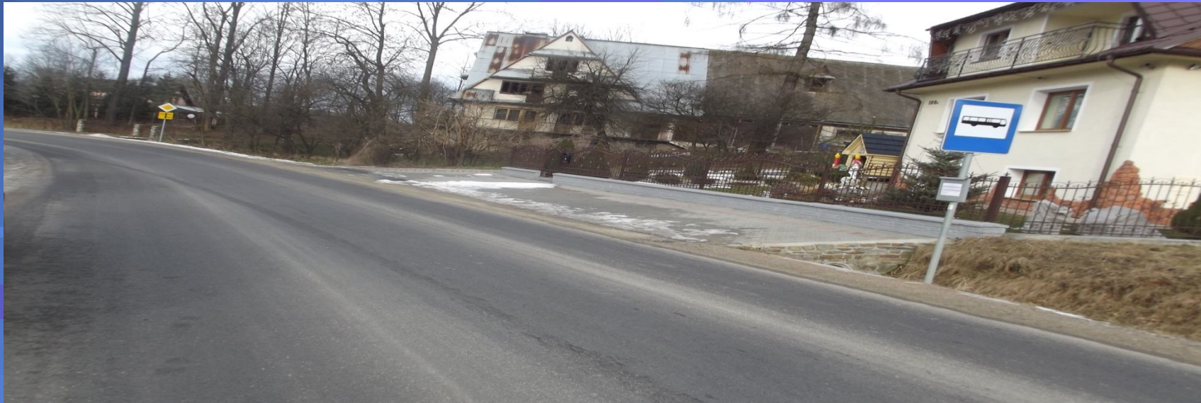
Fot. odcinek drogi powiatowej nr 1651K Czarny Dunajec – Poronin – po remoncie
