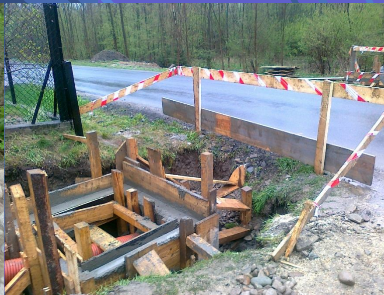
Fot. Odbudowy wlotów i wylotów przepustów drogowych rurowych m. Ponice – podczas robót
