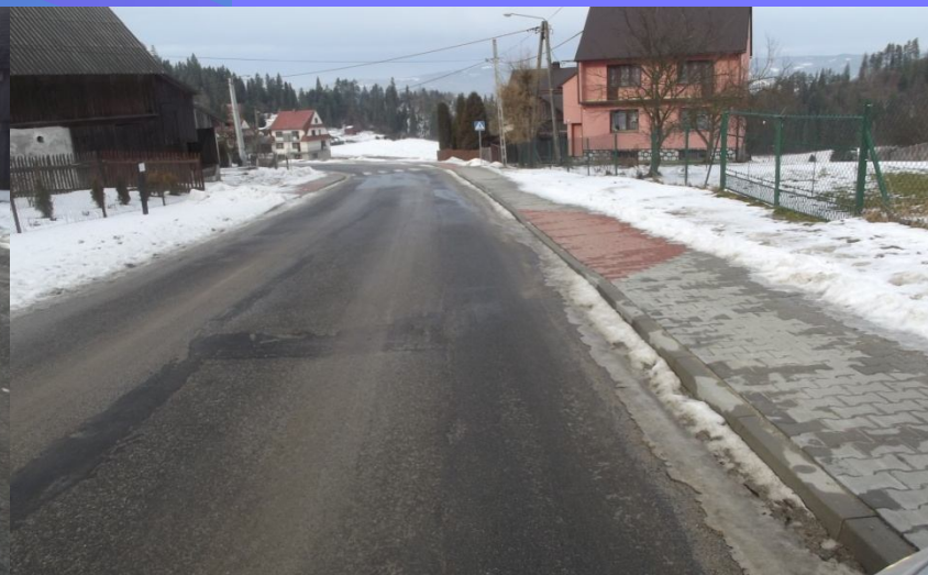
Fot. odcinek drogi powiatowej nr 1644K Łopuszna - Dursztyn – po przebudowie
