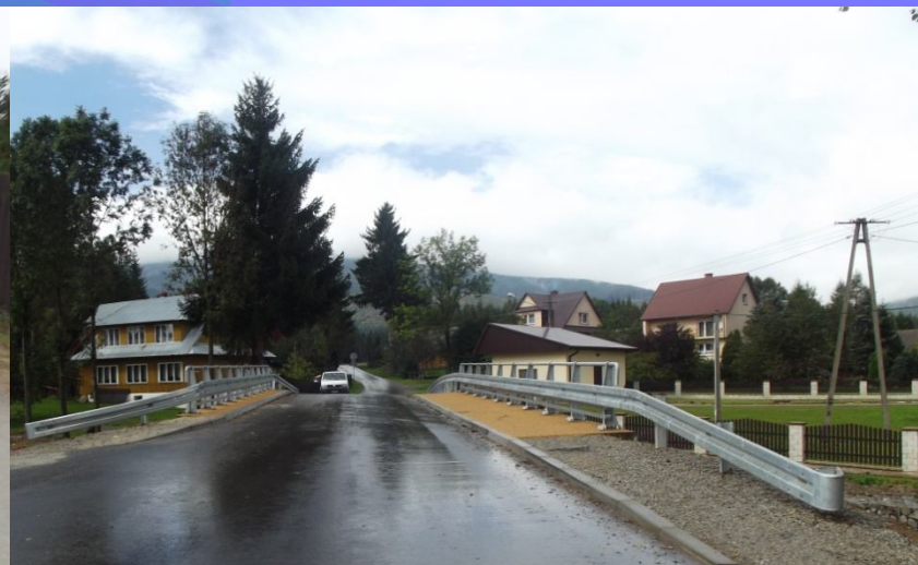
Fot. obiekt mostowy na potoku Portasowy w ciągu drogi powiatowej nr 1675K Jabłonka – Lipnica Mała – po remoncie
