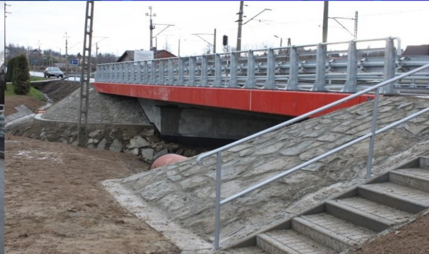
Fot. obiekt mostowy na potoku Stachorówka w ciągu drogi powiatowej nr 1668K Rabka Zdrój – Skawa – Naprawa – po odbudowie
