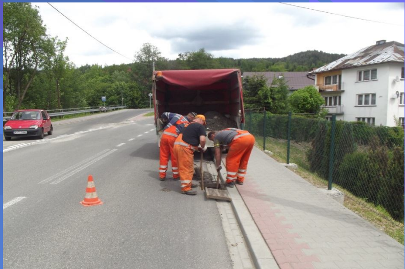
Fot. Czyszczenie i odmulanie studzienek kanalizacji burzowej
