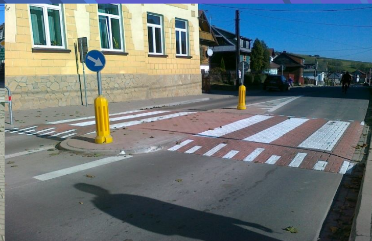
Fot. Wykonanie elementów bezpieczeństwa na sieci dróg powiatowych - wyniesione przejście dla pieszych w rejonie szkoły podstawowej w m. Łąpsze Wyżne
