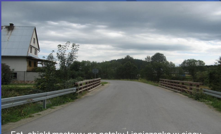
Fot. obiekt mostowy na potoku Lipniczanka w ciągu drogi powiatowej nr 1676K Lipnica Wielka – Przywarówka – przed przebudową
