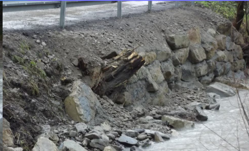
Fot. odcinek korpusu drogi powiatowej nr 1637K Harkłowa – Tylmanowa – po odbudowie
