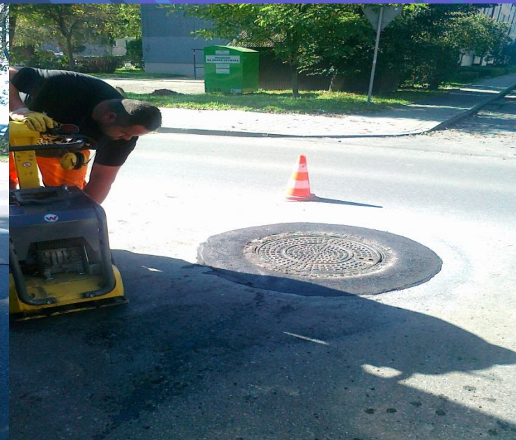
Fot. Regulacja wysokościowa i wymiana włączów kanałowych
