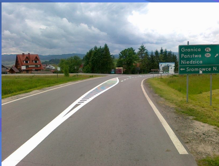
Fot. Wykonanie i odnowienie oznakowanie poziome dróg powiatowych
