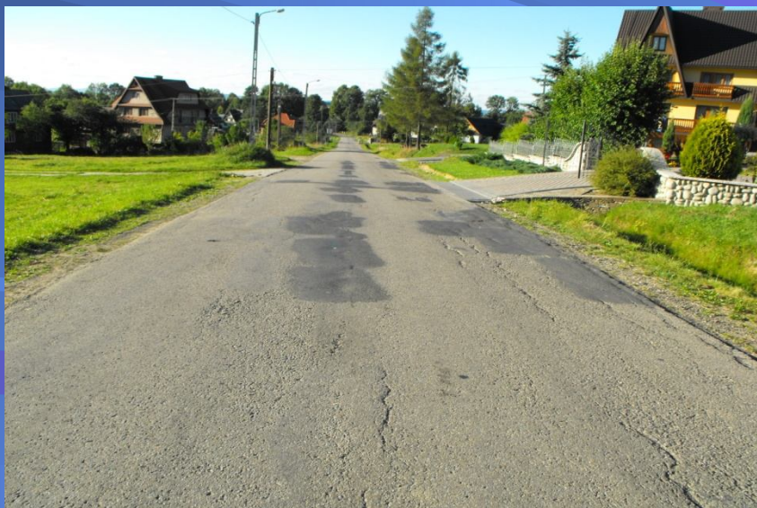
Fot. odcinek drogi powiatowej nr 1651K Czarny Dunajec – Poronin – przed remontem
