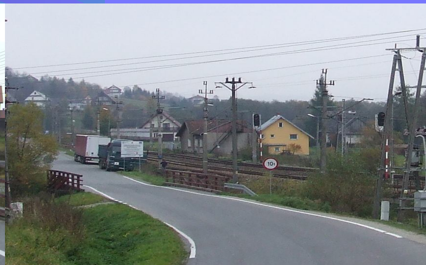
Fot. obiekt mostowy na potoku Stachorówka w ciągu drogi powiatowej nr 1668K Rabka Zdrój – Skawa – Naprawa – przed odbudową
