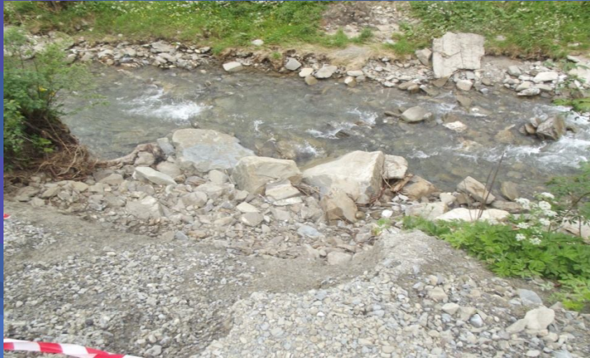
Fot. odcinek korpusu drogi powiatowej nr 1661K Trute – Klikuszowa – Obidowa – przed odbudową
