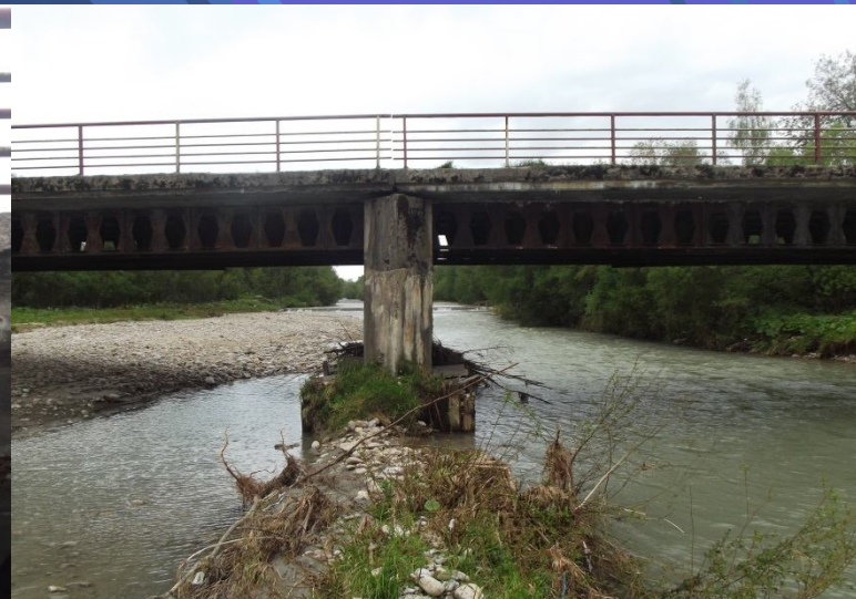
Fot. Zabezpieczenie filara mostowego w ciągu drogi powiatowej nr 1651K Czarny Dunajec – Poronin w km 0+787 w miejscowości Czarny Dunajec - przed remontem – widoczne pochylenie podmytego filara mostowego
