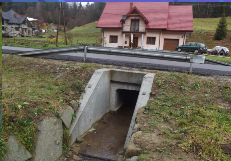
Fot. Remont przepustu w ciągu drogi powiatowej nr 1637K Harkłowa – Tylmanowa w km 7+250 w miejscowości Ochotnica Górna – po remoncie – wyremontowano przepust niedrożny na którym powstawały częste zapadnięcia nawierzchni
