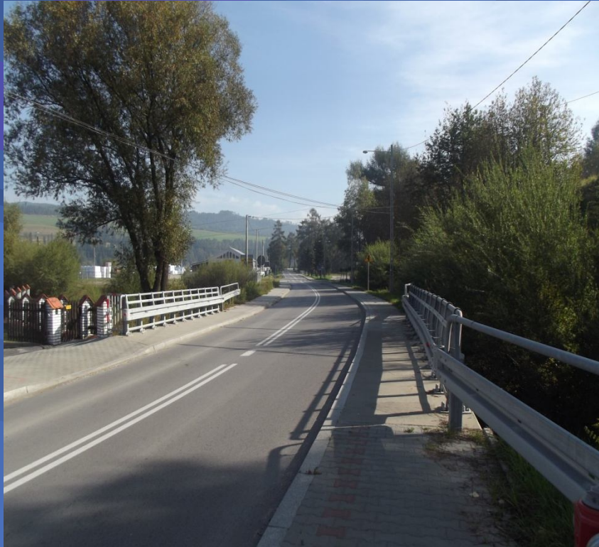
Fot. obiekt mostowy w ciągu drogi powiatowej nr 1673 ul. Waksmundzka w miejscowości Nowy Targ – po remoncie
