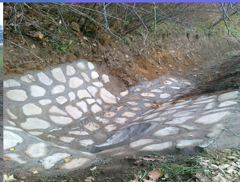
Fot. Wyremontowany przepust pod drogą powiatową 1636K Krościenko – Szczawnica w m. Szlachtowa
