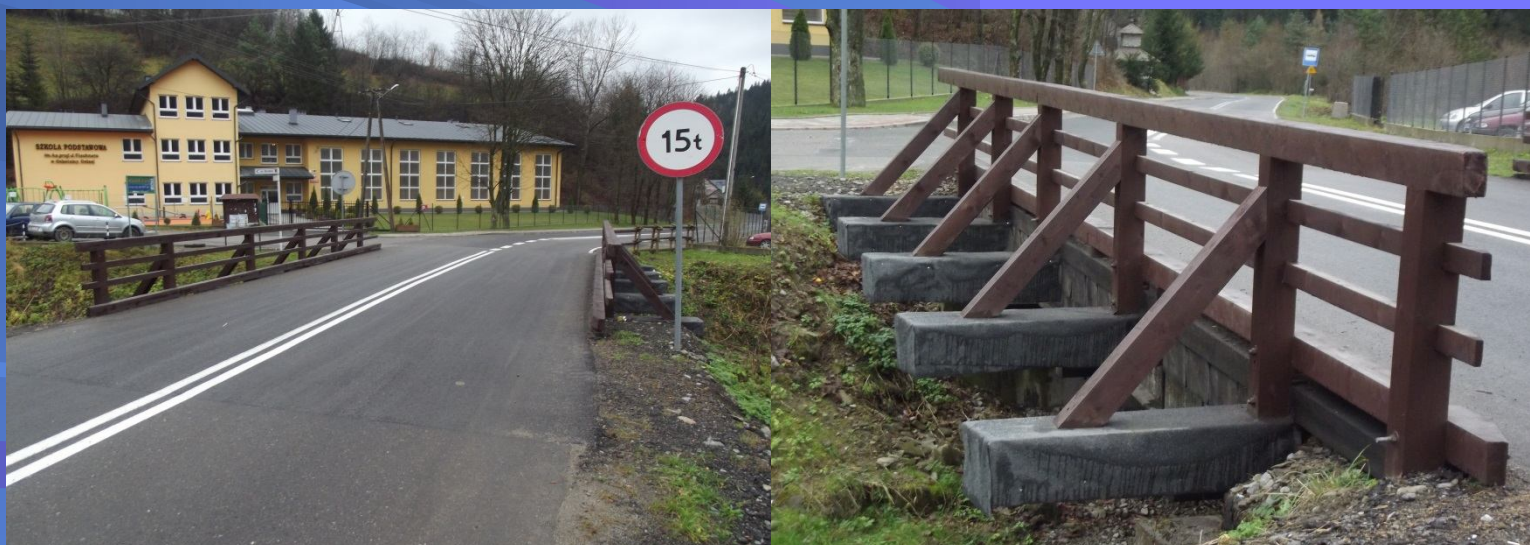
Fot. Remont pomostu drewnianego na potoku Skrodne w ciągu drogi powiatowej nr 1637K Harkłowa – Tylmanowa w km 15+887- po remoncie
