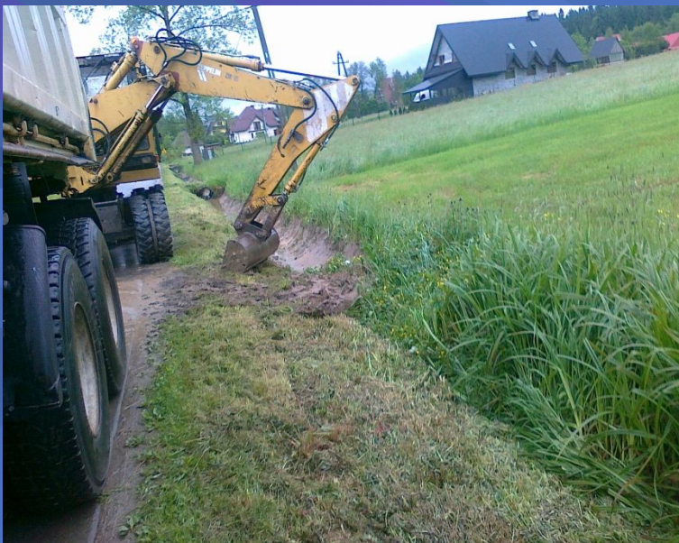
Fot. odtworzenie i oczyszczenie rowów odwadniających
