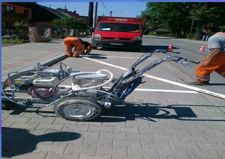
Fot. Wykonanie oznakowania poziomego na drogach powiatowych
