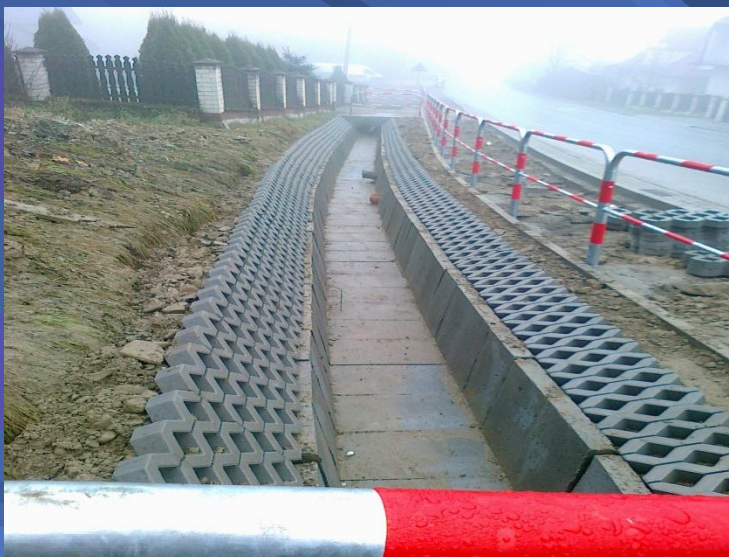
Fot. odcinek drogi podczas prac budowlanych w m. Harkabuz
