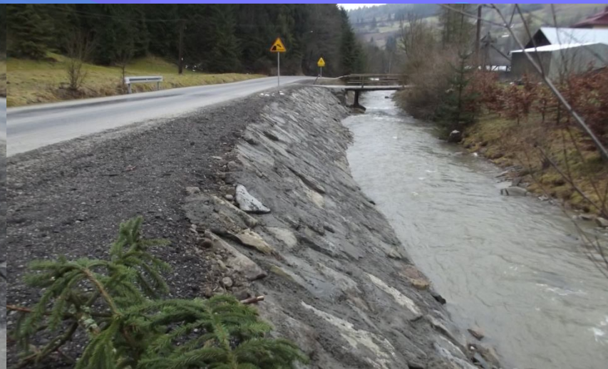
Fot. odcinek korpusu drogi powiatowej nr 1661K Trute – Klikuszowa – Obidowa – po odbudowie
