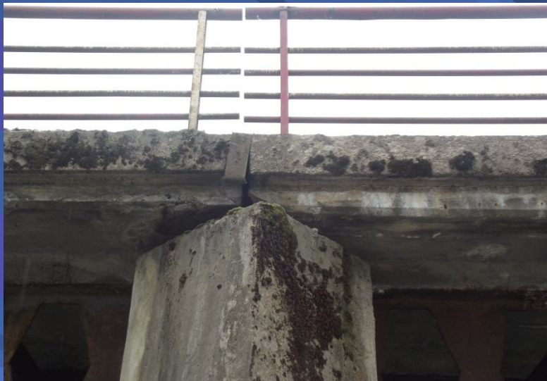
Fot. Zabezpieczenie filara mostowego w ciągu drogi powiatowej nr 1651K Czarny Dunajec – Poronin w km 0+787 w miejscowości Czarny Dunajec - przed remontem – widoczne pochylenie podmytego filara mostowego
