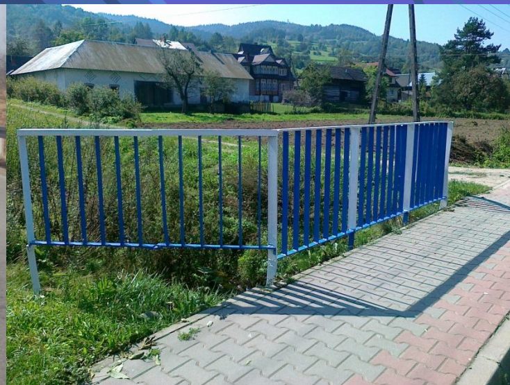
Fot. Montaż barierek ochronnych – m. Ochotnica D.
