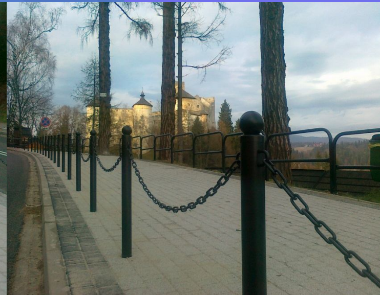
Fot. Remont chodnika w miejscowości Niedzica Zamek
