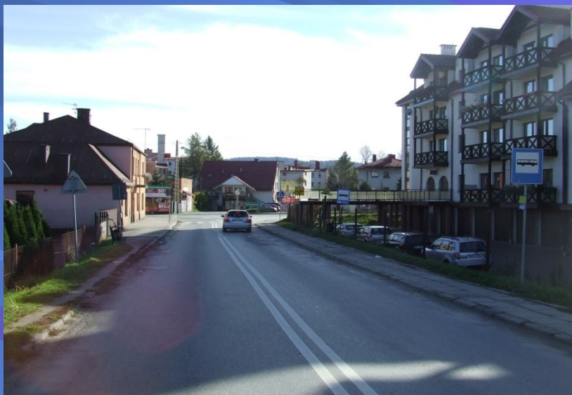
Fot. droga powiatowa nr 1668K Rabka – Skawa – Naprawa – przed modernizacją
