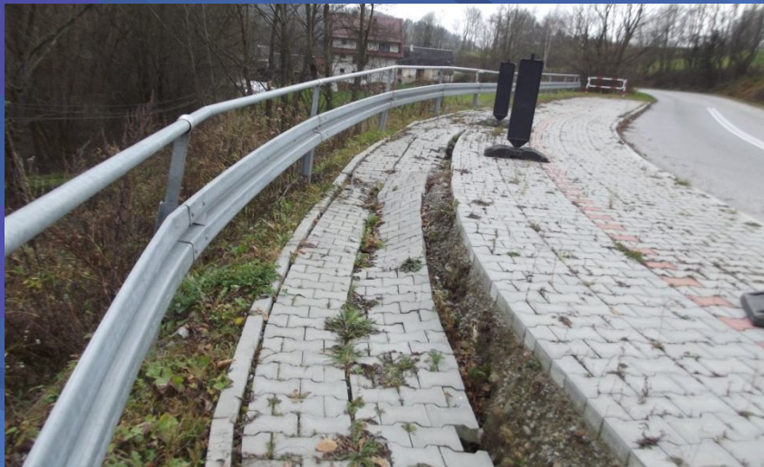
Fot. odcinek korpusu i chodnika w ciągu drogi powiatowej nr 1638K Krośnica – Sromowce Niżne – przed odbudową
