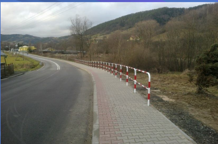
Fot. Montaż barierek ochronnych wzdłuż chodnika w miejscowości Ochoćnica Dolna na długości 50mb
