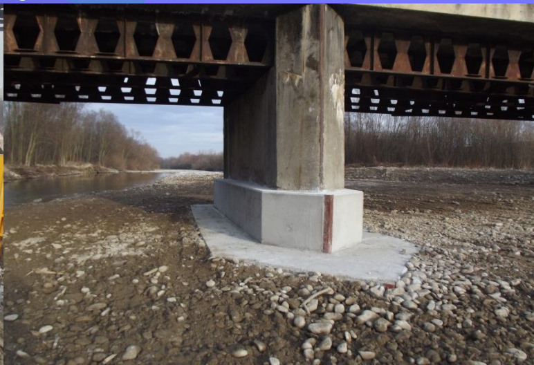
Fot. Zabezpieczenie filara mostowego w ciągu drogi powiatowej nr 1651K Czarny Dunajec – Poronin w km 0+787 w miejscowości Czarny Dunajec - w trakcie i po remoncie
