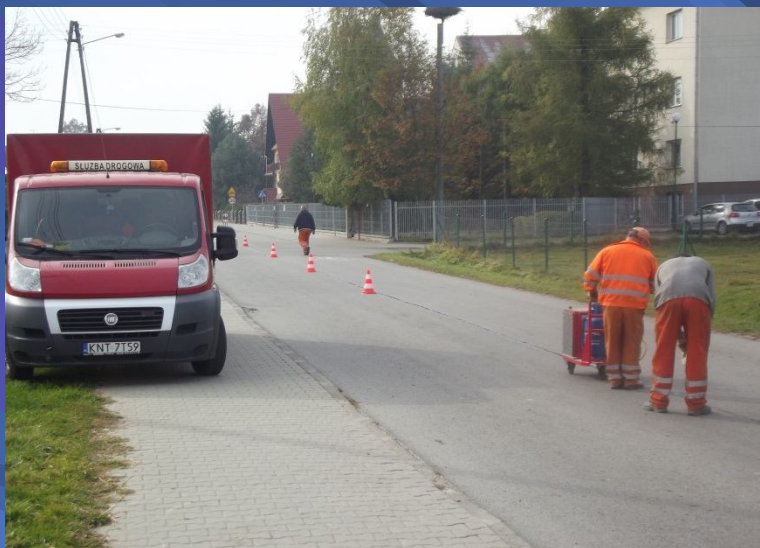
Fot. Zalewanie pęknięć nawierzchni masą na gorąco
