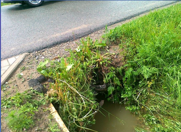
Fot. Odbudowy wlotów i wylotów przepustów drogowych rurowych – przed pracami – m. Lipnica Mała
