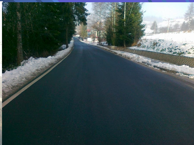
Fot. Odcinek drogi powiatowej 1662K Raba Wyżna – Klikuszowa w miejscowości Sieniawa po przebudowie
