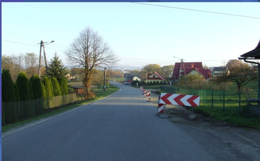
Fot. odcinek drogi powiatowej nr 1668K Rabka – Skawa – Naprawa – przed przebudową
