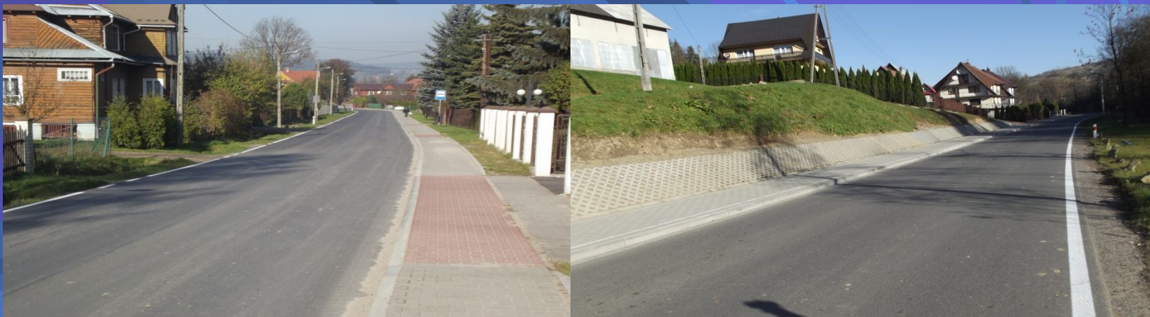
Fot. odcinek drogi powiatowej nr 1667K Rabka Zdrój – Ponice – po modernizacji
