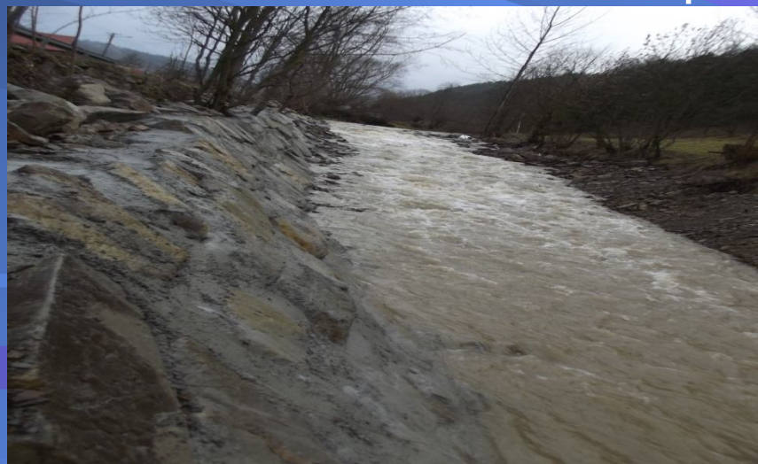
Fot. odcinek korpusu drogi powiatowej nr 1637K Harkłowa – Tylmanowa – po remoncie
