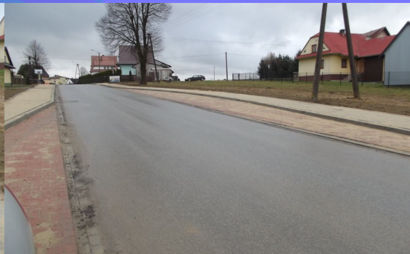
Fot. odcinek drogi powiatowej nr 1668K Rabka – Skawa - Naprawa – po przebudowie
