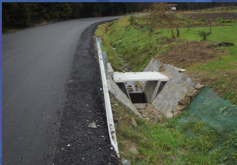
Fot. Remont przepustu w ciągu drogi powiatowej nr 1637K Harkłowa – Tylmanowa w km 7+250 w miejscowości Ochotnica Górna – po remoncie – wyremontowano przepust niedrożny na którym powstawały częste zapadnięcia nawierzchni
