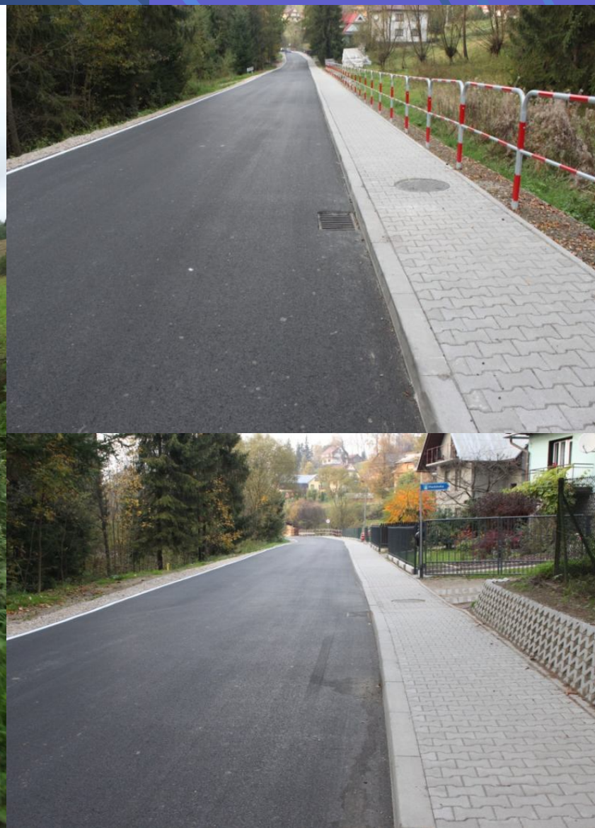
Fot. odcinek drogi powiatowej nr 1662K Raba Wyżna - Klikuszowa – po przebudowie
