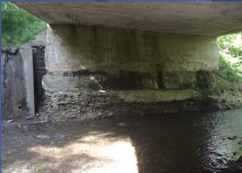
Fot. Remont obiektu mostowego na potoku Łapszanka w ciągu drogi powiatowej 1641K Łapsze Wyżne – Jurgów w km 0+179 – przed robotami budowlanymi
