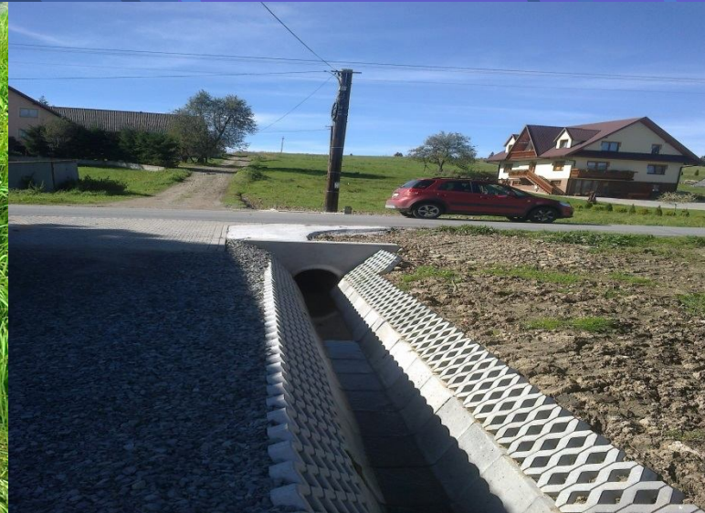
Fot. Odbudowy wlotów i wylotów przepustów drogowych rurowych – po wykonaniu prac – m. Lipnica Mała
