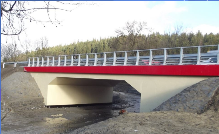
Fot. odcinek drogi powiatowej nr 1676K Lipnica Wielka – Przywarówka – po przebudowie
