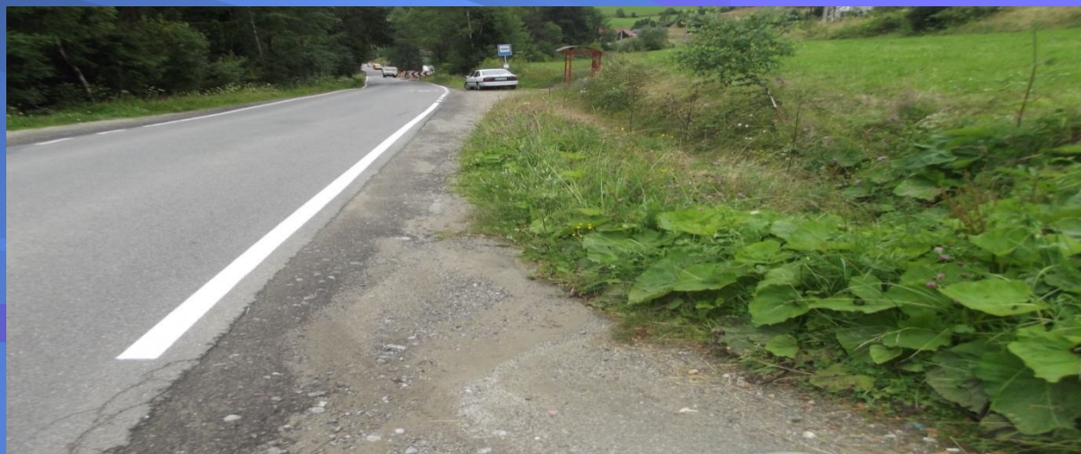
Fot. odcinek drogi powiatowej nr 1662K Raba Wyżna - Klikuszowa – przed przebudową
