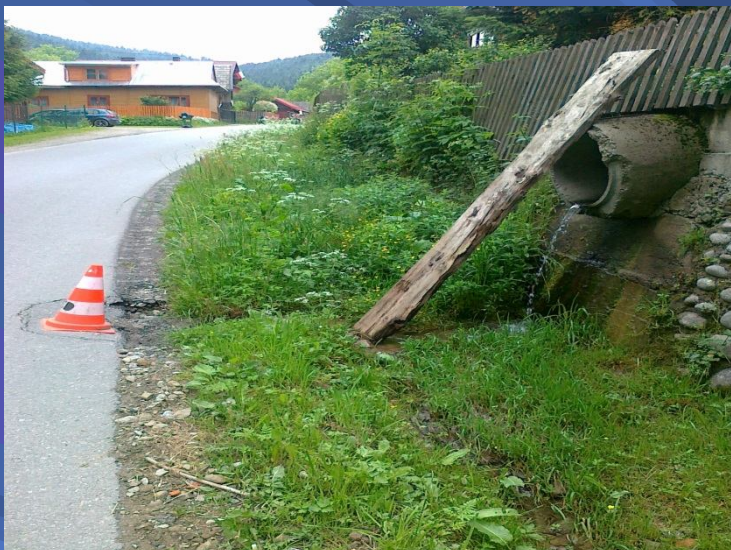
Fot. Oberwany i zniszczony korpus drogi wraz z odpływem – przed pracami
