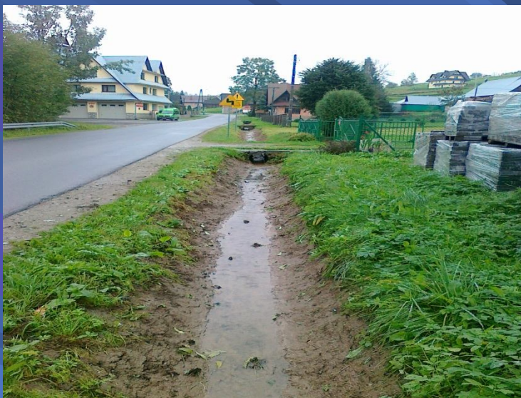
Fot. odtworzenie i oczyszczenie rowów odwadniających
