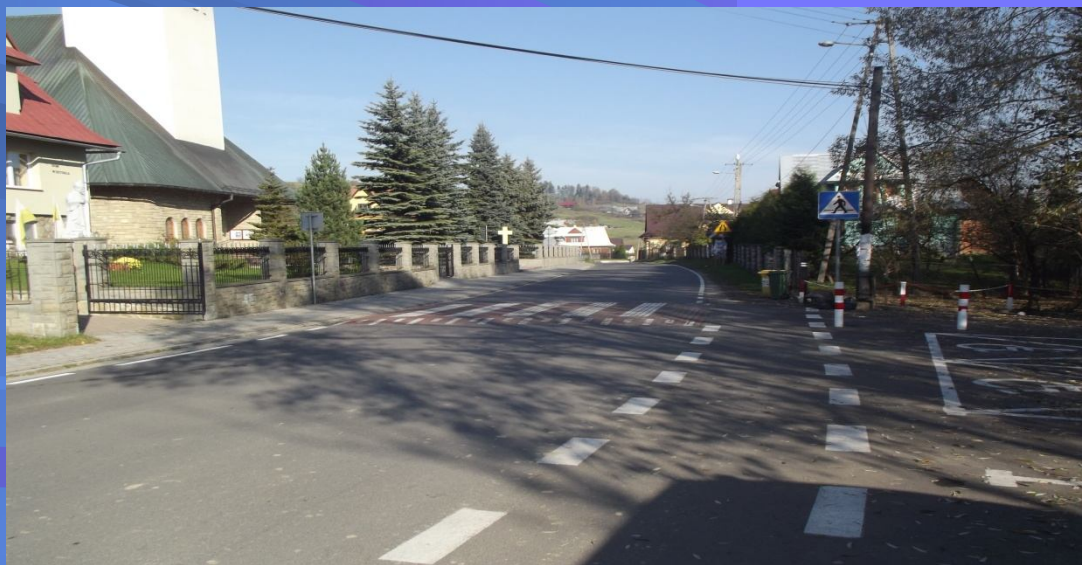
Fot. odcinek drogi powiatowej nr 1666K Ponice – Rdzawka – po modernizacji
