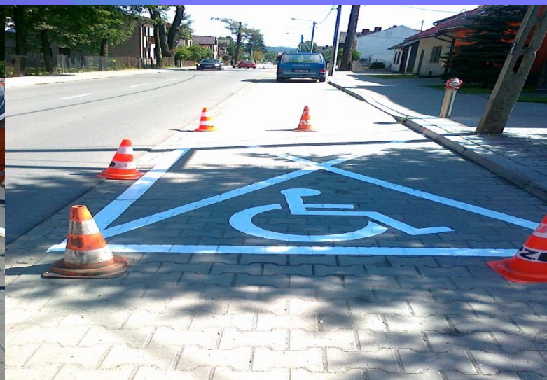
Fot. Wykonanie oznakowania poziomego na drogach powiatowych
