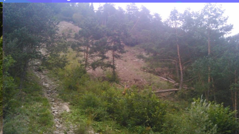
Fot. osuwisko Macelowa Góra w ciągu drogi powiatowej nr 1638K Krośnica – Sromowce Niżne – przed stabilizacją i zabezpieczeniem drogi
