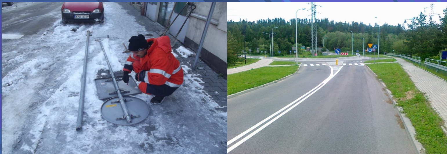
Fot. Wymiana, uzupełnienie, poprawa oznakowania pionowego
