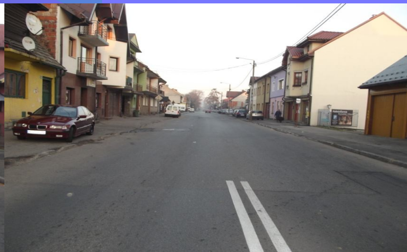
Fot. odcinek drogi powiatowej nr 1673 ul. Waksmundzka w miejscowości Nowy Targ – przed przebudową
