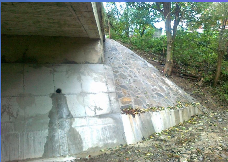
Fot. Remont obiektu mostowego na potoku Łapszanka w ciągu drogi powiatowej 1641K Łapsze Wyżne – Jurgów w km 0+179 – po remoncie
