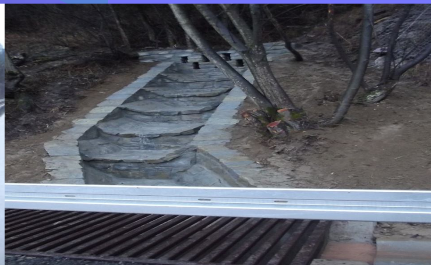
Fot. osuwisko Macelowa Góra w ciągu drogi powiatowej nr 1638K Krośnica – Sromowce Niżne – po wykonaniu stabilizacji i zabezpieczenia drogi
