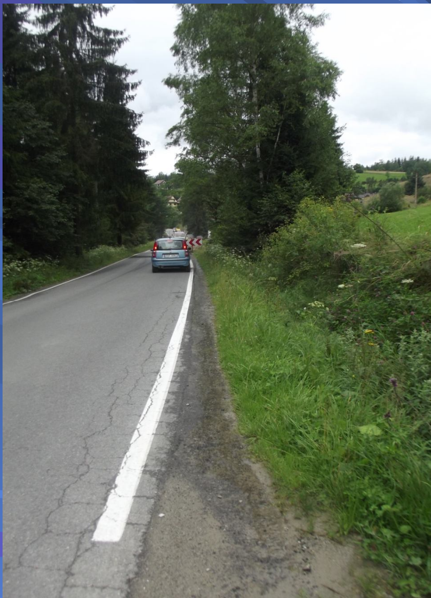
Fot. odcinek drogi powiatowej nr 1662K Raba Wyżna - Klikuszowa – przed przebudową
