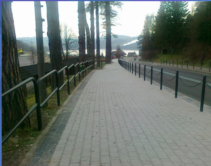
Fot. Remont chodnika w miejscowości Niedzica Zamek
