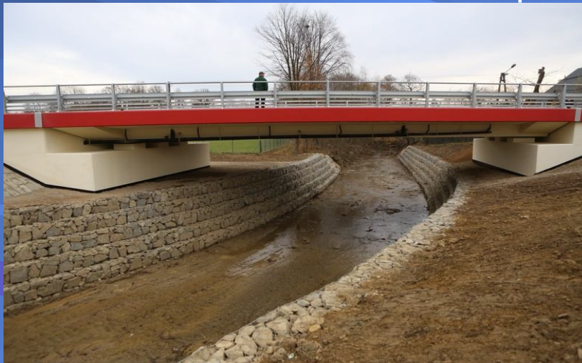
Fot. obiekt mostowy na potoku Skawa w ciągu drogi powiatowej nr 1669K Jordanów – Spytkowice – po odbudowie
