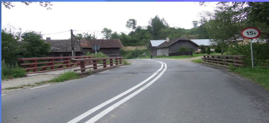
Fot. obiekt mostowy na pot. Luboński w ciągu drogi powiatowej nr 1637K Harkłowa – Tylmanowa – przed remontem
