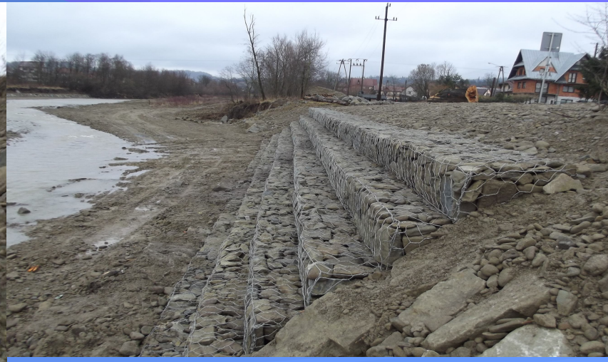
Fot. odcinek korpusu drogi powiatowej nr 1661K Trute – Klikuszowa – Obidowa – po odbudowie
