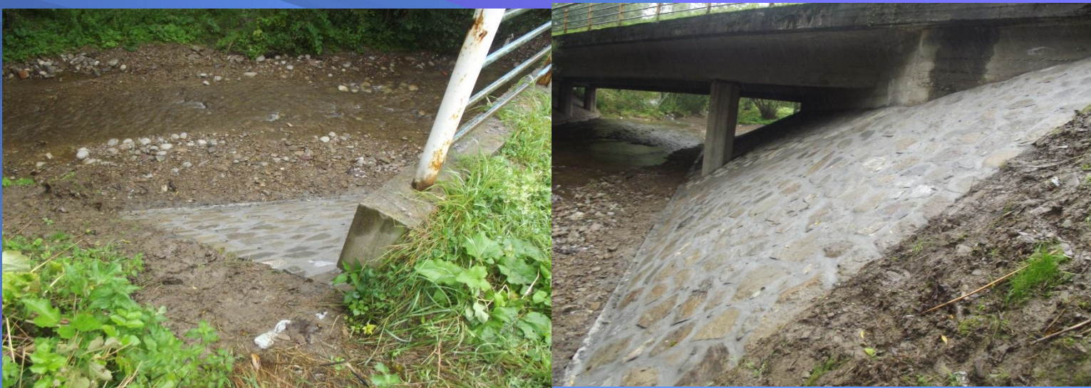
Fot. Zabezpieczenie fundamentu skrajnego przez obrukowanie skarpy na obiekcie mostowym w ciągu drogi powiatowej nr 1654K Ząb – Ratułów – Ciche – Chochołów w km 8+731 w miejscowości Czerwienne – po remoncie
