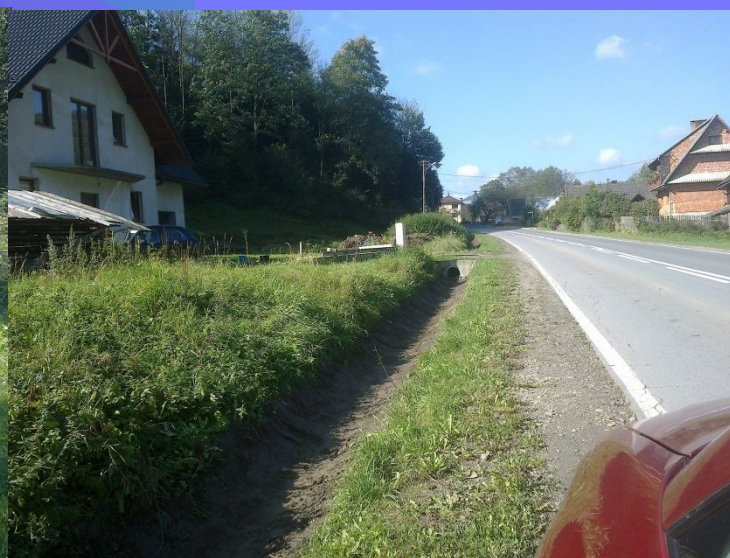
Fot. odtworzenie i oczyszczenie rowów odwadniających
