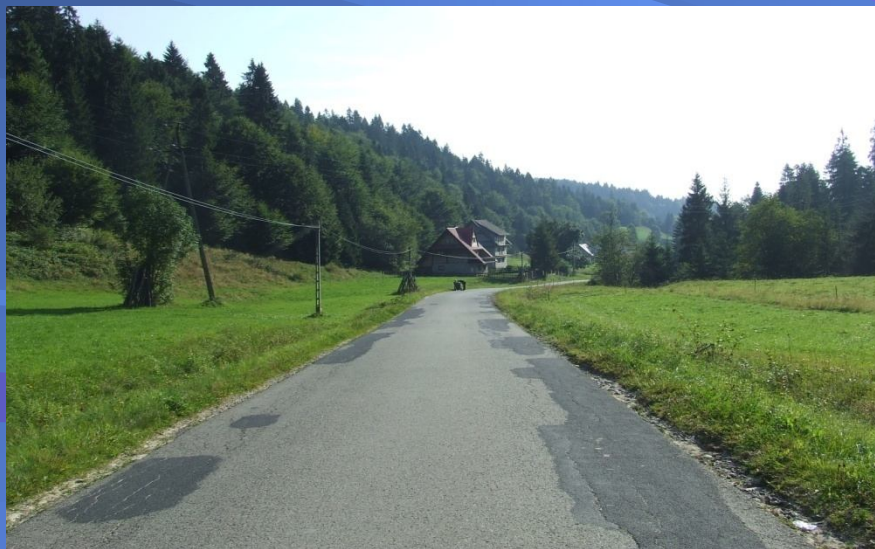
Fot. odcinek drogi powiatowej nr 1637K Harkłowa – Tylmanowa od km 6+000 do km 8+500 – przed remontem
