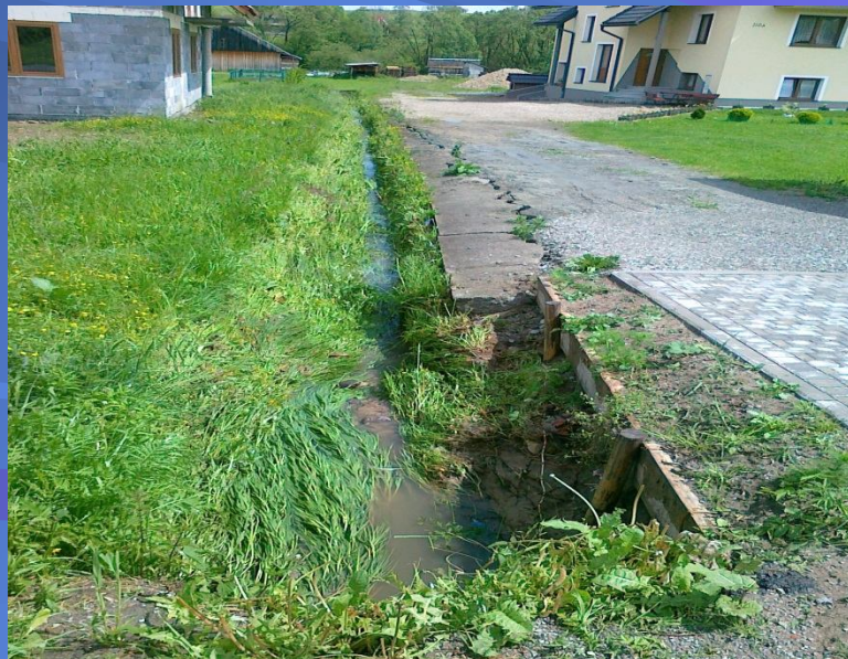
Fot. Odbudowa odpływu od przepustu drogowego – przed pracami – m. Lipnica Mała
