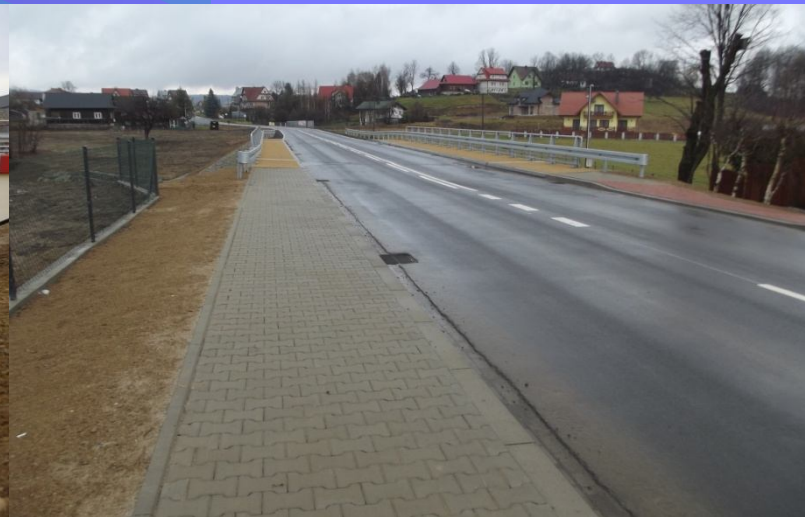
Fot. obiekt mostowy na potoku Skawa w ciągu drogi powiatowej nr 1669K Jordanów – Spytkowice – po odbudowie
