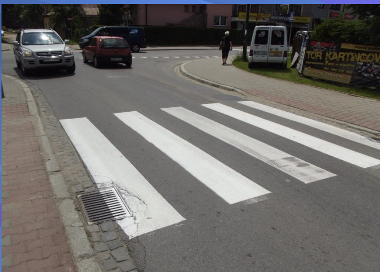
Fot. Wykonanie oznakowania poziomego na drogach powiatowych
