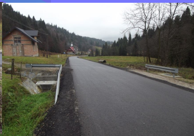
Fot. Remont przepustu w ciągu drogi powiatowej nr 1637K Harkłowa – Tylmanowa w km 7+571 w miejscowości Ochotnica Górna – po remoncie – wyremontowano przepust niedrożny na którym powstawały częste zapadnięcia nawierzchni
