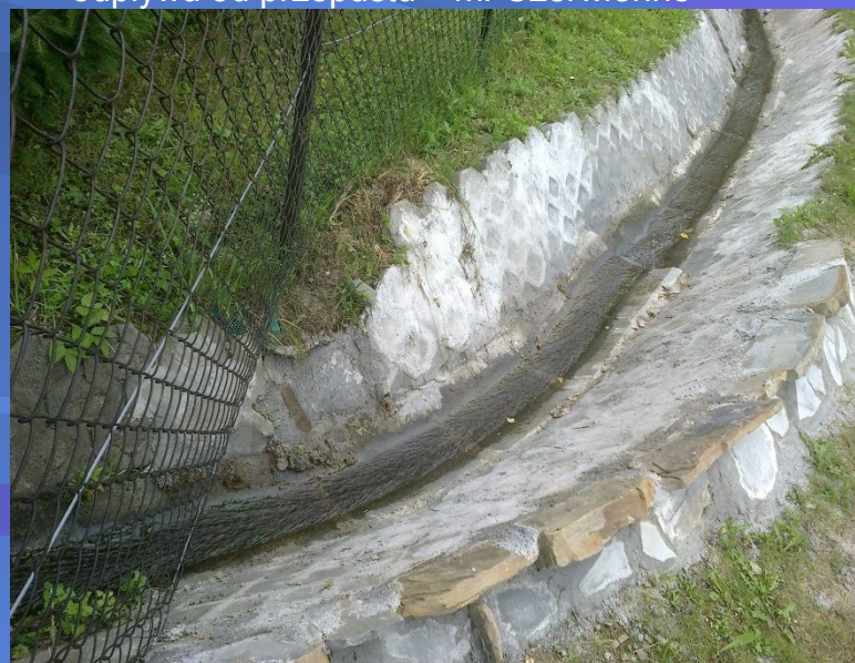
Fot. Wykonanie, wymiana korytek ściekowych betonowych odpływu od przepustu – m. Sieniawa
