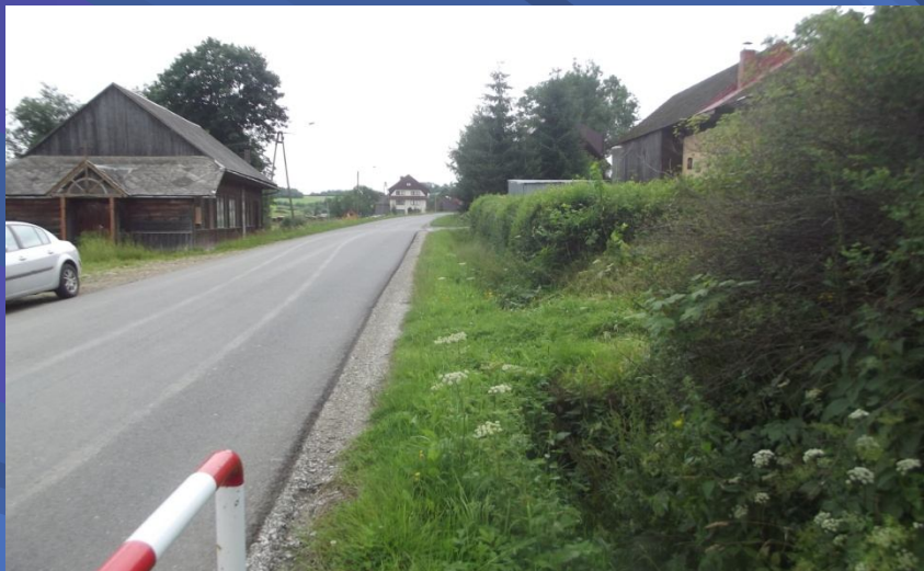
Fot. odcinek drogi powiatowej nr 1678K Raba Wyżna – Podwilk – przed przebudową
