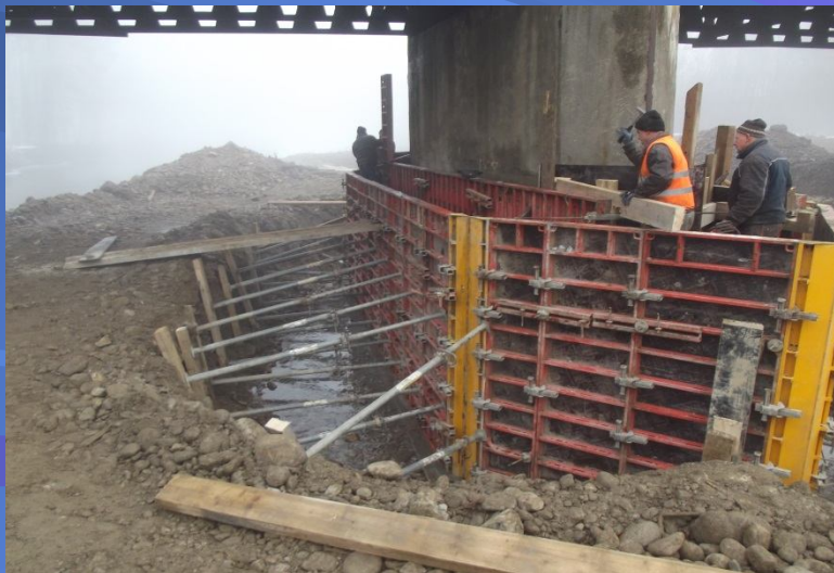
Fot. Zabezpieczenie filara mostowego w ciągu drogi powiatowej nr 1651K Czarny Dunajec – Poronin w km 0+787 w miejscowości Czarny Dunajec - w trakcie i po remoncie
