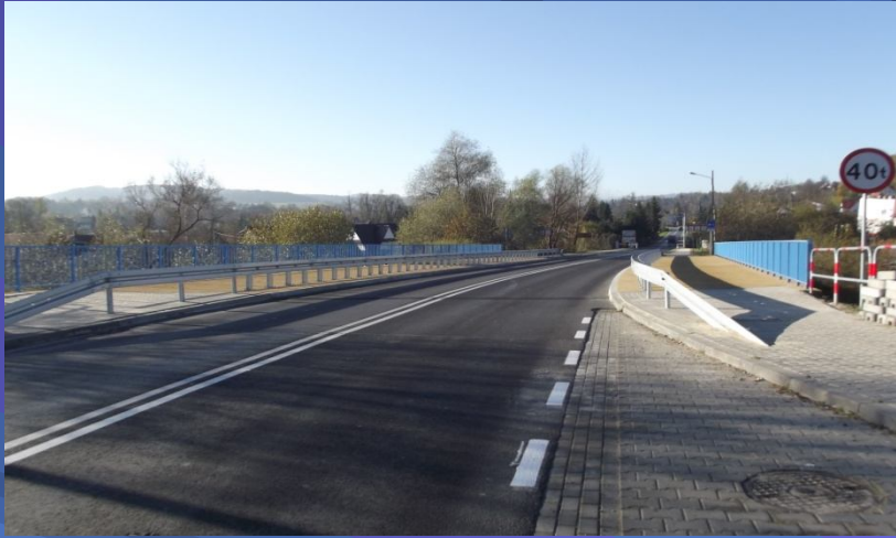
Fot. obiekt mostowy na potoku Skomielniczanka w ciągu drogi powiatowej nr 1668K Rabka – Skawa – Naprawa – po modernizacji
