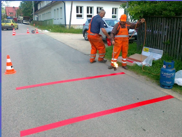
Fot. Montaż progów akustycznych na drogach powiatowych
