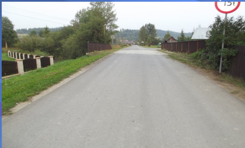
Fot. obiekt mostowy na potoku Portasowy w ciągu drogi powiatowej nr 1675K Jabłonka – Lipnica Mała – po remoncie
