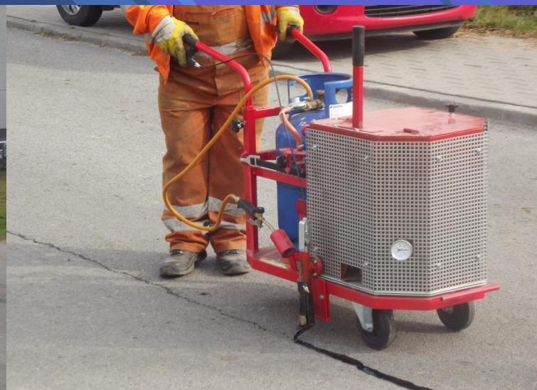
Fot. Zalewanie pęknięć nawierzchni masą na gorąco
