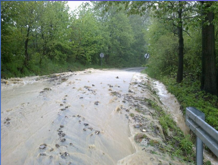
Fot. remont podmytego i uszkodzonego muru oporowego, pobocza drogi powiatowej 1636K Krościenko – Szczawnica – wystąpienie intensywnych opadów
