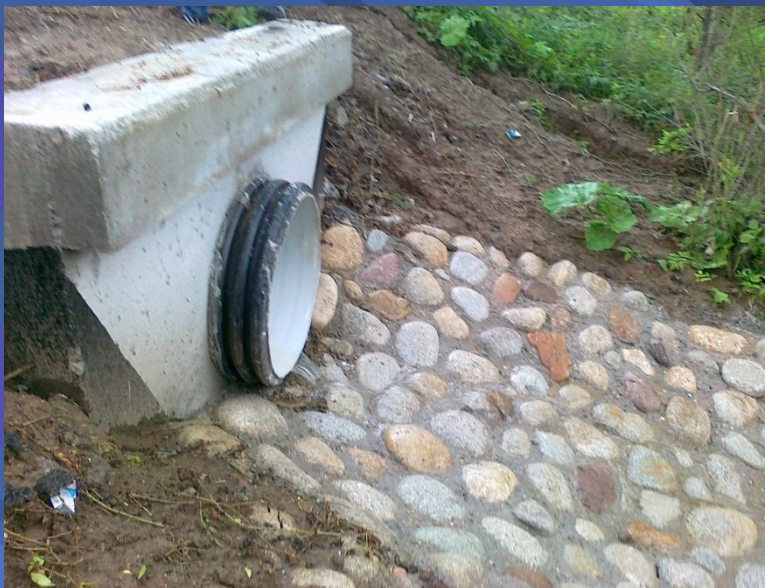
Fot. Odbudowy wlotów i wylotów przepustów drogowych rurowych – m. Lipnica Mała
