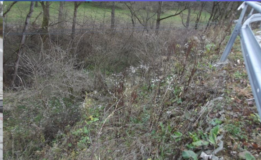
Fot. odcinek korpusu i chodnika w ciągu drogi powiatowej nr 1638K Krośnica – Sromowce Niżne – przed odbudową
