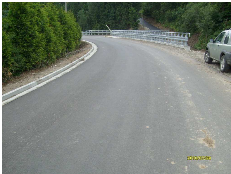
fot. po przebudowie K1637 Harkłowa-Tylmanowa.
