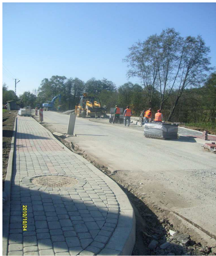
fot. odcinek drogi K1678 w czasie przebudowy
