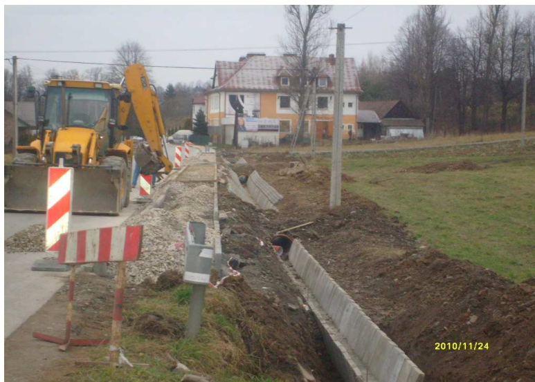
fot. droga K1668 w czasie przebudowy
