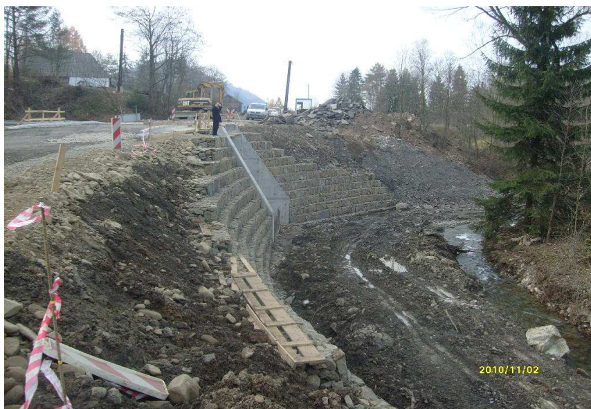
fot. obiekty mostowe w trakcie przebudowy
