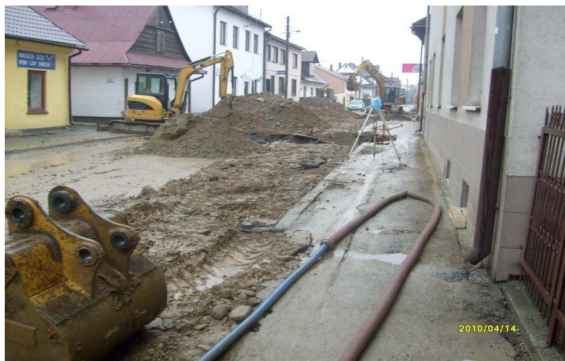
fot. odcinek drogi powiatowej w czasie przebudowy
