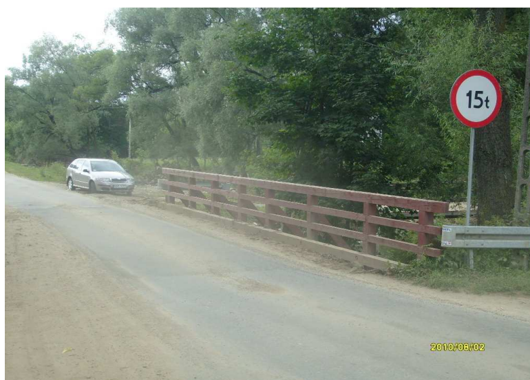
fot. obiekt mostowy do przebudowy K1642 Groń – Trybsz – Niedzica w km 3+770 na Czarnogórskiej Rzece,
