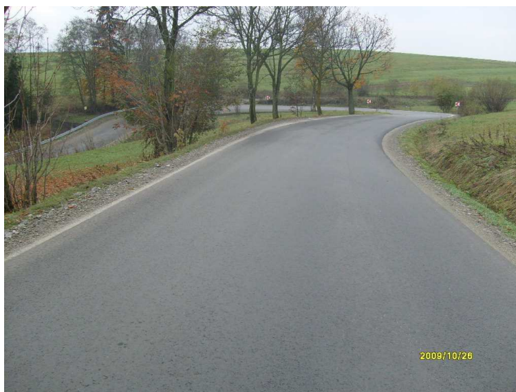
fot. po przebudowie K1651 Czarny Dunajec-Poronin
