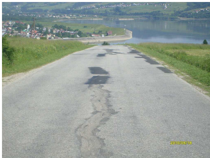
fot. przed przebudową K1639
