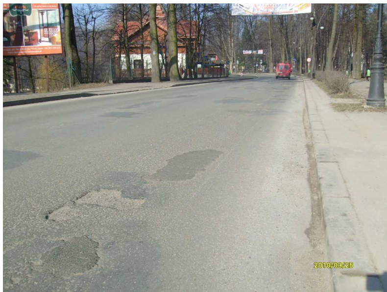
fot. odcinek drogi K1636 przed przebudową
