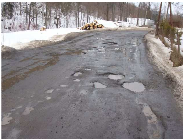
fot. przed przebudową K1667 Rabka – Zdrój – Ponice w m. Ponice
