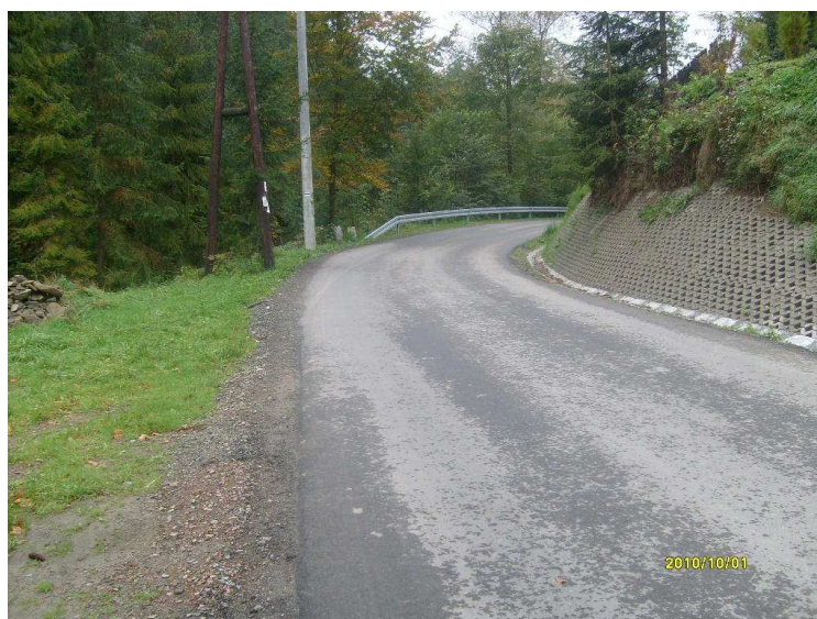
fot. po przebudowie K1667 Rabka – Zdrój – Ponice w m. Ponice
