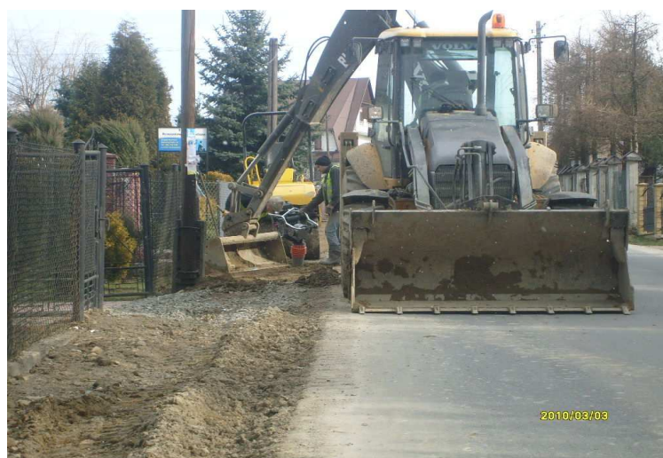
fot. droga K1665 w trakcie przebudowy
