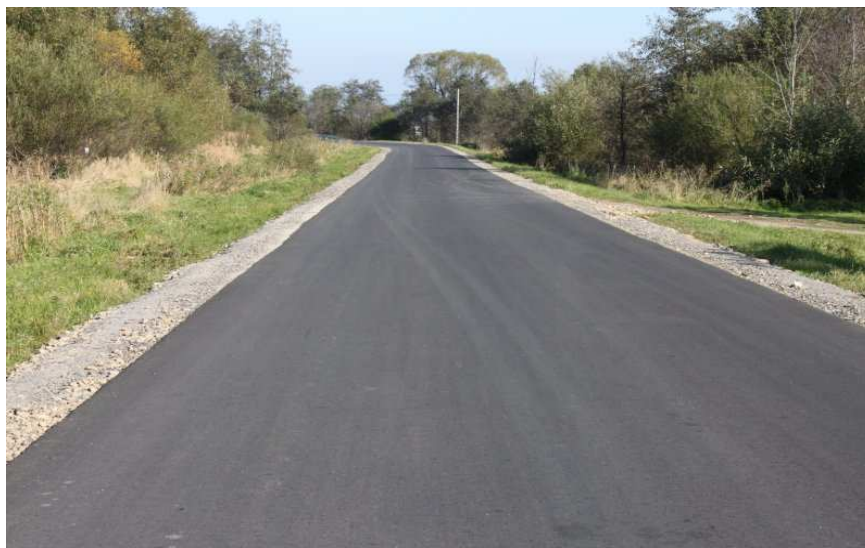
fot. droga K1659 po przebudowie
