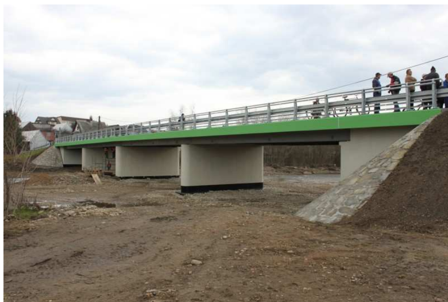
fot. Odbudowa mostu na potoku Czarny Dunajec w km 7+732 w ciągu drogi powiatowej nr K1659 Ludźmierz-Czarny Dunajec
