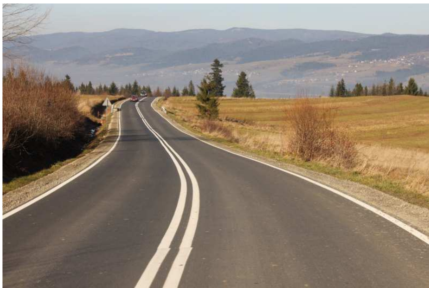
fot. po przebudowie K1639
