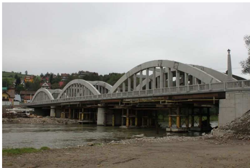
fot. nowy bliźniaczy obiekt mostowy
