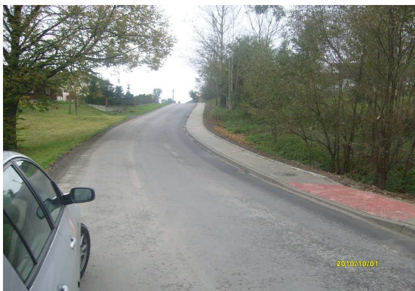
fot. droga K1665 po przebudowie
