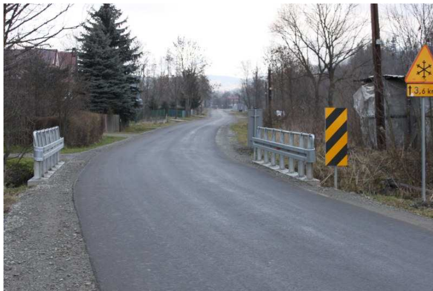
fol. Odbudowa drogi powiatowej nr K1661 Trute-Klikuszowa-Obidowa od km 3+700 do km 9+090
