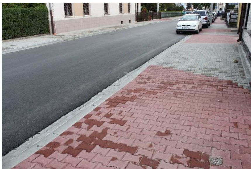
fot. odcinek drogi powiatowej po przebudowie
