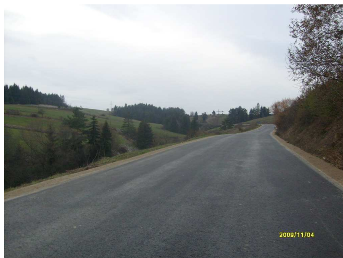
fot. po przebudowie K1642 Groń-Trybsz-Niedzica
