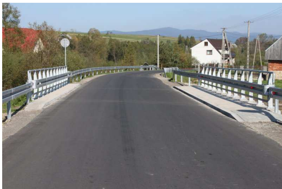
fot. droga K1659 po przebudowie
