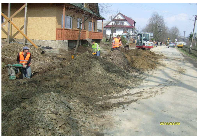
fot. odcinek drogi powiatowej w czasie przebudowy
