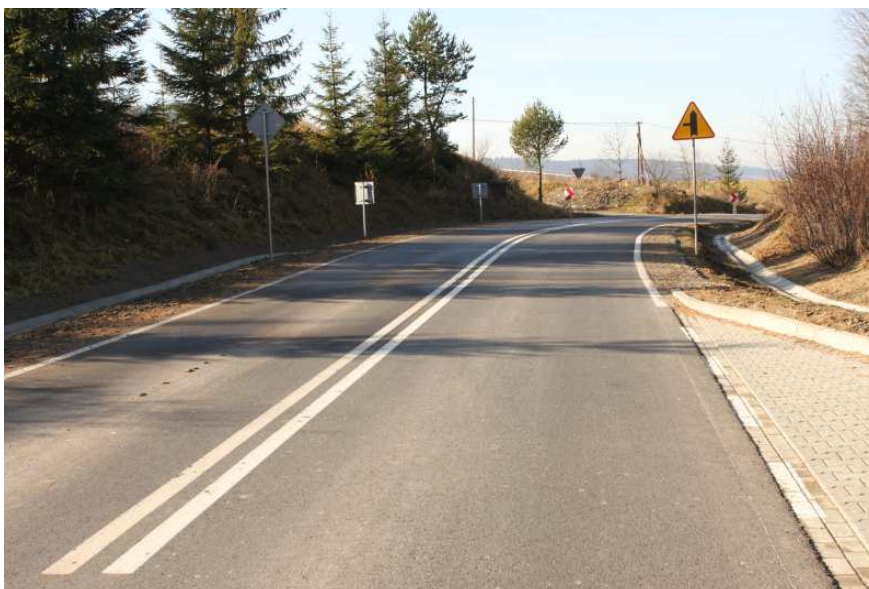
fot. po przebudowie K1639
