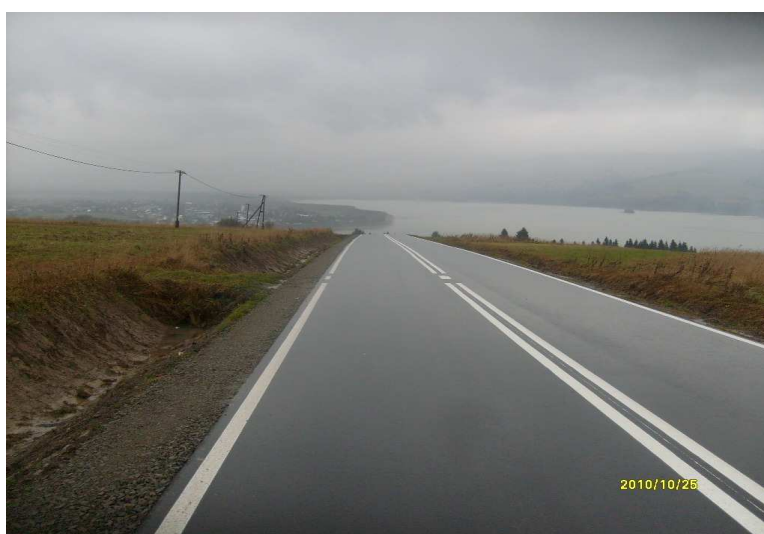
fot. po przebudowie K1639
