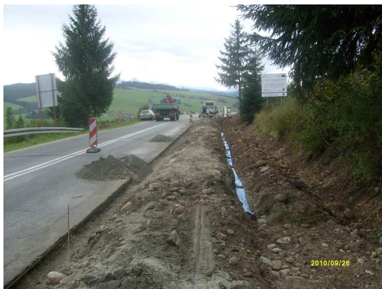
fot. K1639 podczas przebudowy
