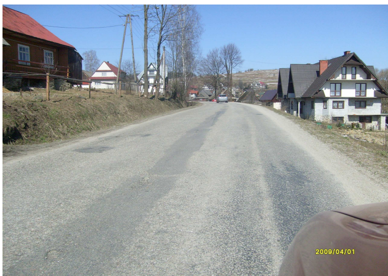
fot. droga K1664 przed przebudową
