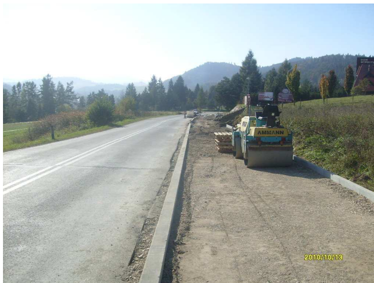
fot. K1639 podczas przebudowy
