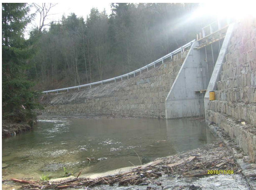
fot. obiekty mostowe po przebudowie
