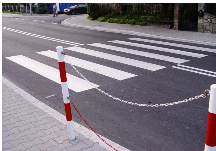
fot. ulica Św. Anny po przebudowie
