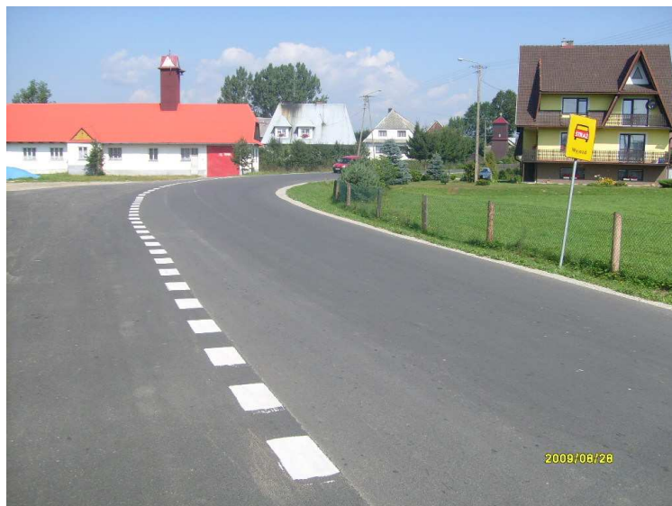
fot. po przebudowie K1676 Lipnica Wielka-Przywarówka
