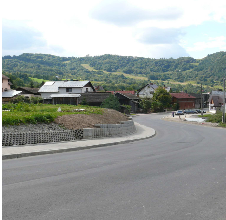
fot. odcinek drogi K1636 po przebudowie
