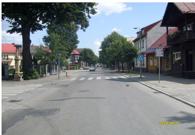
fot. ulica Św. Anny przed przebudową
