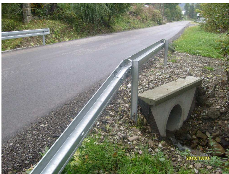
fot. po przebudowie K1667 Rabka – Zdrój – Ponice w m. Ponice
