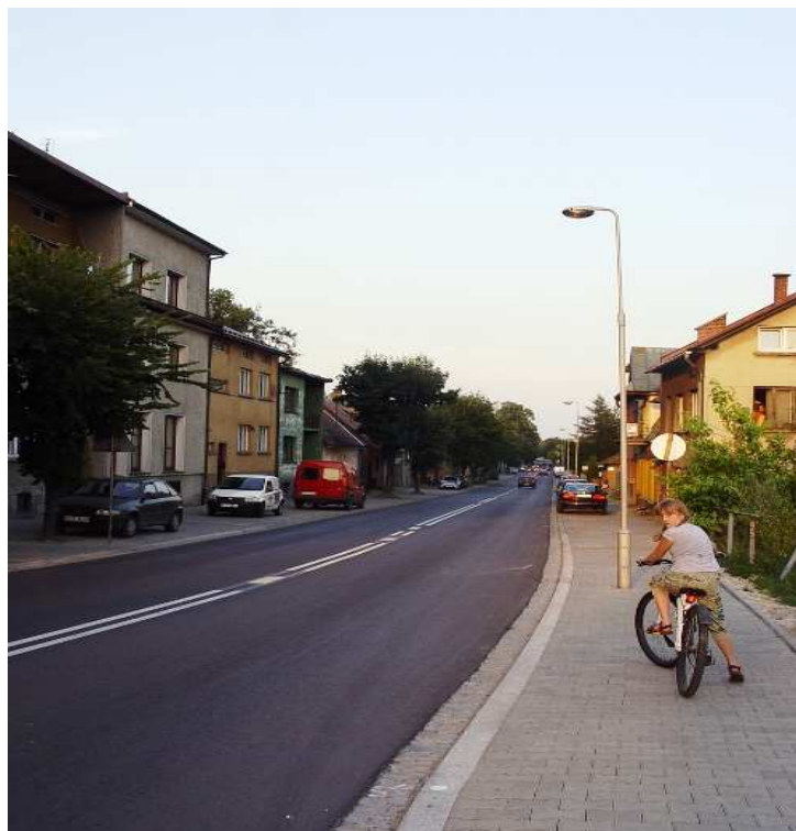
fot. ulica Św. Anny po przebudowie
