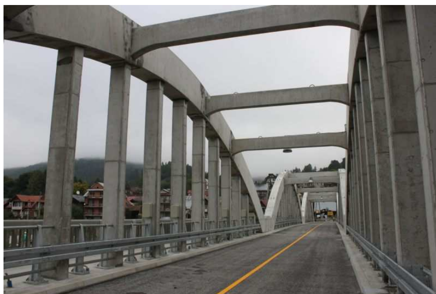
fot. nowy bliźniaczy obiekt mostowy
