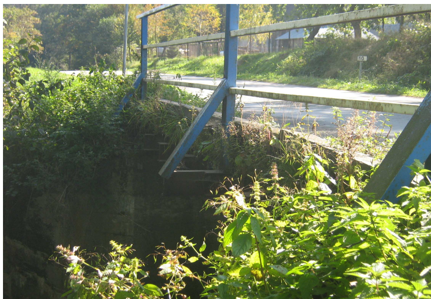
fot. obiekty mostowy przed przebudową
