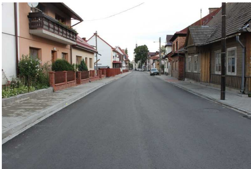
fot. odcinek drogi powiatowej po przebudowie
