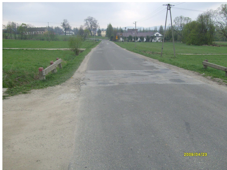
fot. droga K1668 przed przebudową
