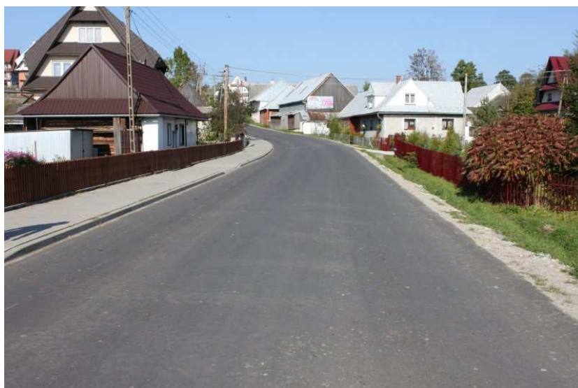
fot. droga K1664 po przebudowie
