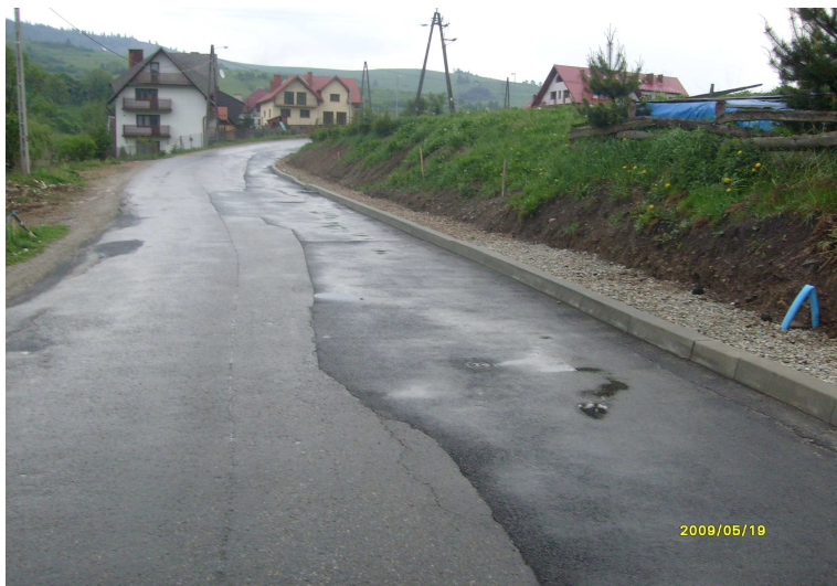
fot. odcinek drogi K1636 przed przebudową
