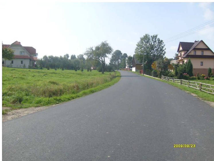
fot. po przebudowie K1665 Skawa-Raba Wyżna
