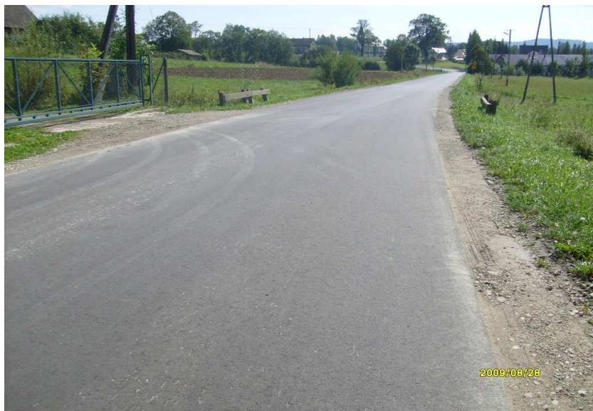
fot. po przebudowie K1668 Rabka-Skawa-Naprawa
