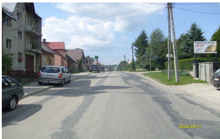
fot. ulica Św. Anny przed przebudową
