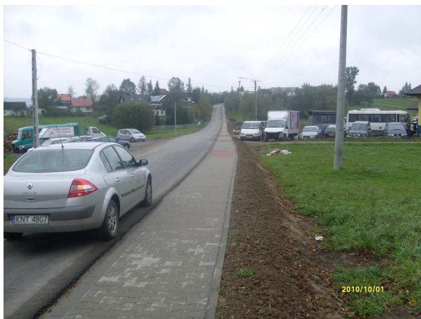
fot. droga K1665 po przebudowie
