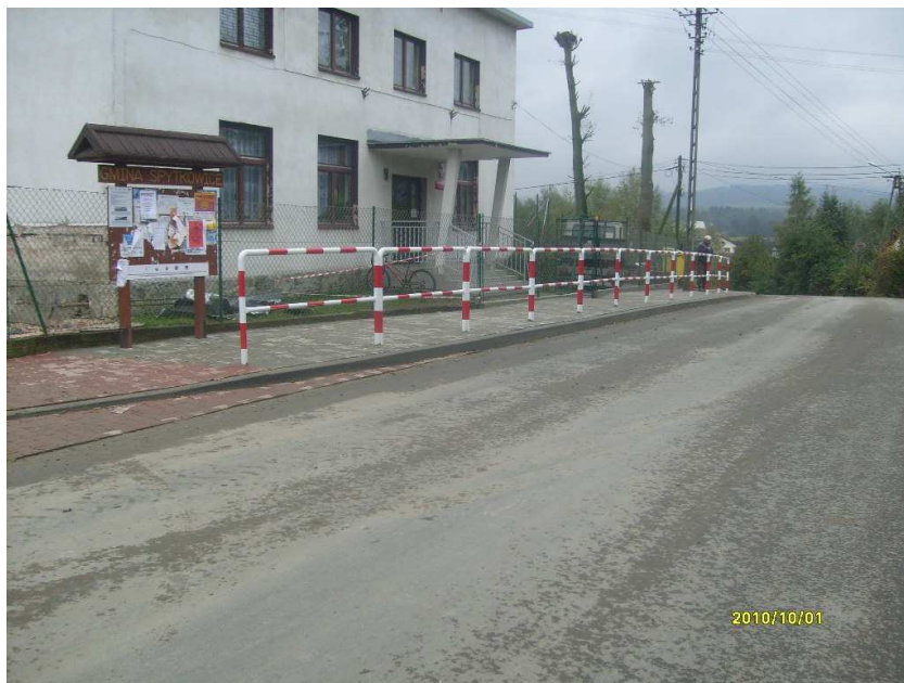
fot. droga K1665 po przebudowie
