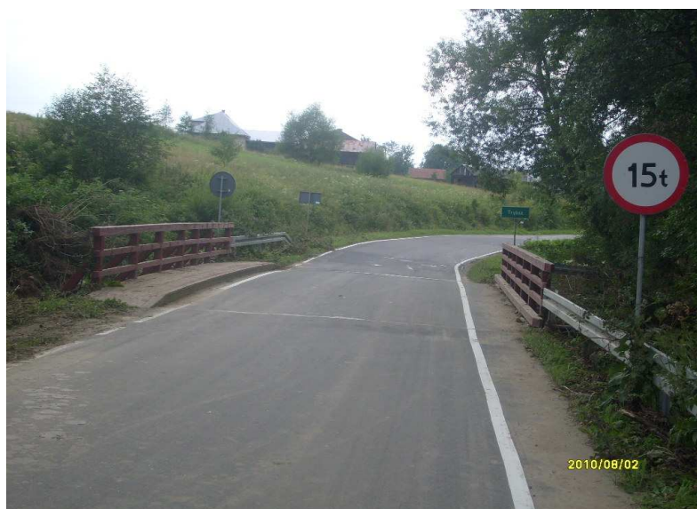
fot. obiekt mostowy do przebudowy K1642 Groń – Trybsz – Niedzica w km 5+050 na Trybskiej Rzece
