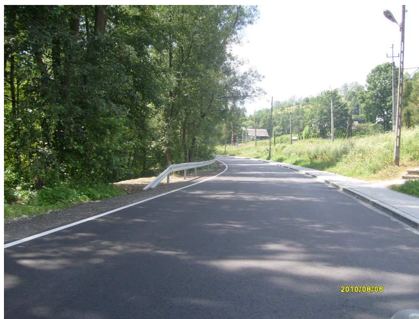
fot. po przebudowie K1662 Raba Wyżna-Klikuszowa
