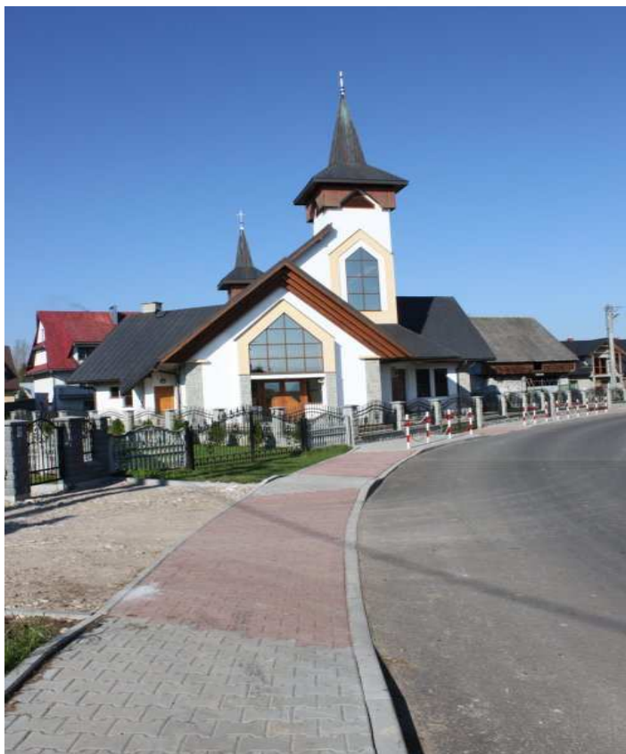
fot. droga K1659 po przebudowie
