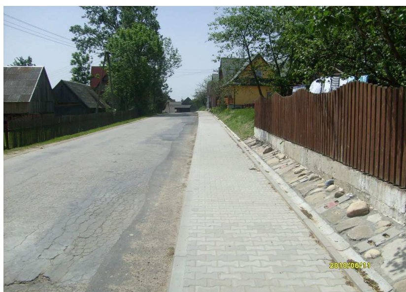
fot. odcinek drogi powiatowej po przebudowie w m. Załuczne
