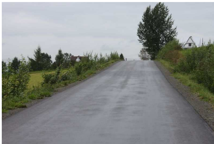
fot. Odbudowa drogi powiatowej nr K1654 Ząb-Ratulów-Ciche-Chochółów od km 8+340 do km 9+570
