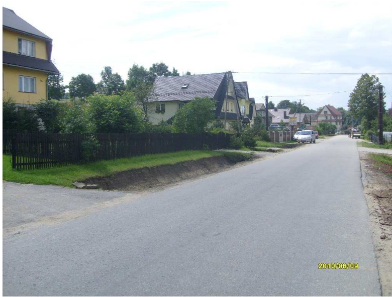
fot. odcinek drogi K1678 przed przebudową
