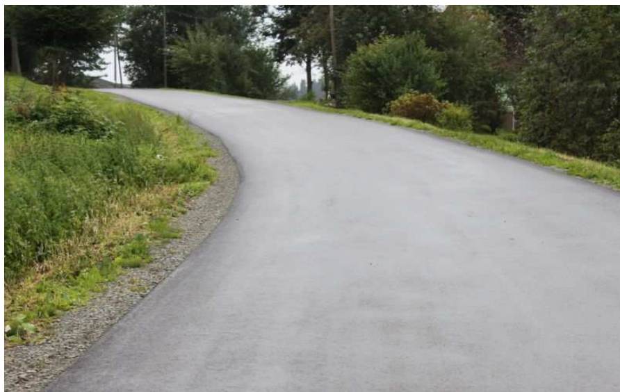
fot. Odbudowa drogi powiatowej nr K1654 Ząb-Ratulów-Ciche-Chochółów od km 8+340 do km 9+570
