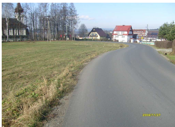
fot. droga K1665 przed przebudową
