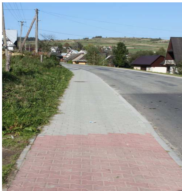
fot. droga K1664 po przebudowie – wykonanie chodnika
