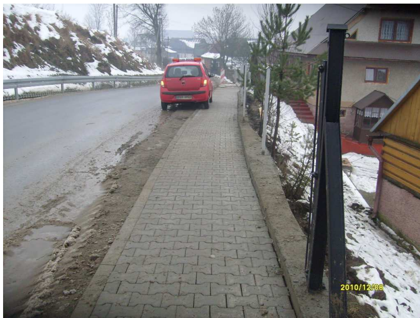
fot. droga K1659 po przebudowie
