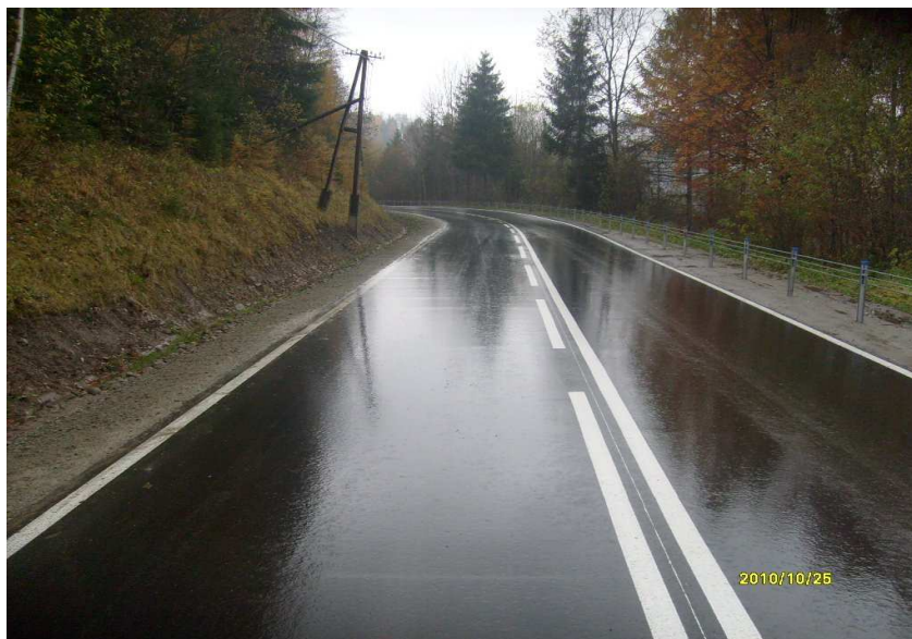
fot. po przebudowie K1639
