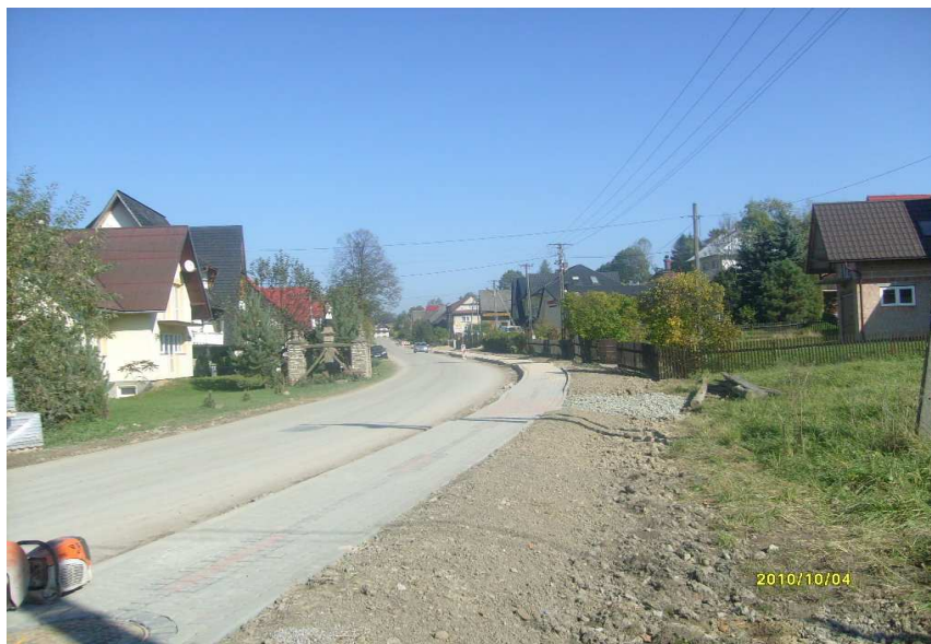
fot. odcinek drogi K1678 w czasie przebudowy
