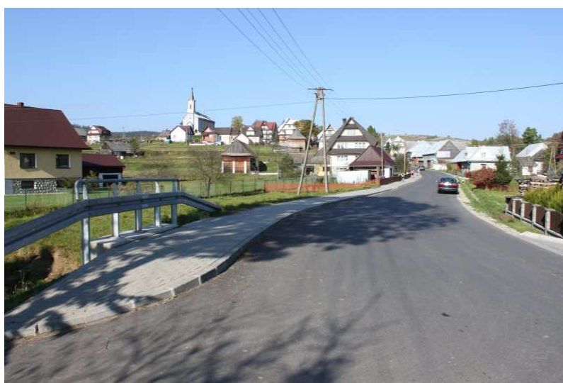
fot. droga K1664 po przebudowie
