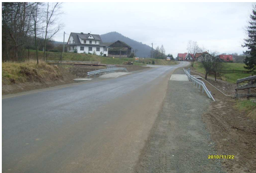
fot. obiekty mostowe po przebudowie
