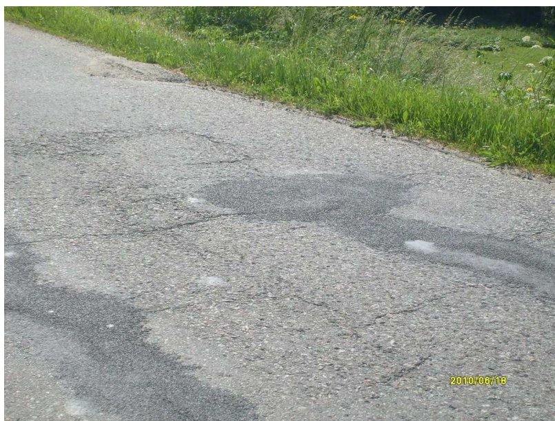
fot. przed przebudową K1639
