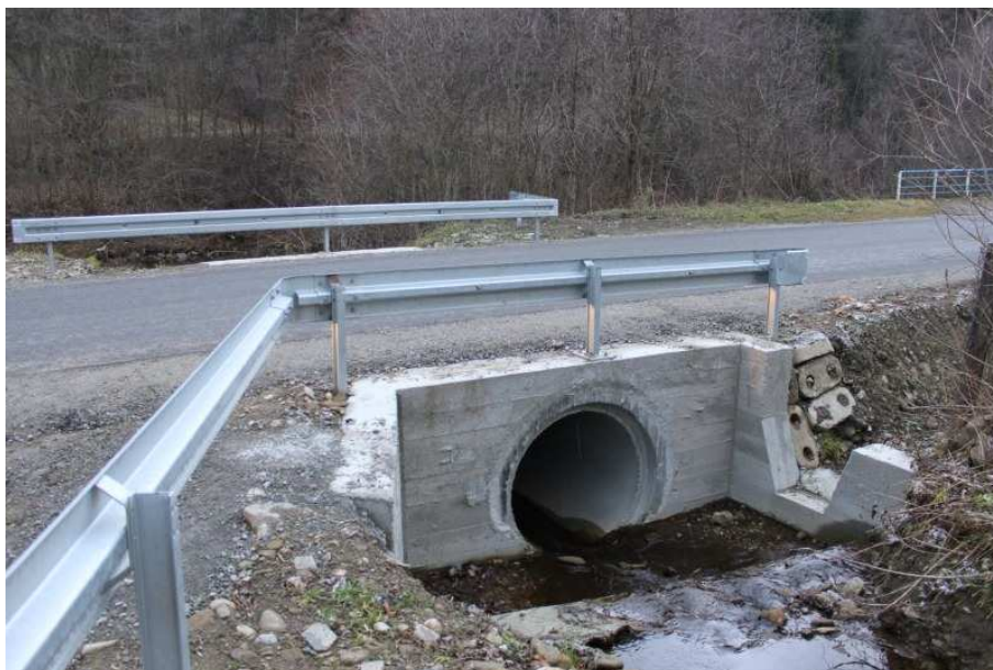
fot. Odbudowa drogi powiatowej nr K1661 Trute-Klikuszowa-Obidowa od km 3+700 do km 9+090
