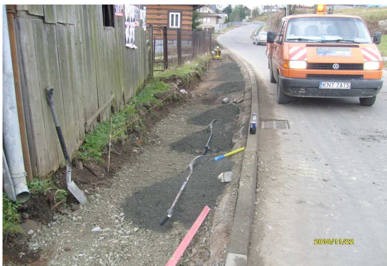
fot. odcinek drogi K1659 podczas przebudowy
