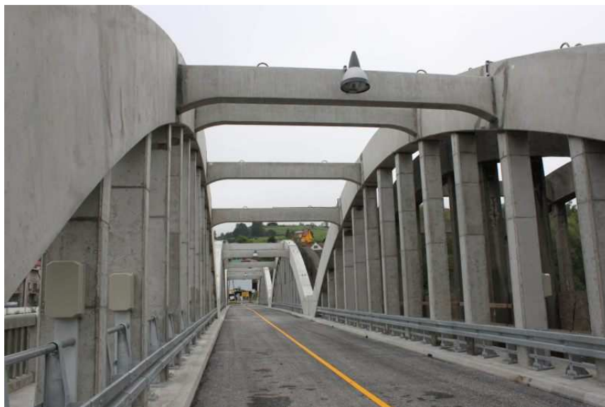
fot. nowy bliźniaczy obiekt mostowy
