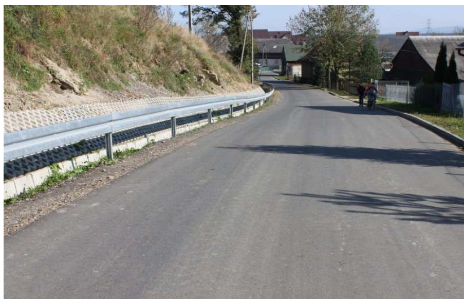
fot. droga K1659 po przebudowie
