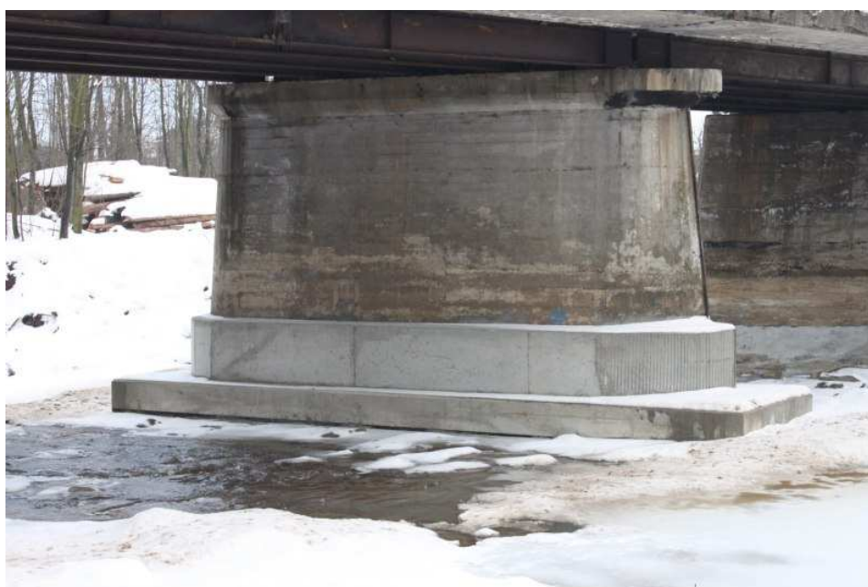
fot. Remont mostu na potoku Lepietnica w km 2+963 drogi powiatowej nr K1661 Trute-Klikuszowa-Obidowa.
