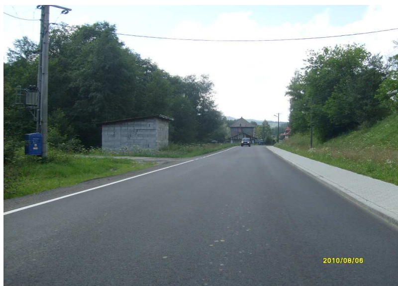
fot. po przebudowie K1662 Raba Wyżna-Klikuszowa
