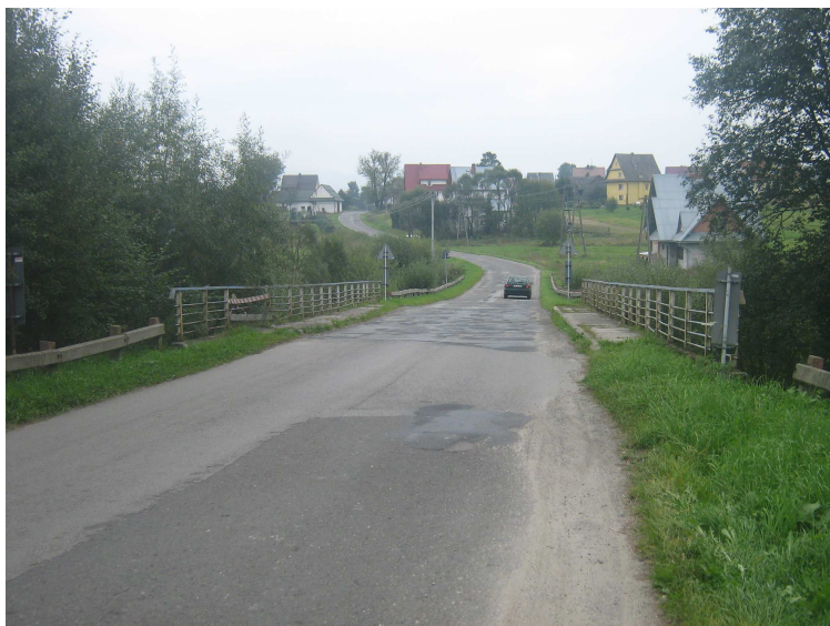
fot. obiekt mostowy do przebudowy K1668 Rabka – Skawa – Naprawa w km 7+670 na rzece Skawa
