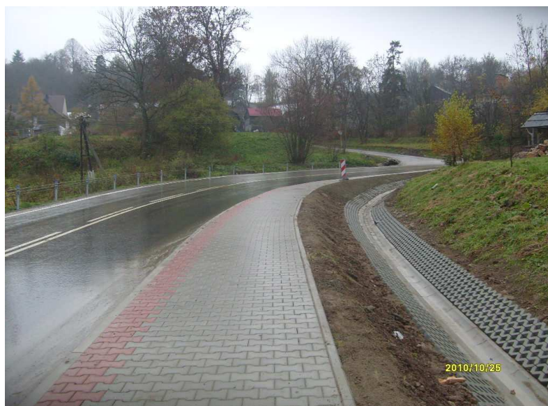
fot. po przebudowie K1639
