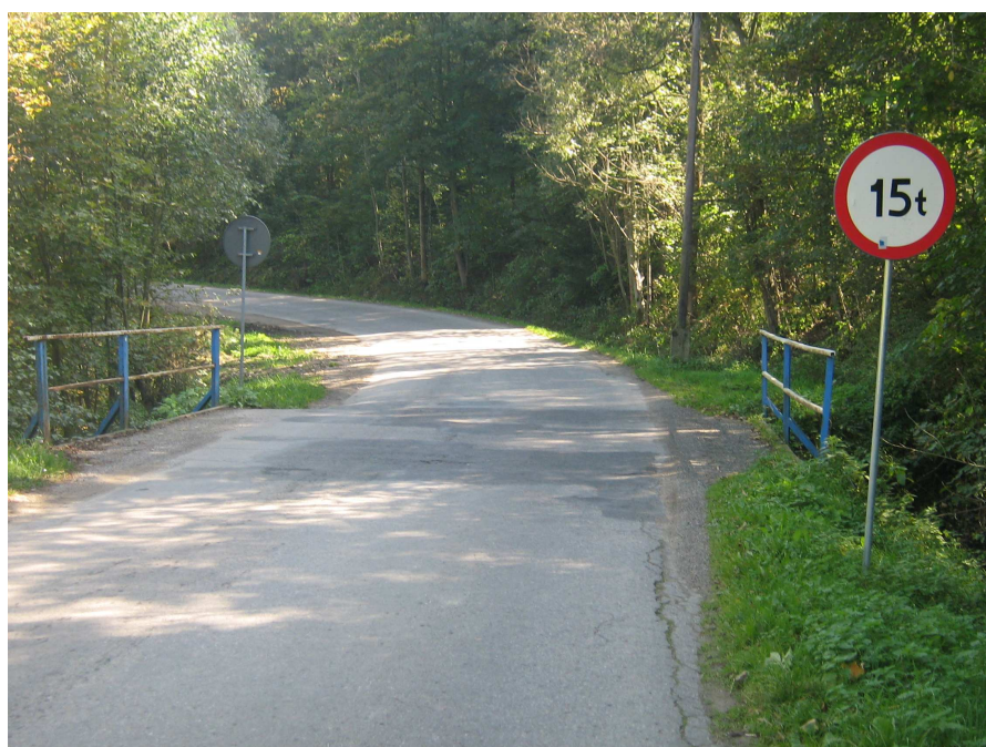
fot. obiekty mostowy przed przebudową
