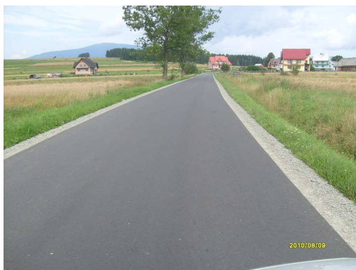
fot. droga K1675 po przebudowie
