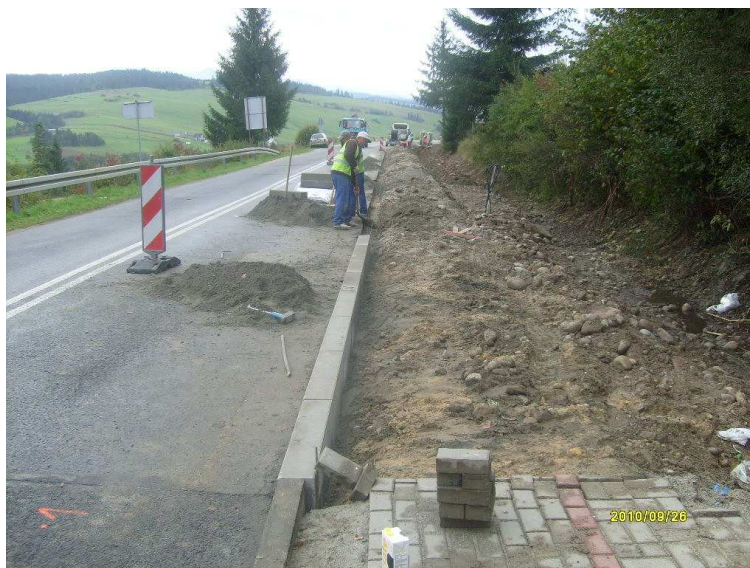
fot. K1639 podczas przebudowy
