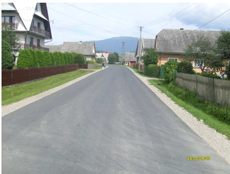
fot. droga K1676 po przebudowie
