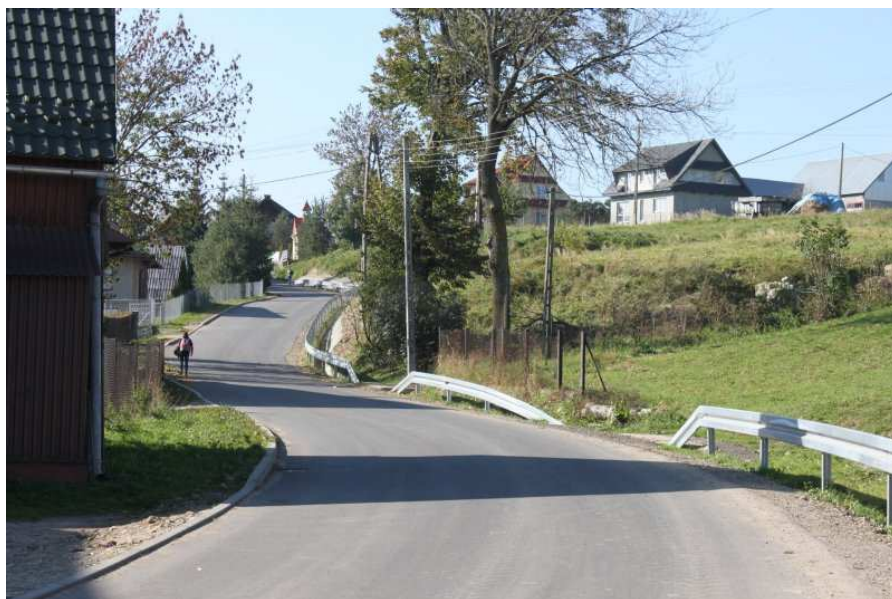
fot. droga K1659 po przebudowie
