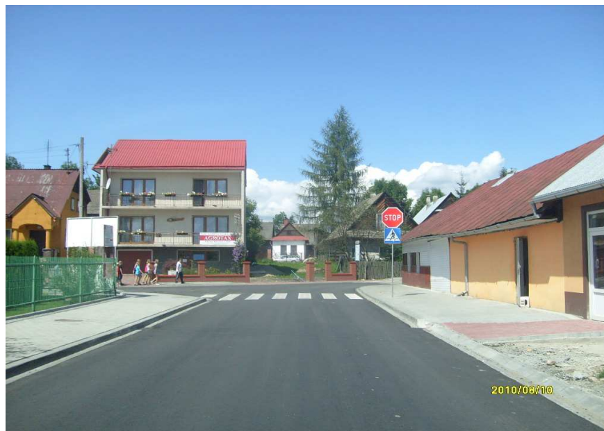
fot. odcinek drogi powiatowej po przebudowie
