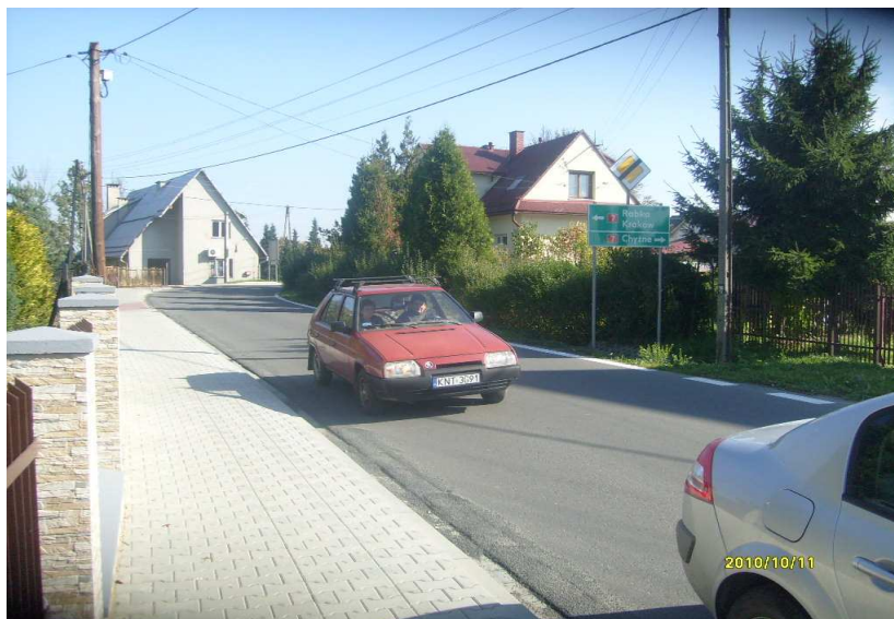
fot. droga K1665 po przebudowie
