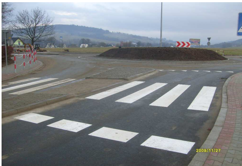
fot. po przebudowie K1651 – rondo wraz z dojazdami w m. Ciche w km ok. 6+808
