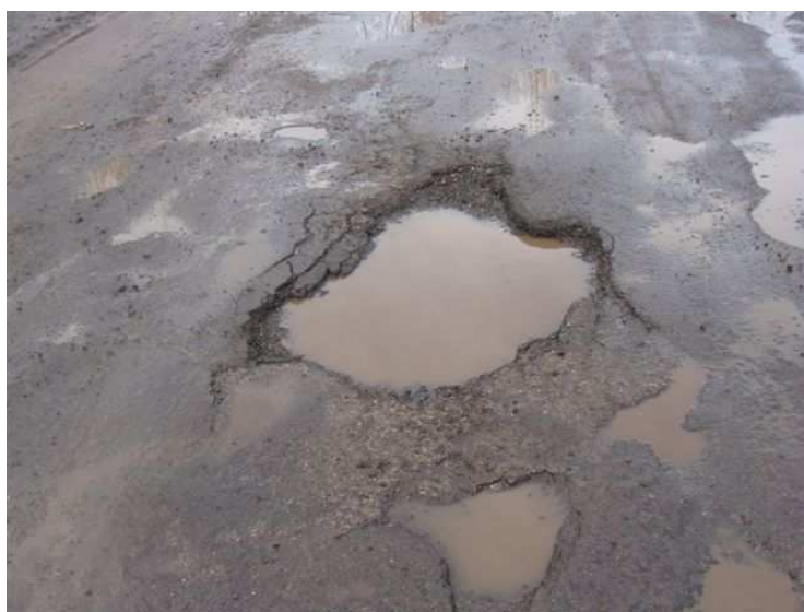
fot. przed przebudową K1667 Rabka – Zdrój – Ponice w m. Ponice
