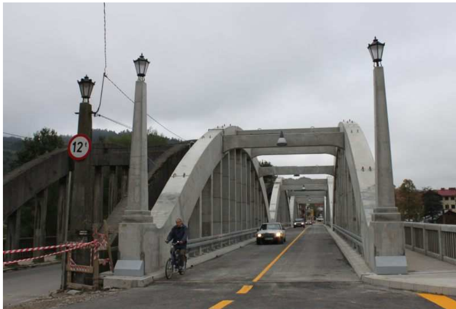
fot. nowy bliźniaczy obiekt mostowy
