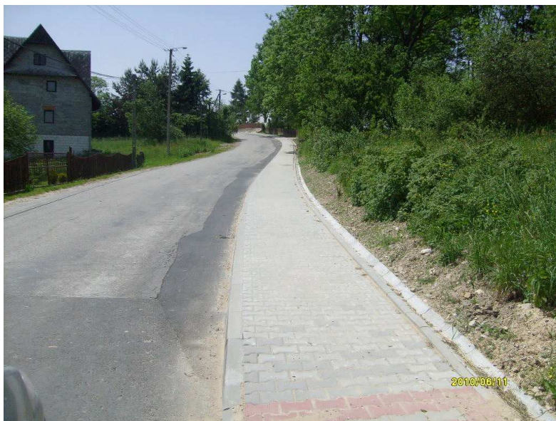
fot. odcinek drogi powiatowej po przebudowie w m. Załuczne
