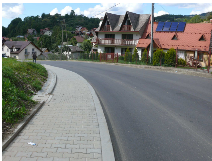
fot. odcinek drogi K1636 po przebudowie
