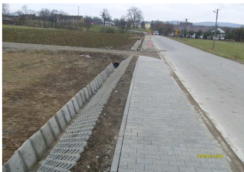
fot. droga K1668 w czasie przebudowy
