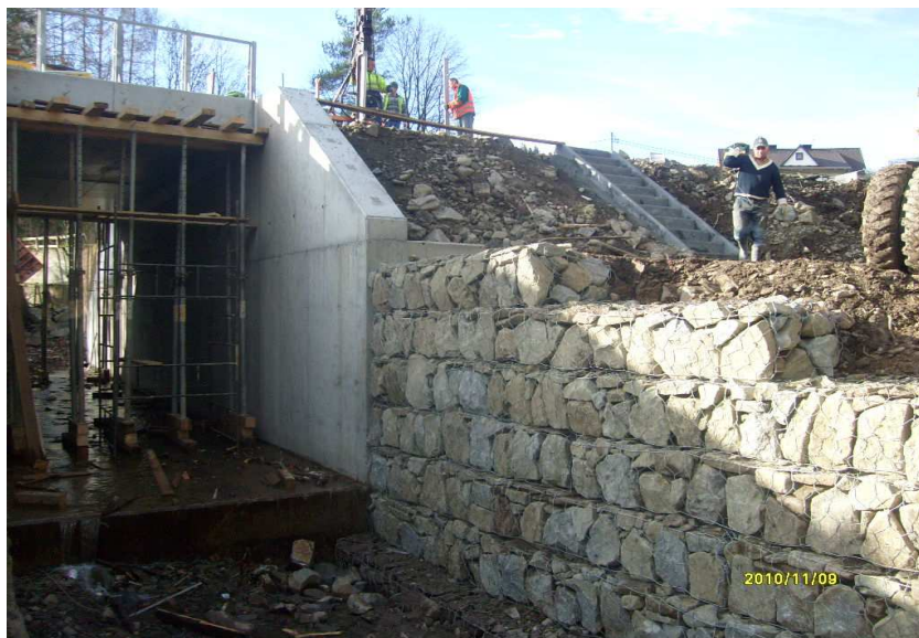
fot. obiekty mostowe w trakcie przebudowy
