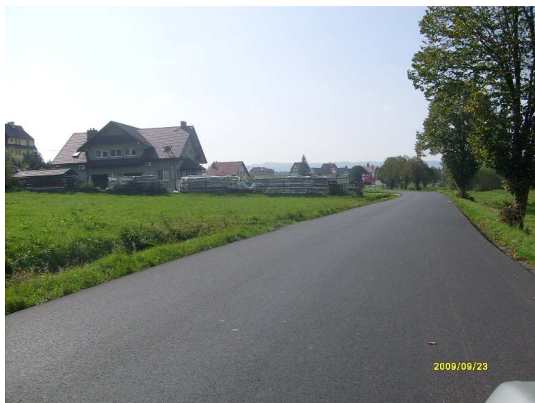
fot. po przebudowie K1665 Skawa-Raba Wyżna
