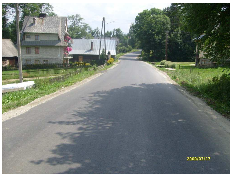
fot. po przebudowie K1651 Czarny Dunajec-Poronin
