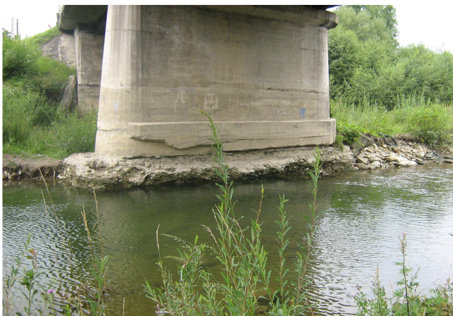
fot. obiekt mostowy na potoku Lepietnica w km 2+963 drogi powiatowej nr K1661 Trute-Klikuszowa-Obidowa przed remontem
