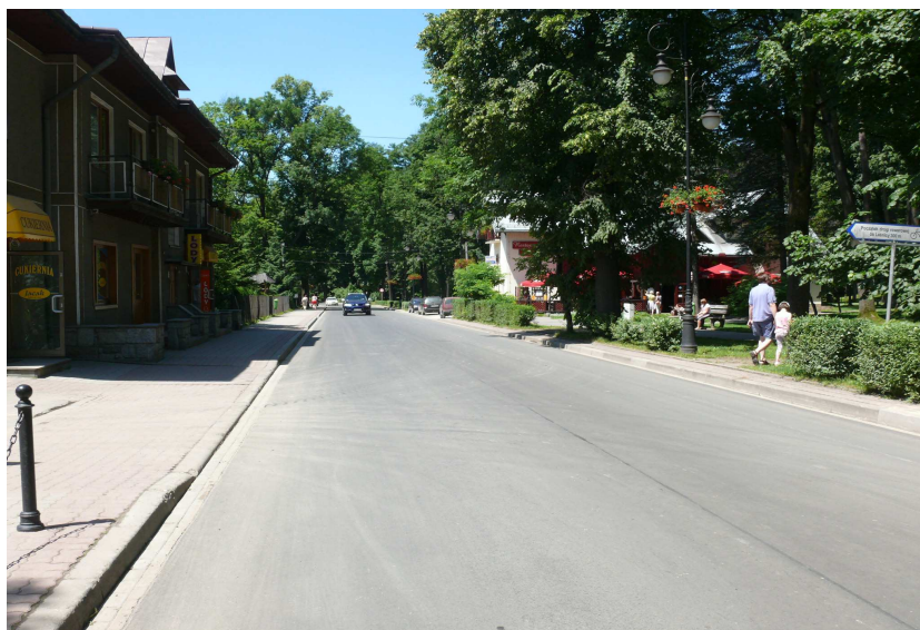
fot. odcinek drogi K1636 po przebudowie
