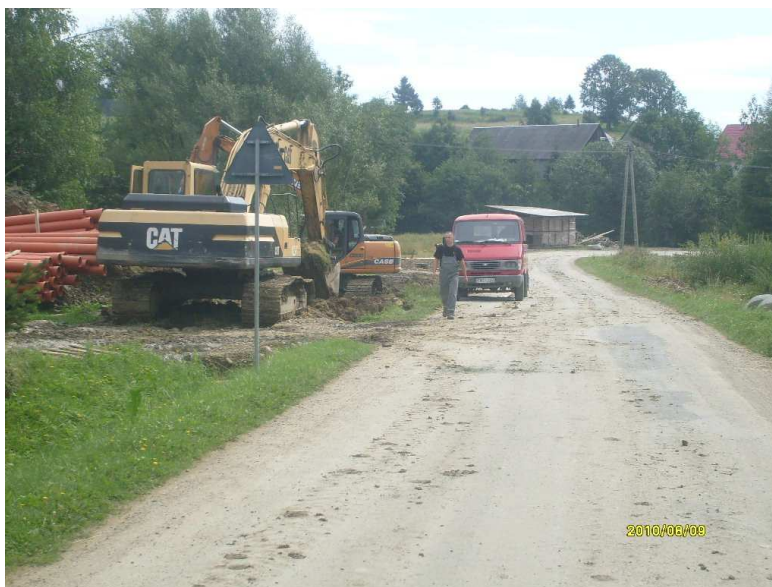
fot. droga K1676 przed przebudową
