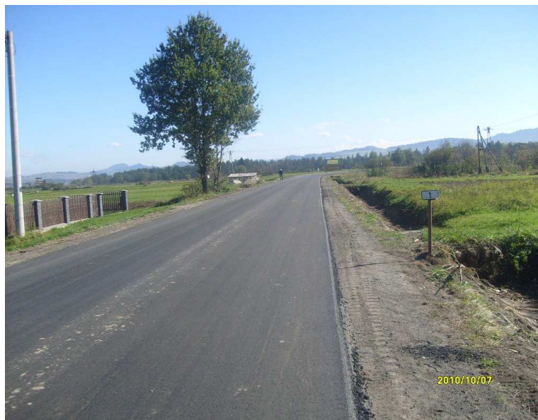
fot. K1639 podczas przebudowy
