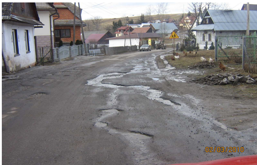
fot. droga K1659 przed przebudową
