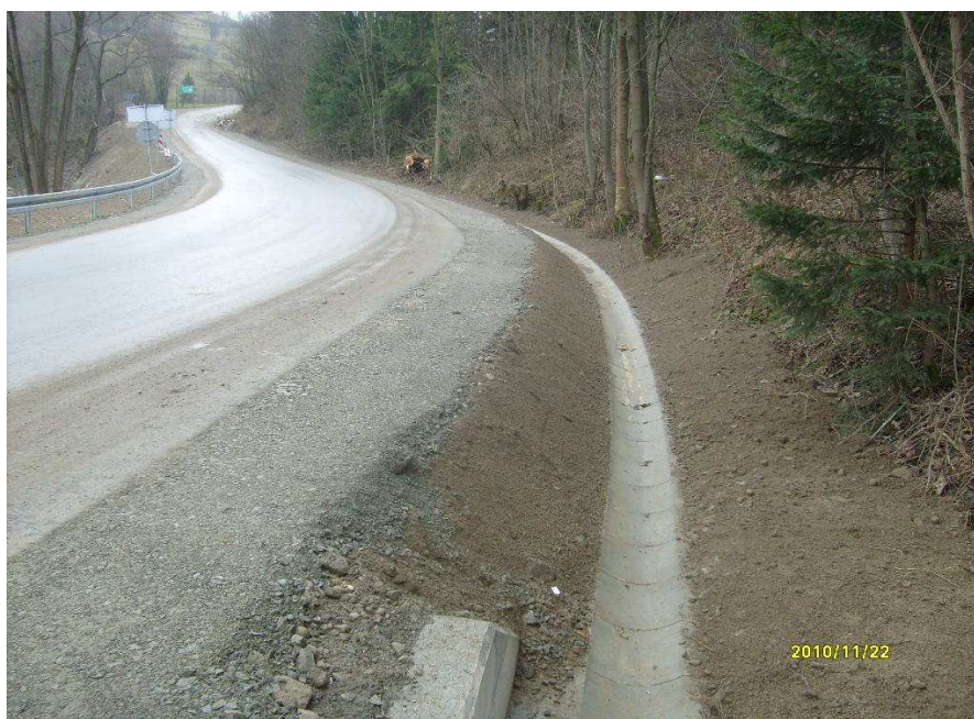
fot. odcinek drogi K1636 po przebudowie
