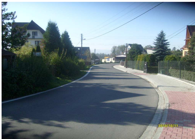
fot. droga K1665 po przebudowie
