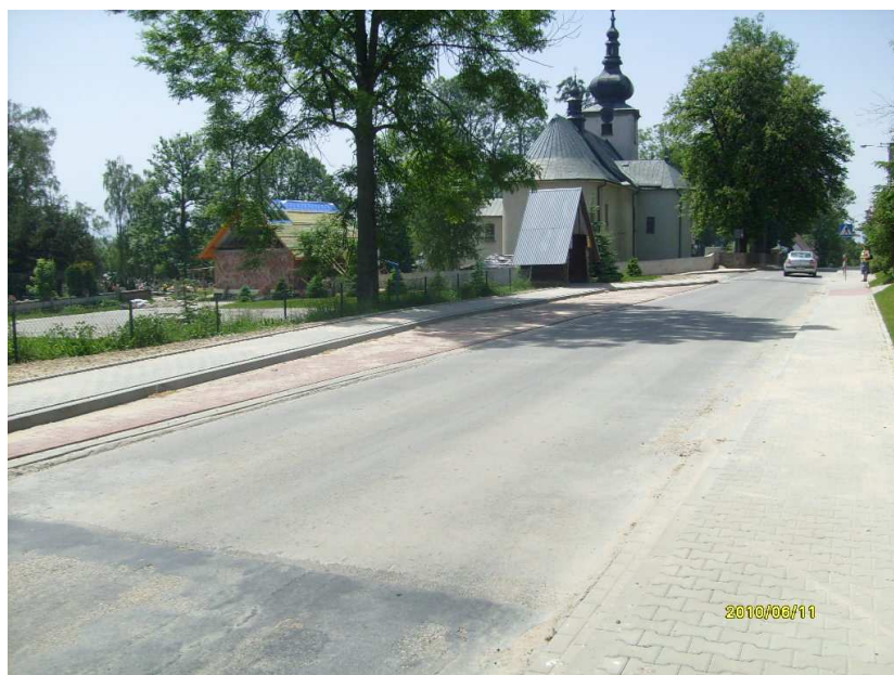
fot. odcinek drogi powiatowej po przebudowie w m. Odrowąż
