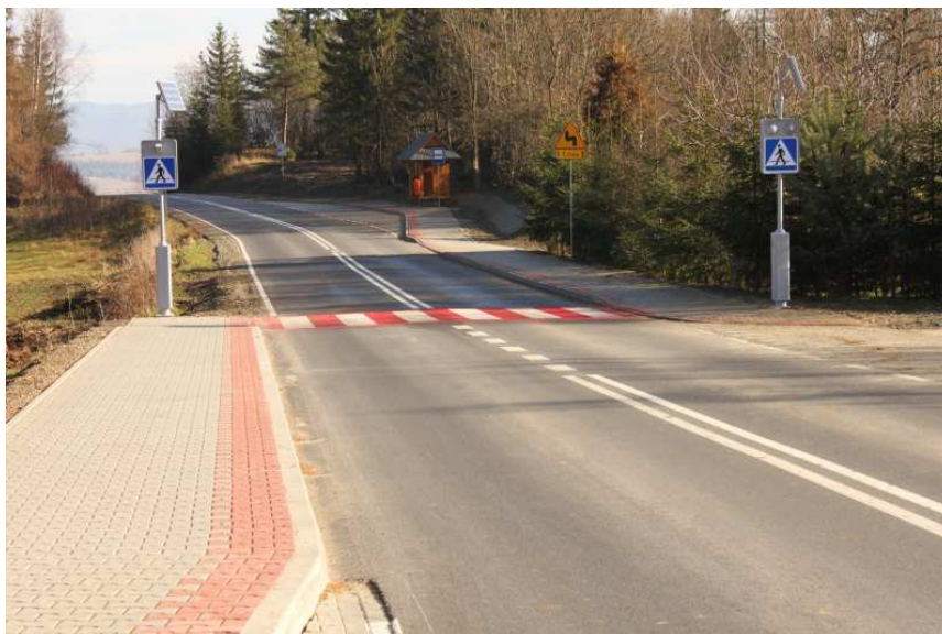
fot. po przebudowie K1639
