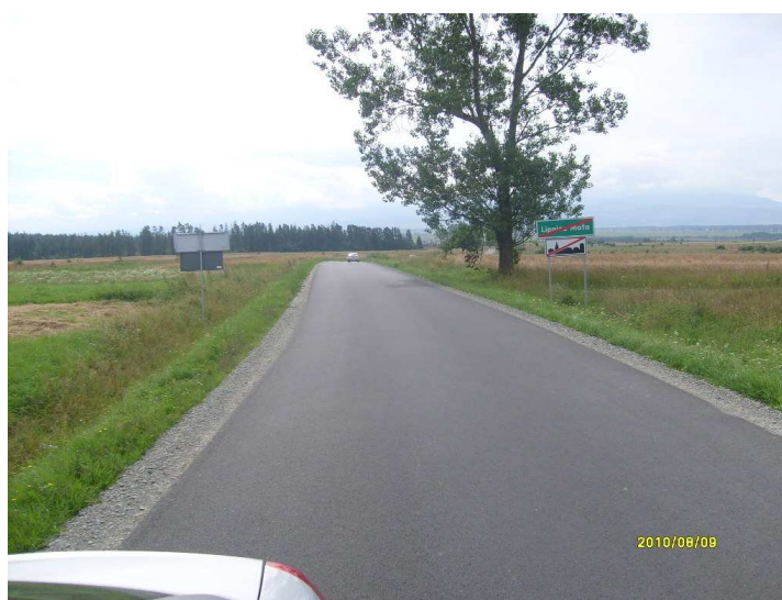
fot. droga K1675 po przebudowie
