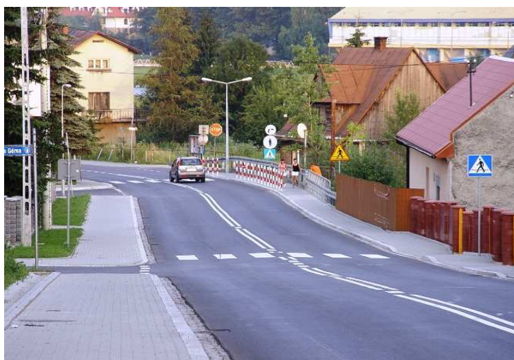
fot. ulica Św. Anny po przebudowie
